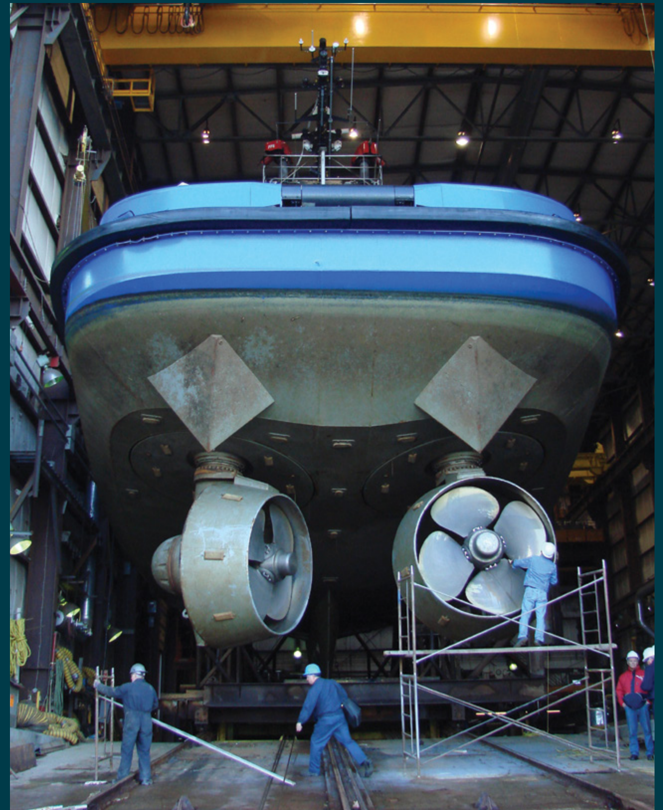
Photo : Sodes – Groupe Océan, Z-drive repair
