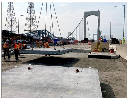
Figure 4 – Pose d'une dalle Super-Slab sur Henri IV, à Québec, en 2021
