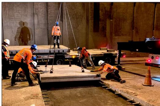
Figure 3 – Pose d'une dalle Super-Slab sur l'autoroute 15 (Décarie), à Montréal, en 2021
