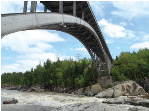
■ Profil amont du pont d'aluminium en direction de Saguenay (auparavant Arvida), avant les travaux de réfection. Source : Photothèque du ministère des Transports, de la Mobilité durable et de l'Électrification des transports
