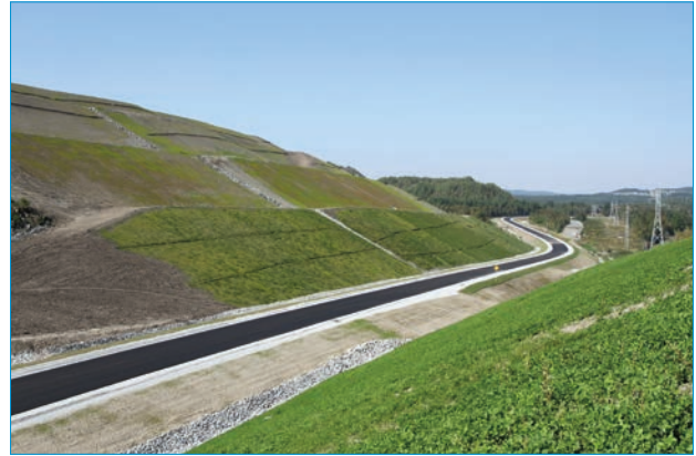
■ Vue du nouveau tronçon de la route 112 reliant Thetford Mines et Saint-Joseph-de-Coleraine. Source : Photothèque du ministère des Transports, de la Mobilité durable et de l'Électrification des transports
