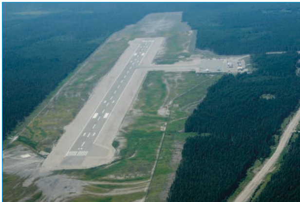
■ Vue aérienne de la piste d'atterrissage de l'aéroport de Port-Menier, sur l'île d'Anticosti. Source : Ministère des Transports, de la Mobilité durable et de l'Électrification des transports
