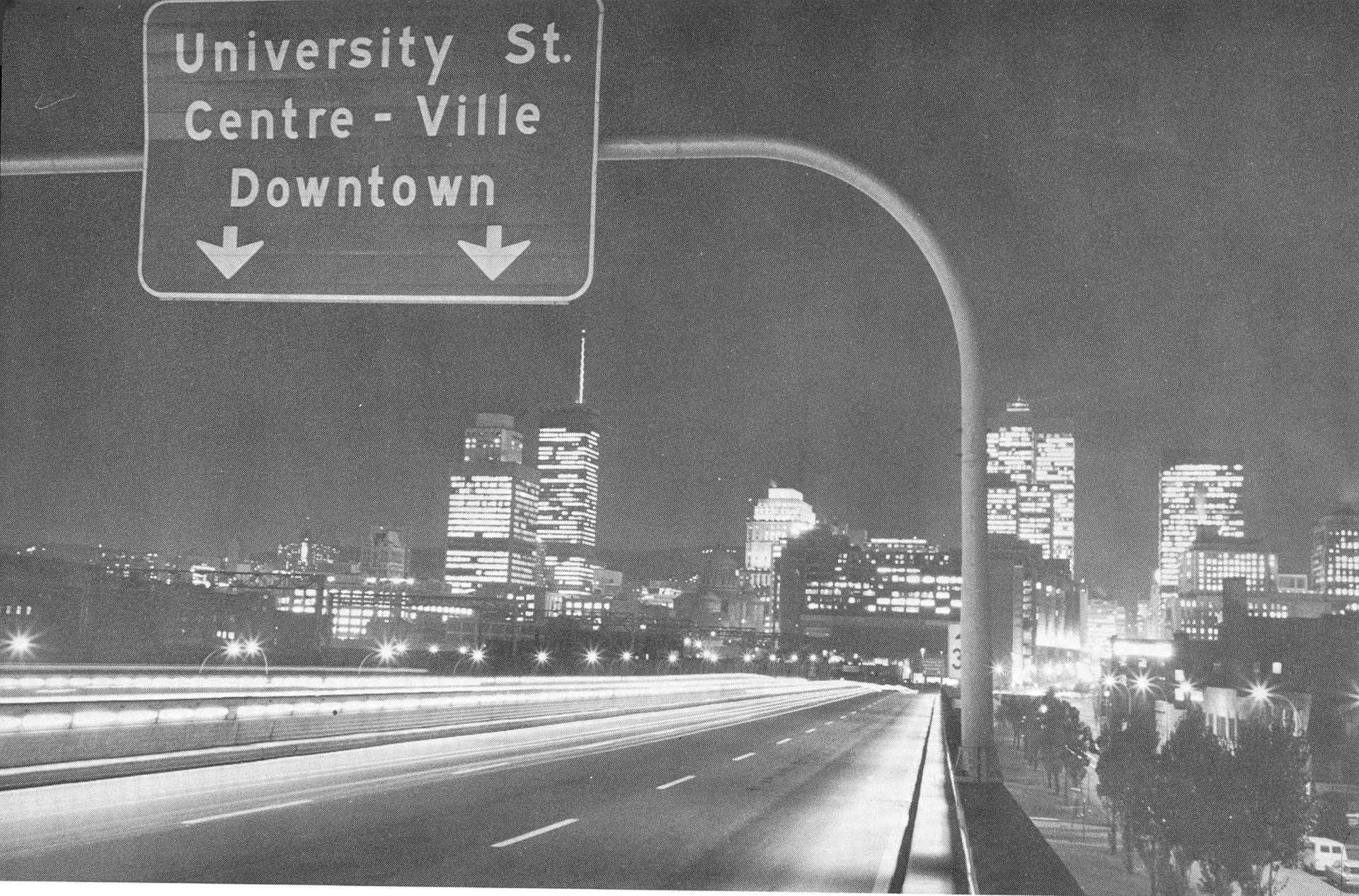
L'autoroute Bonaventure pénètre au coeur même du centre-ville de Montréal.
