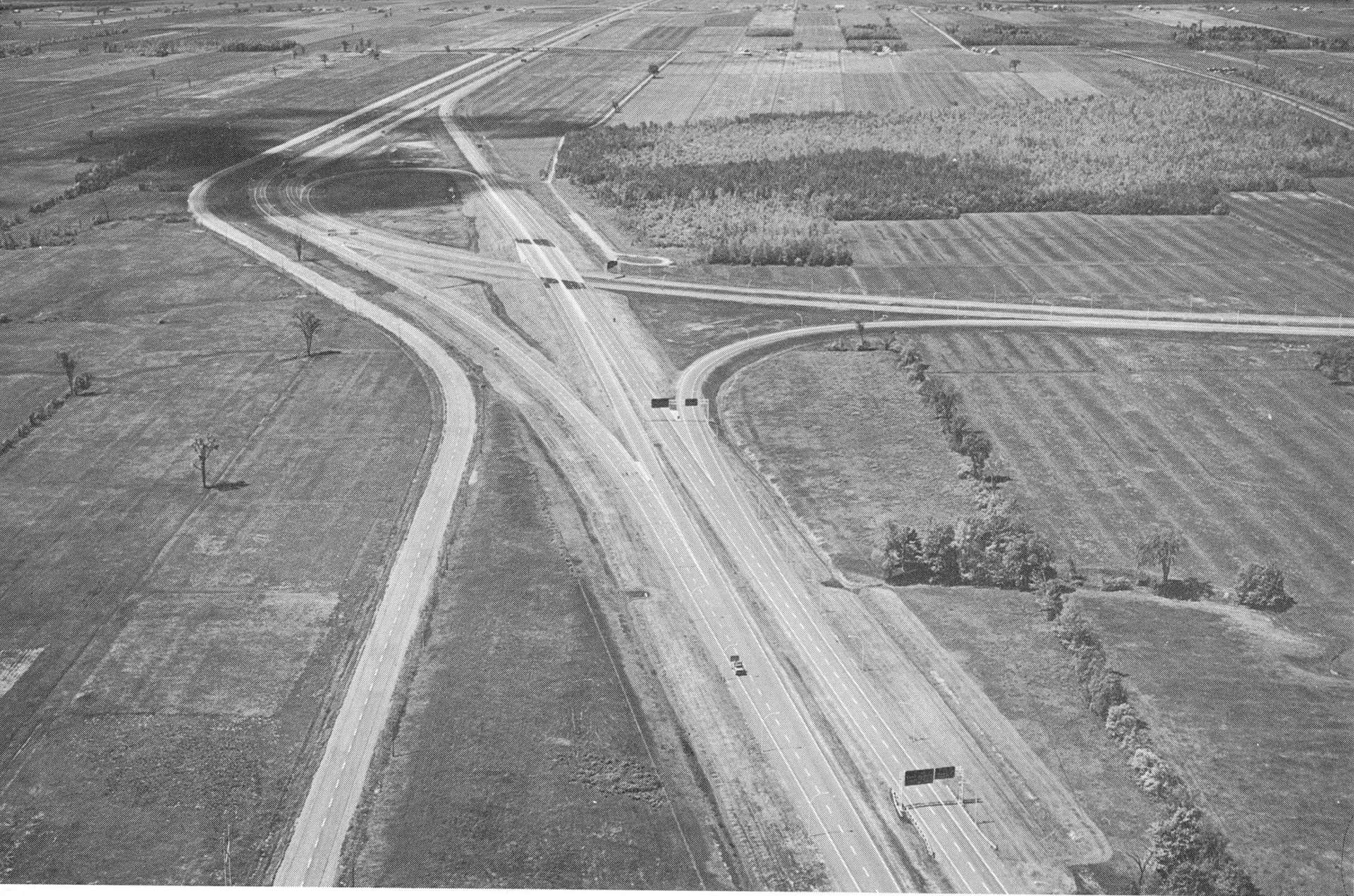
L'autoroute 20 dans l'ouest de l'île de Montréal à la jonction du carrefour de l'autoroute 540.
