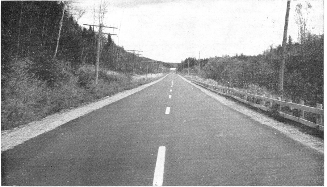
Section de 9 milles, asphaltée entre Ferland et Grande-Baie sur la route No 56.
