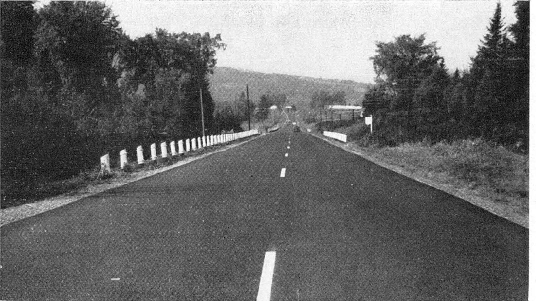
Renouvellement du revêtement d'asphalte dans le canton Ascot, sur la route No 5.
