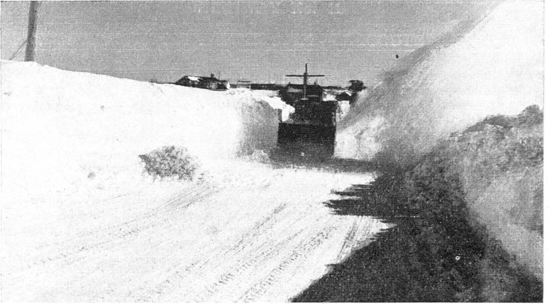
Déneigement de la route No 6, à Bridgeville, en Gaspésie, après une grosse tempête de neige au cours de l'hiver 1955-1956.
