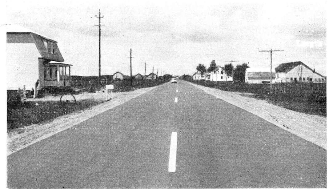
Route No 55, entre Normandin et Saint-Méthode, reconstruite et asphaltée en 1955.
