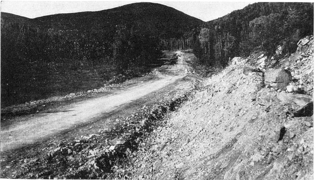
Travaux de gravelage exécutés sur la nouvelle route Sainte-Anne-des-Monts—New-Richmond.
