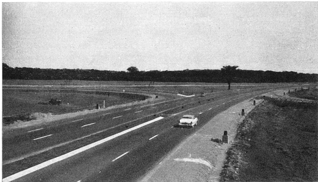
Vue de la nouvelle route construite à Coteau-du-Lac, de 1953 à 1955.
