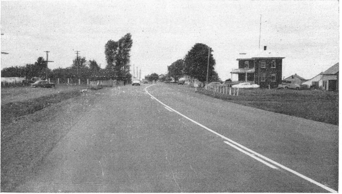
Route No 5. Nouvelle section de 3 milles, construite et asphaltée à Sainte-Victoire, comté d'Arthabaska.
