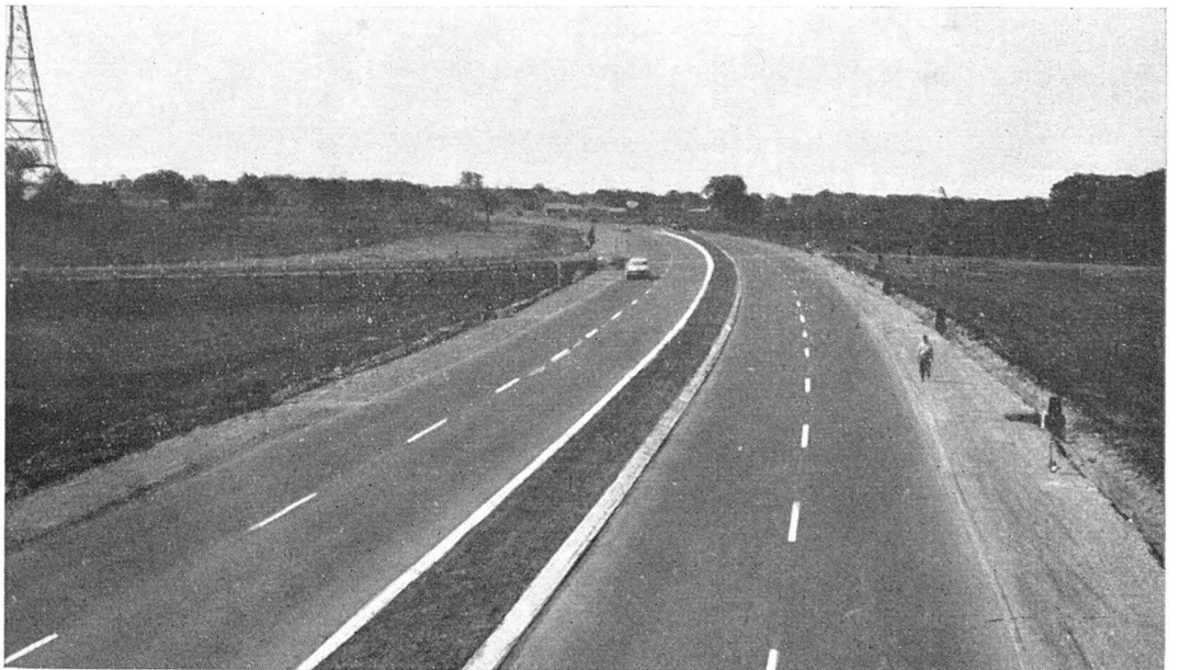
Route à voies divisées, construite et asphaltée aux approches du pont Monseigneur Langlois à Coteau-du-Lac.
