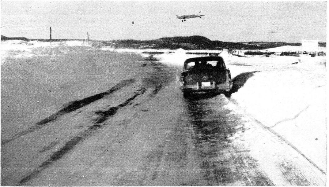
Route No 15, Hauterive—Baie-Comeau. Entretien au cours de l'hiver 1955-1956.
