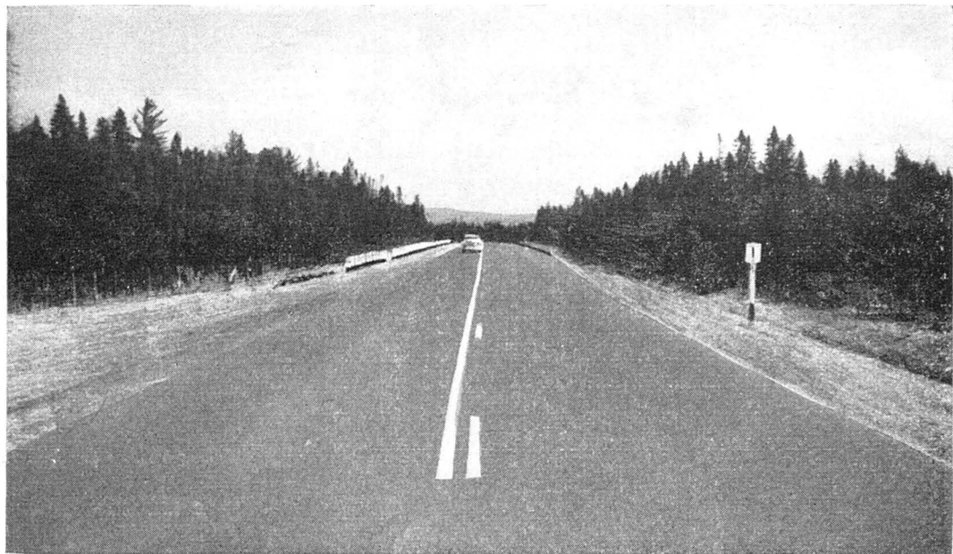
Route No 1. Nouvelle section construite et asphaltée à Thetford Mines.
