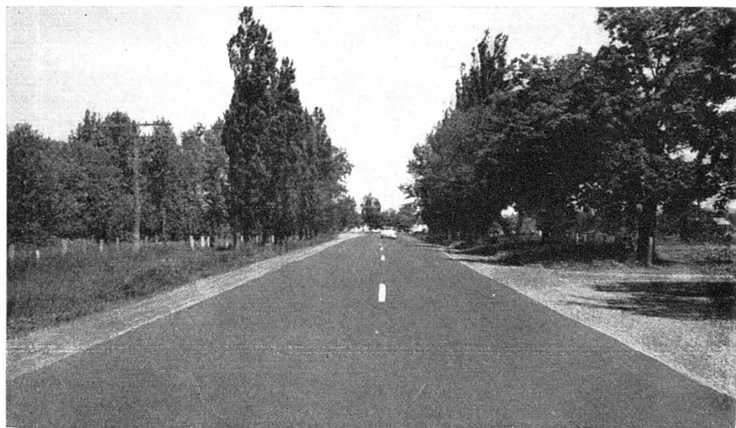
Revêtement d'asphalte refait sur une longueur de 21 milles entre Saint-Roch-des-Aulnets et l'Islet sur la route No 2.
