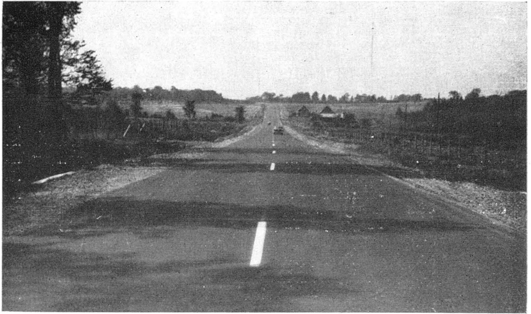
Route Magog—Coaticook reconstruite sur une longueur de 5 milles à Barston.
