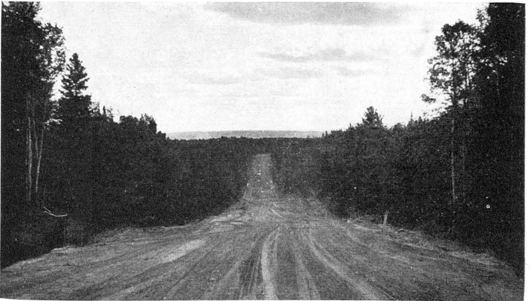
Travaux de gravelage exécutés sur une autre section de la route No 15, à Saint-Joachim.
