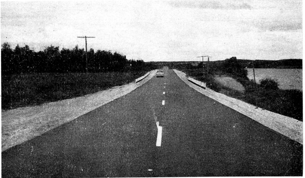
Section de 9 milles à Péribonca, asphaltée en 1955, sur la route du Lac Saint Jean.
