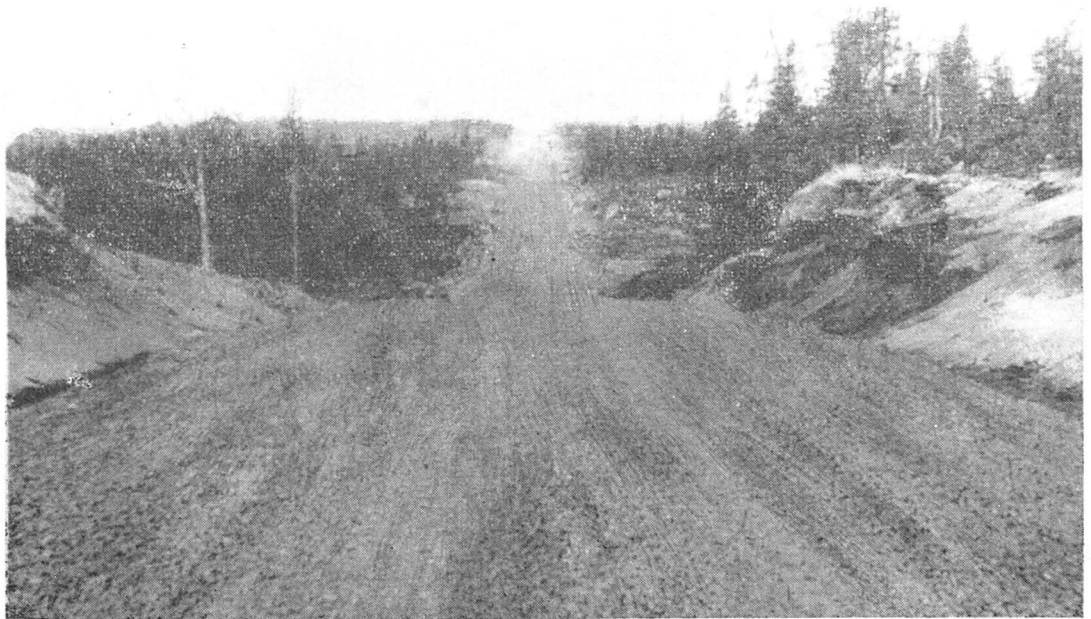
Travaux de gravellage sur la nouvelle route Sept-Iles—Baie-Comeau, au cours de 1955, entre Shelter Bay et la rivière Pentecôte.
