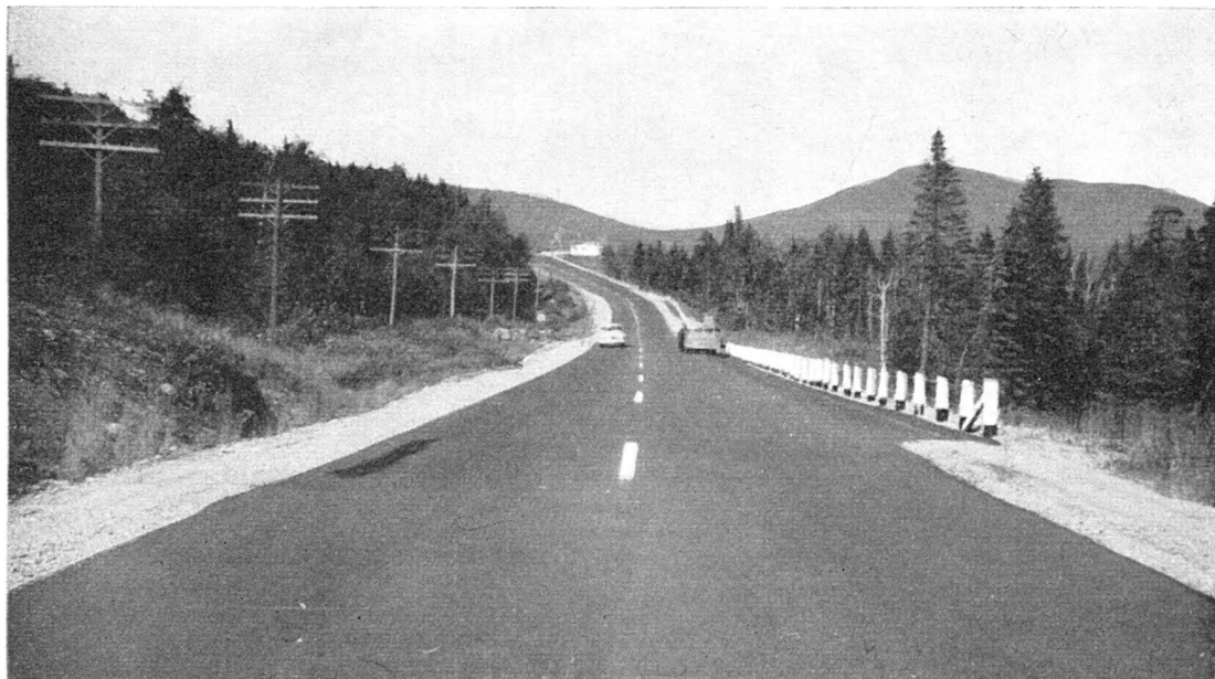
Vue montrant une section reconstruite et asphaltée à Saint-François-Xavier-de-la-Petite-Rivière, sur la route No 15.
