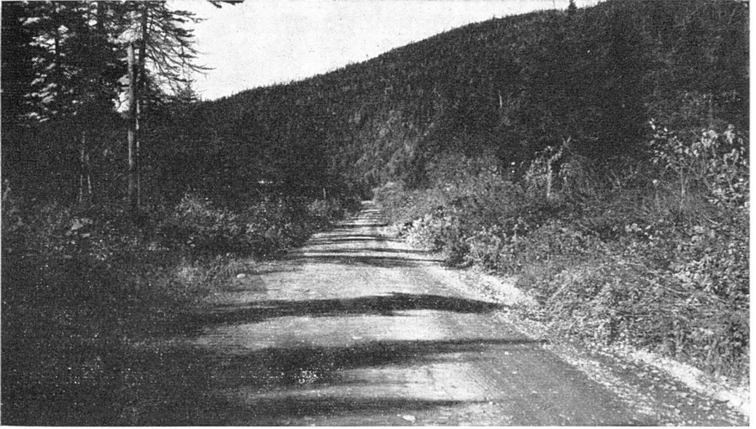
Section de la route transgaspésienne avant sa reconstruction.
