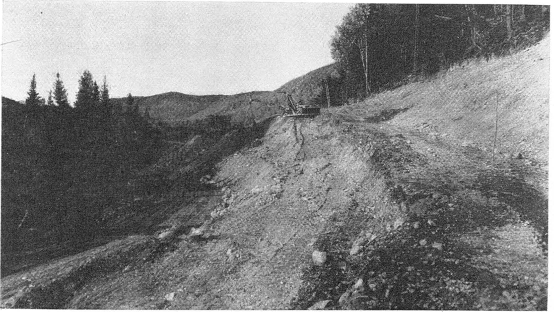
Travaux de terrassement exécutés, en 1955, sur la nouvelle route transgaspésienne.
