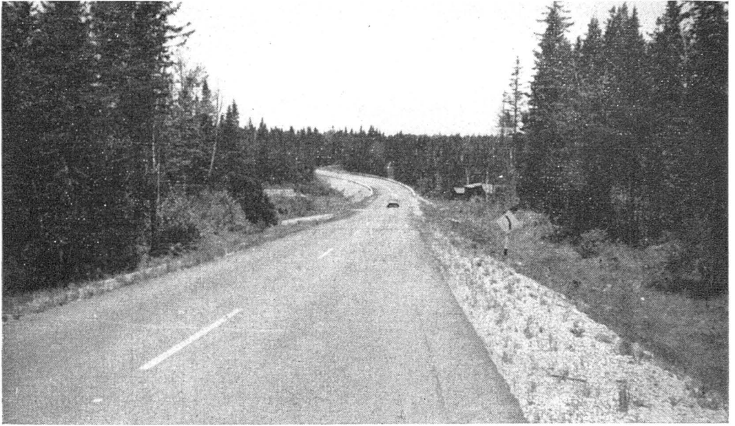
Route Montmagny—Saint-Fabien-de-Panet. Section reconstruite et asphaltée en 1955.
