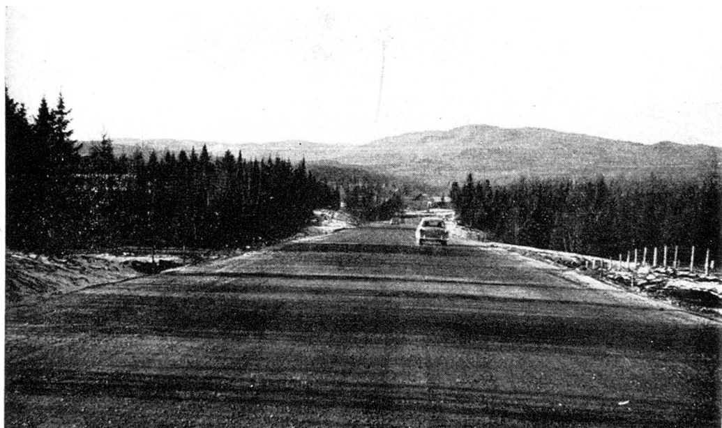
Route No 54, Notre-Dame-des-Laurentides—Stoneham. Travaux de gravelage terminés en 1955.
