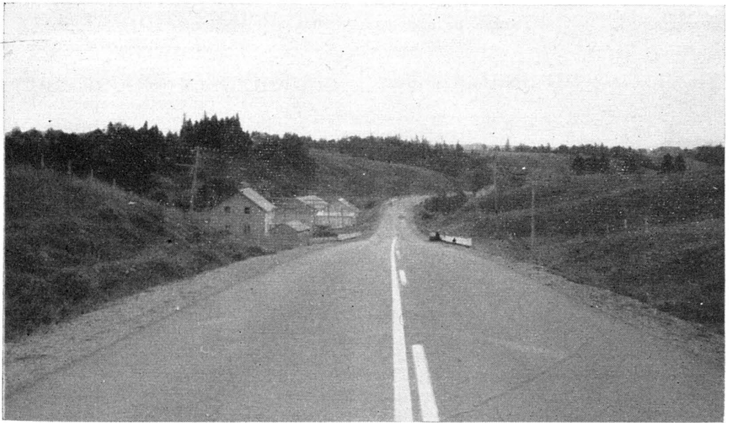
Route No 55, à Hébertville. Section reconstruite et asphaltée en 1955.
