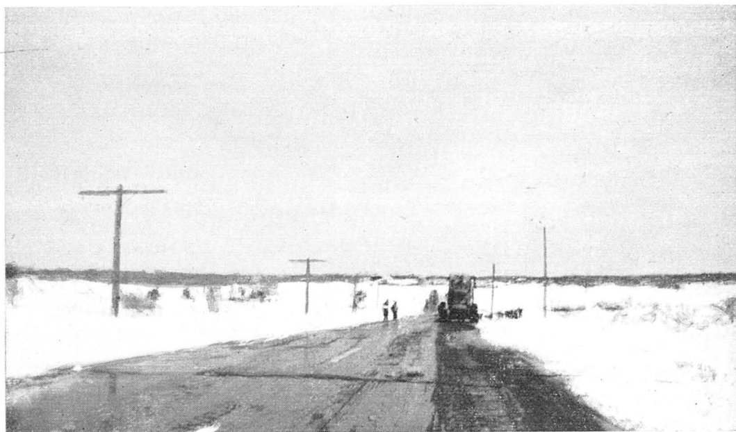
Route No 46, à Guérin. Déneigement au cours de l'hiver 1955-1956.
