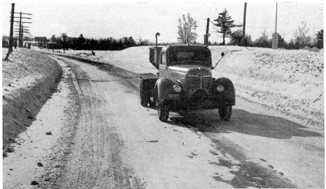
Vue montrant une section de la route No 1, entre East Angus et Weedon, entretenue aux frais du Gouvernement au cours de l'hiver 1954-55. Camion muni d'une épandeuse pour le sablage de la route.
