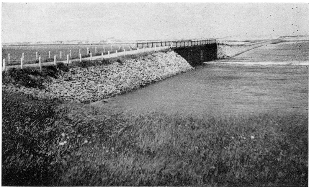
Construction des approches du pont Keating reliant la Dune-du-Nord à Grosse-Ile aux Iles-de-la-Madeleine, terminés en 1953.
