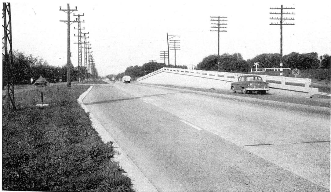
Construction d'un mur de soutènement à l'intersection de la route No 2 et de la 55ième Avenue à Lachine.
