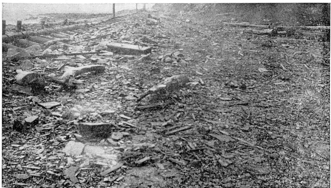
Vue montrant les dégâts causés par la mer après une tempête avant la construction de murs de protection sur la route de la péninsule de Gaspé.
