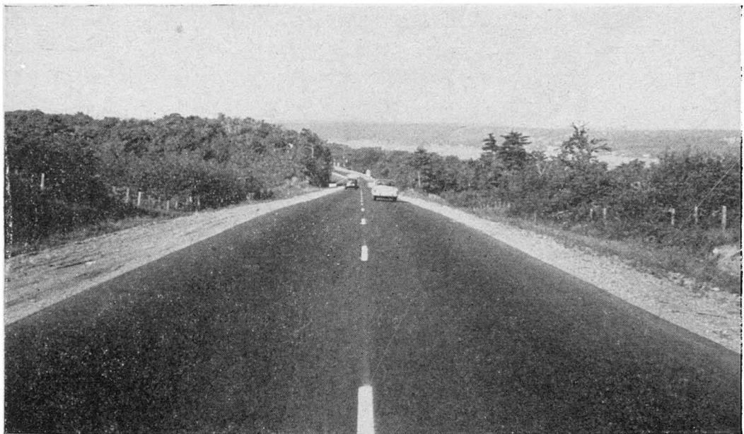
Revêtement en béton bitumineux construit à Saint-Romuald-d'Etchemin, sur la route No 3.
