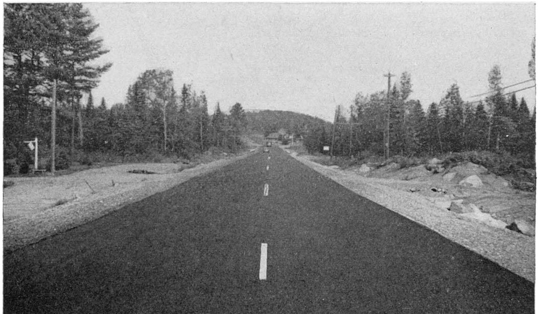
Route No 30, à Lantier. Revêtement en béton bitumineux posé en 1952.
