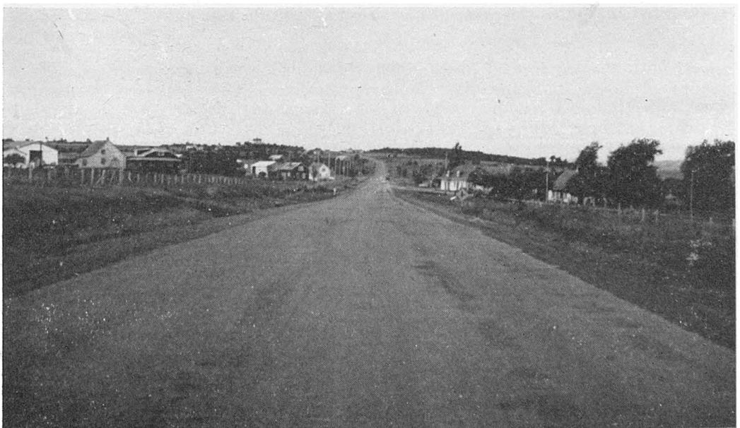
Route No 2, à Saint-Étienne-de-Beaumont. Stabilisation à l'asphalte avant la pose du revêtement de béton bitumineux terminé sur une longueur de 3.9 milles en 1951.
