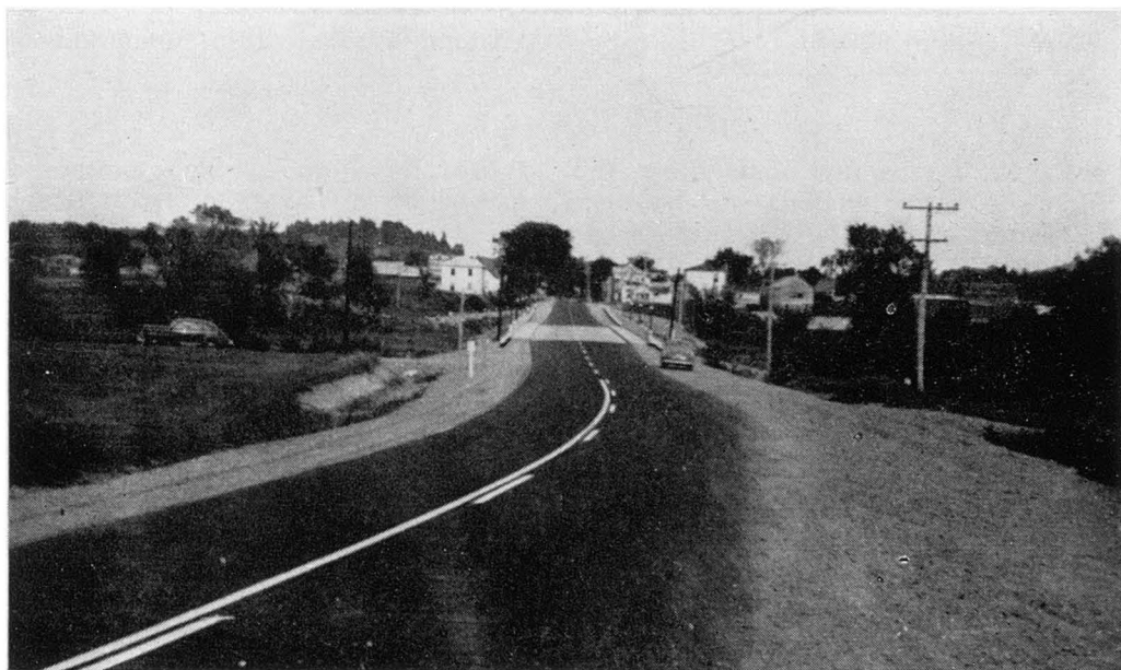
Revêtement en béton bitumineux construit à Saint-Jovite, sur la route No 11.
