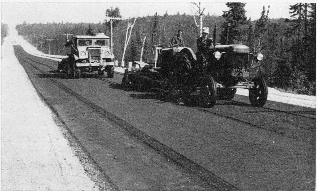
Route No 58. Stabilisation de la section de la rivière Ottawa, dans le comté de Pontiac. Premier malaxage de l'asphalte après l'épandage.
