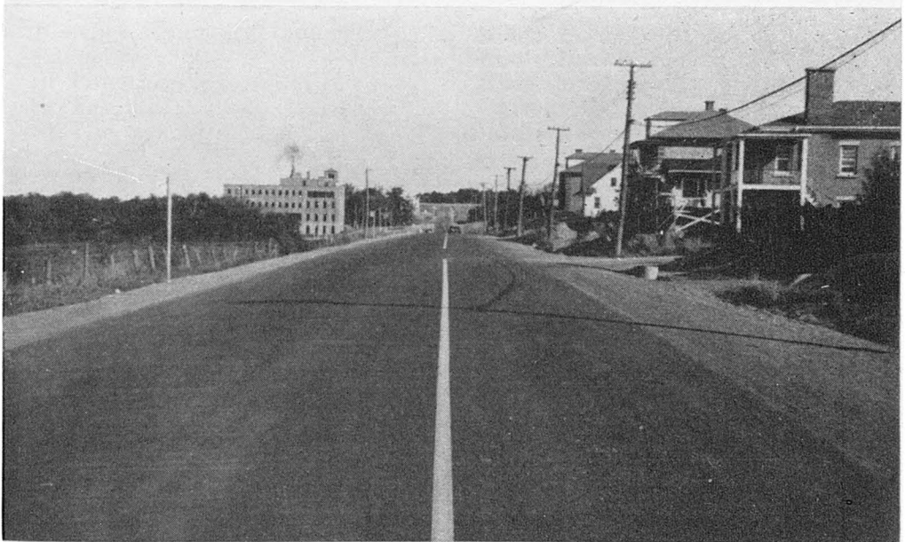
Section de la route No 54-B, asphaltée dans Chicoutimi.
