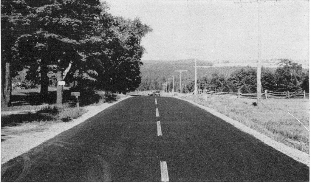
Chemin Bury-Scotstown, reconstruit et asphalté au cours de 1949 et 1950.
