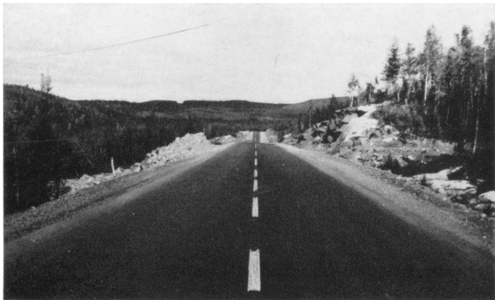
Route No 54-A, reconstruite et asphaltée entre la Rivière-des-Écorces et Hébertville.
