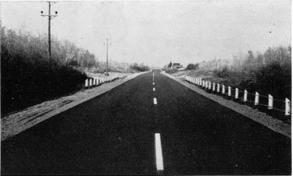
Revêtement bitumineux construit entre Saint-Nicéphore et L'Avenir, sur la route No. 22.
