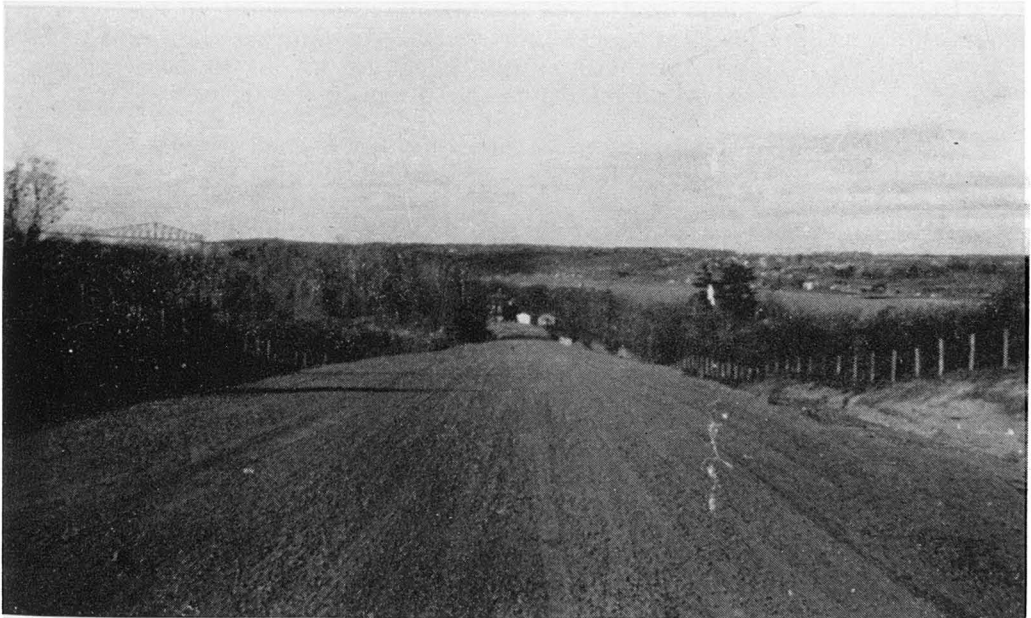
Route No 3, nouvelle section en construction à Saint-Romuald-d'Etchemin.
