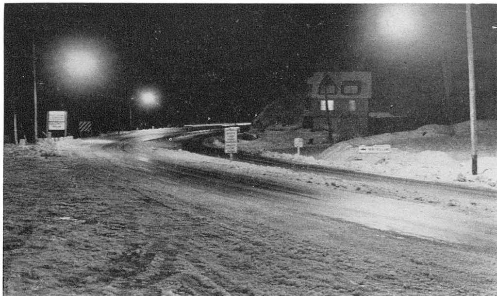
Autre endroit de la route No 11, à Mont-Rolland, pourvu d'un système d'éclairage au sodium.
