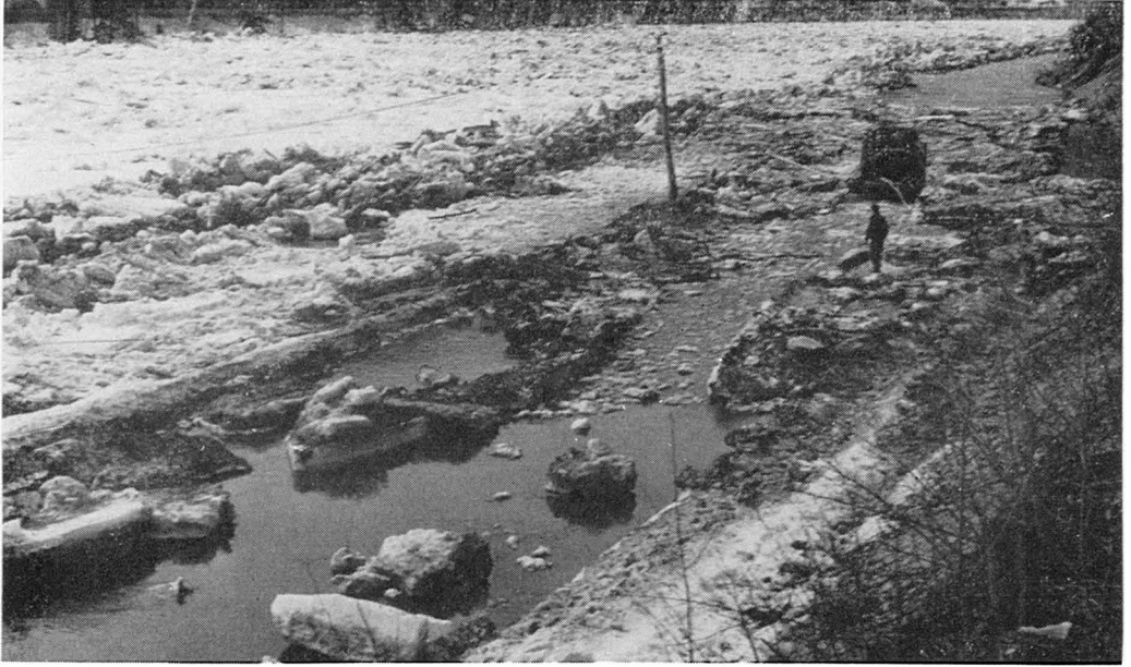
Vue montrant les dommages causés par l'inondation sur la route No 6 dans la Vallée de la Matapédia, au printemps de 1951.
