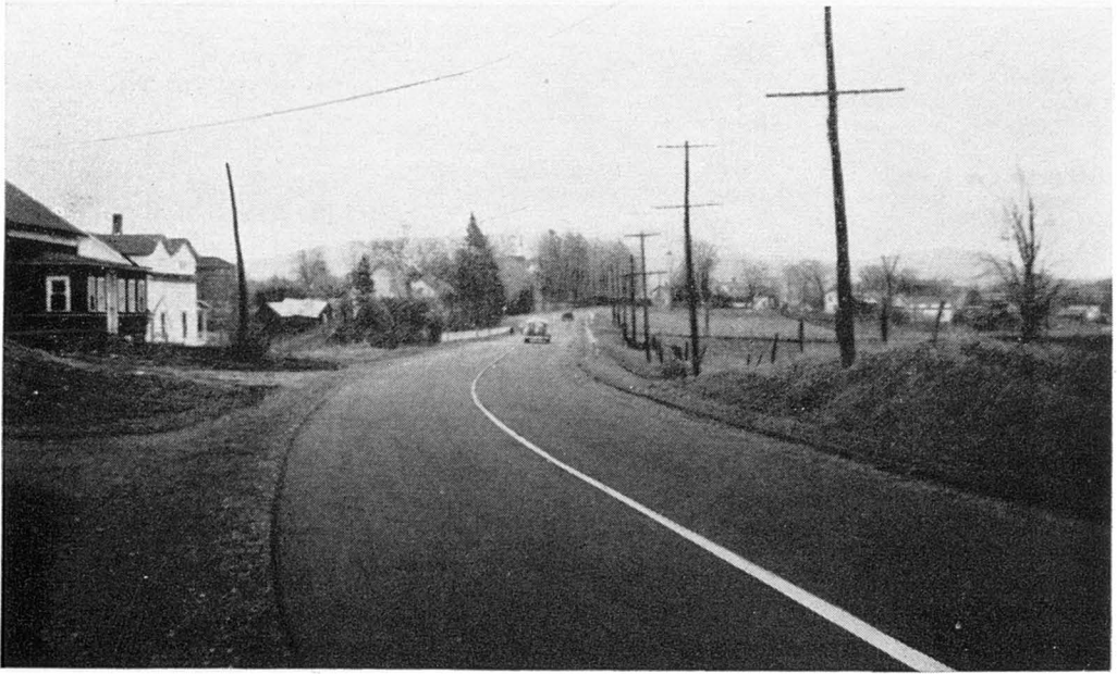
Route No 52. Revêtement d'asphalte refait entre Knowlton et Sweetsburg.
