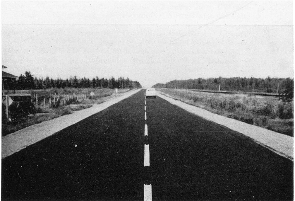
Route No 19-B, Saint-Georges à Saint-Tite. Cette route fut complètement reconstruite et asphaltée sur une longueur de 7.5 milles.
