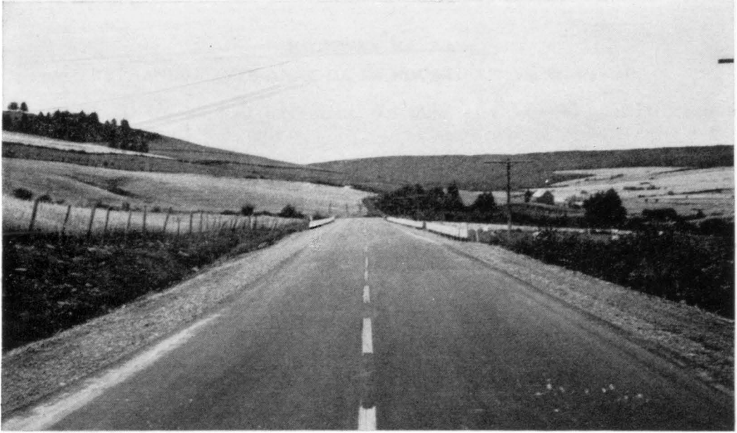
Route No 6, à Sainte-Angèle-de-Mérici. Revêtement en béton bitumineux posé en 1950.
