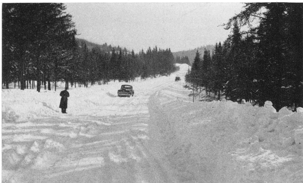
Vue d'une section de la route No 16, entre Kénogami et Saint-Bruno, entretenue au cours de l'hiver 1950-1951.
