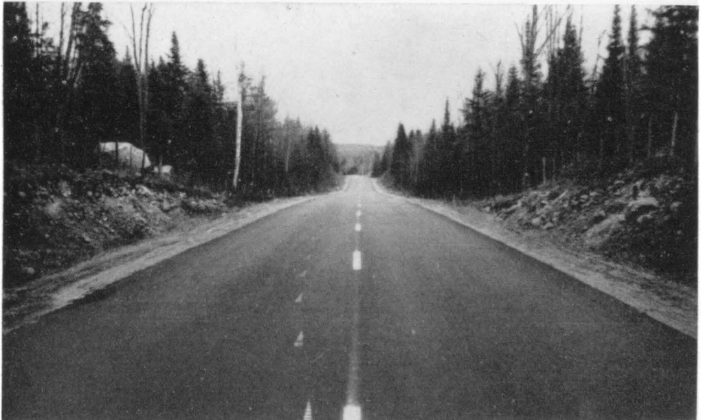
Revêtement en béton bitumineux posé sur la route de Pont-Rouge à Saint-Raymond.
