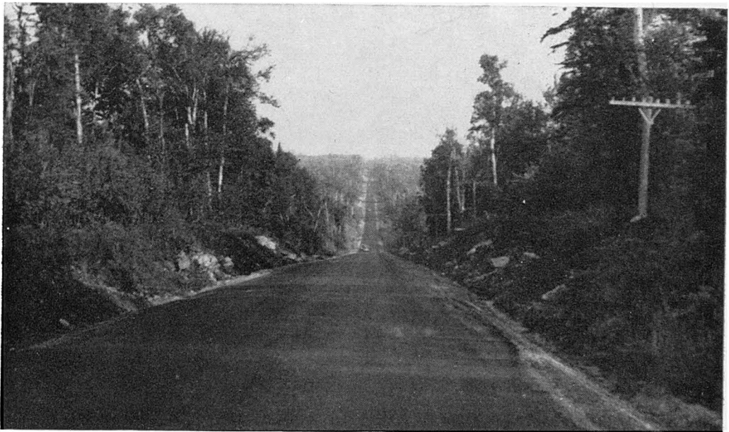
Vue montrant une section de la route No 58, Mont-Laurier-Senneterre, stabilisée à l'asphalte au cours de 1950.
