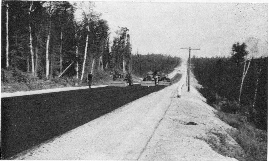
Stabilisation à l'asphalte sur la route Mont-Laurier-Senneterre. Troisième et dernière opération de malaxage de l'asphalte avec un "pulvi-mixer".
