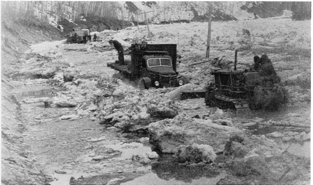
Autre section de la route No 6, dans le canton Assemetquagan, endommagée à la suite de la crue des eaux de la rivière Matapédia.
