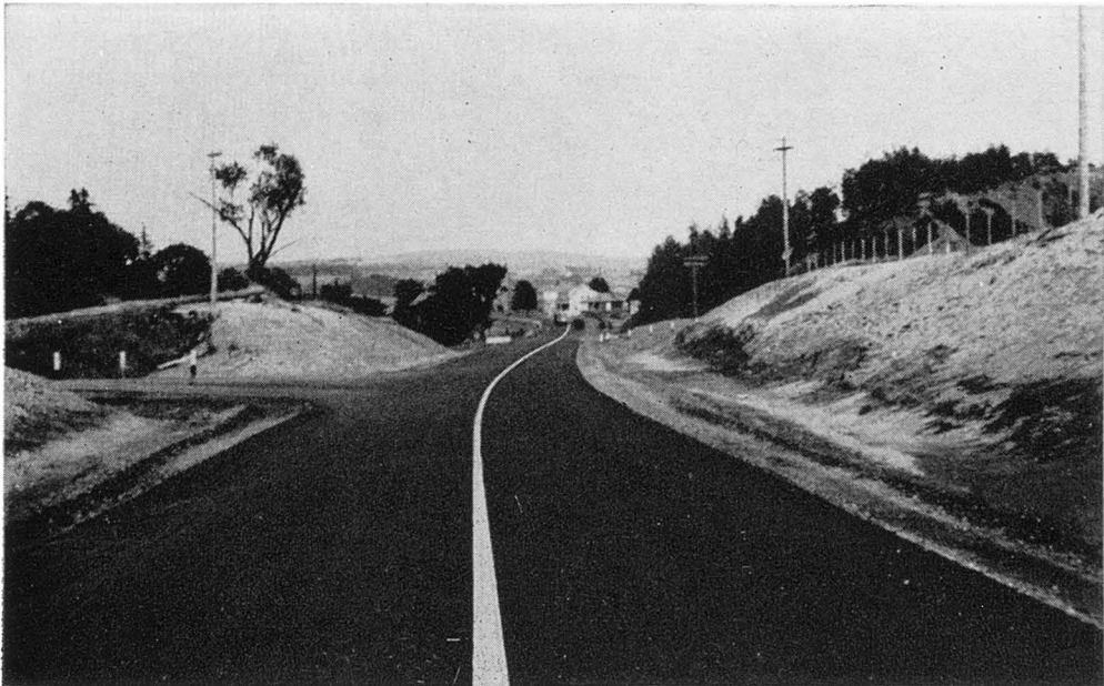
Vue d'une nouvelle section de la route No 50, près de Coaticook.
