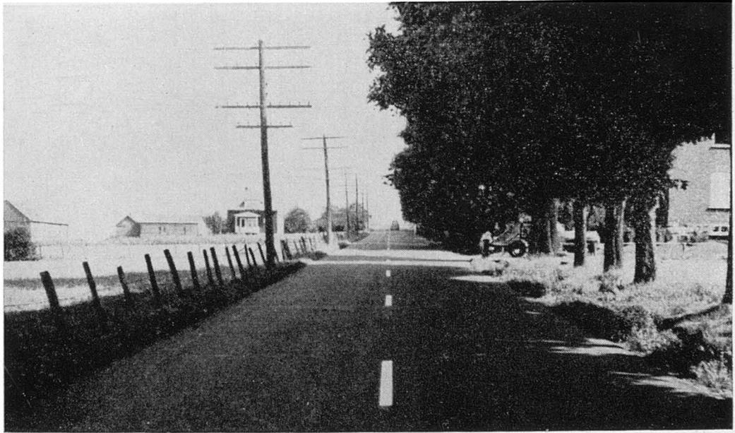
Nouveau revêtement d'asphalte entre Arthabaska et Warwick sur la route No 5.
