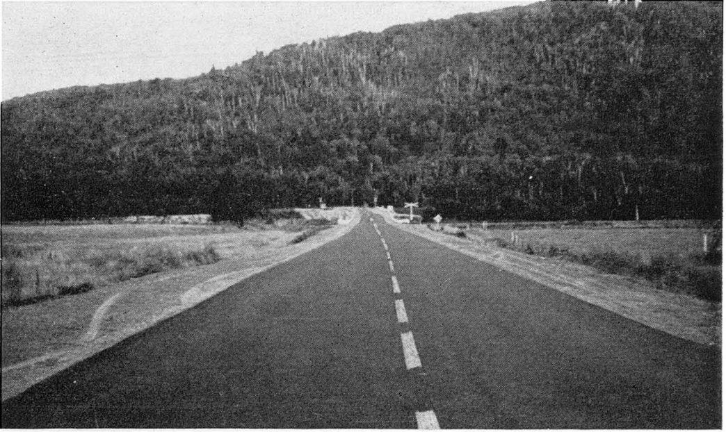
Route du pont interprovincial entre la Province de Québec et le Nouveau-Brunswick, reconstruite et asphaltée au cours de 1949 et 1950.
