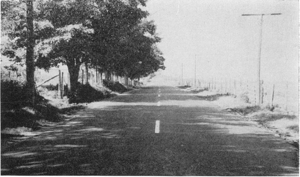
Route No 5, entre Plessisville et Pierreville. Renouvellement du revêtement de béton bitumeux sur une longueur de 5.3 milles.
