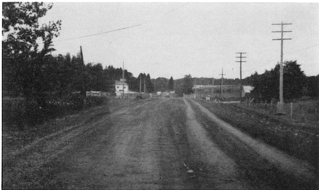
Route No 10, section reconstruite à l'entrée de Rivière-du-Loup.
