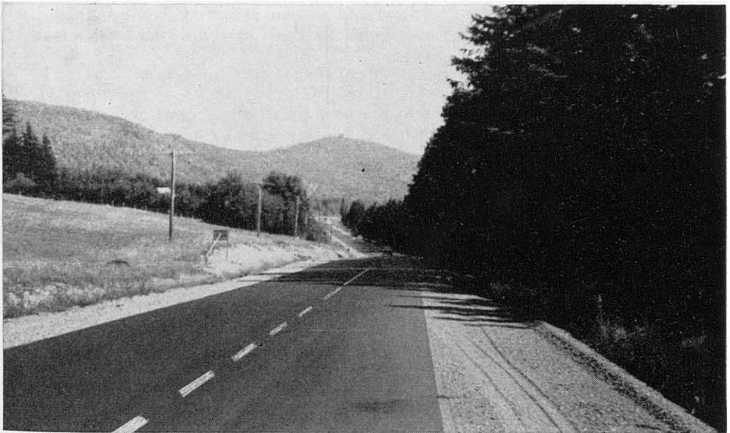
Route No 6, Escuminac-Saint-Jean-l'Évangéliste. Nouvelle section construite et asphaltée.
