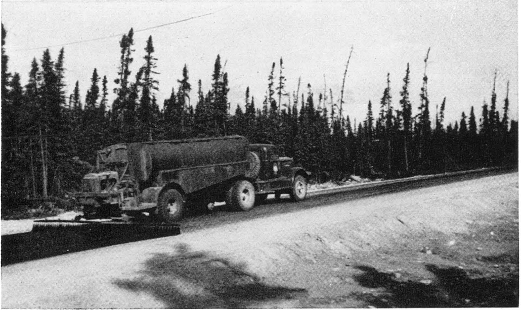
Stabilisation à l'asphalte expérimentée sur une longueur de 6 milles, au cours de 1950, sur la route No 58, Mont-Laurier-Senneterre. Première épandage de l'asphalte.
