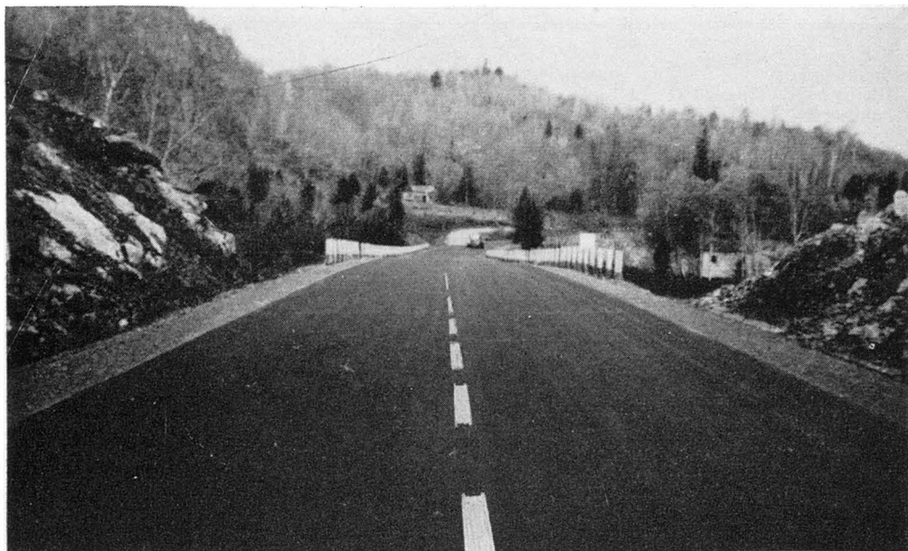
Route No 39, entre Knowlton et Bolton Sud, asphaltée au cours de 1950.
