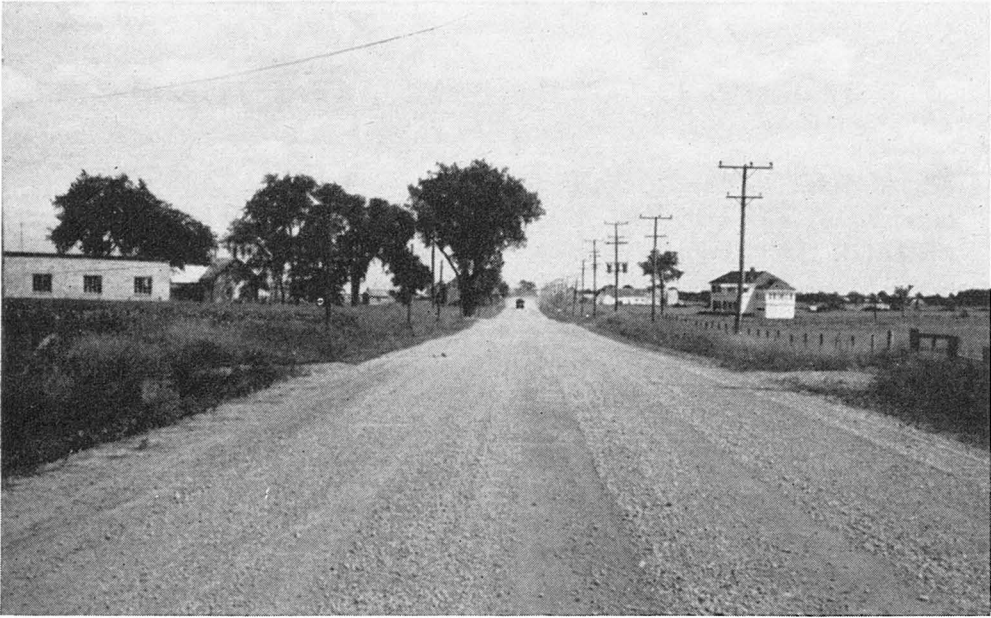
Route No 43, reconstruite à Saint-Norbert, comté de Berthier.
