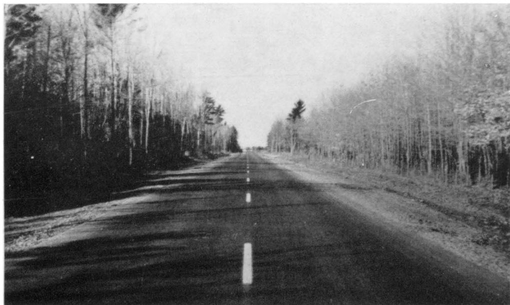
Route No 3, entre Saint-Michel-d'Yamaska et Saint-Pierre-de-Sorel. Revêtement d'asphalte posé en 1950.
