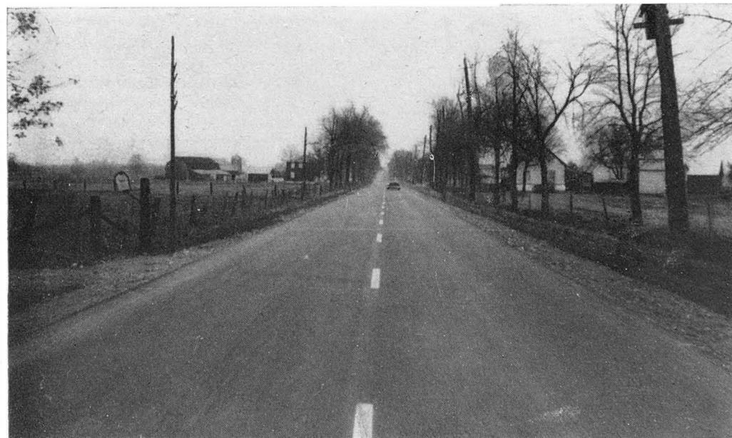
Route No 17, Dorion à Rigaud. Revêtement en béton bitumineux construit sur une longueur de 18 milles.
