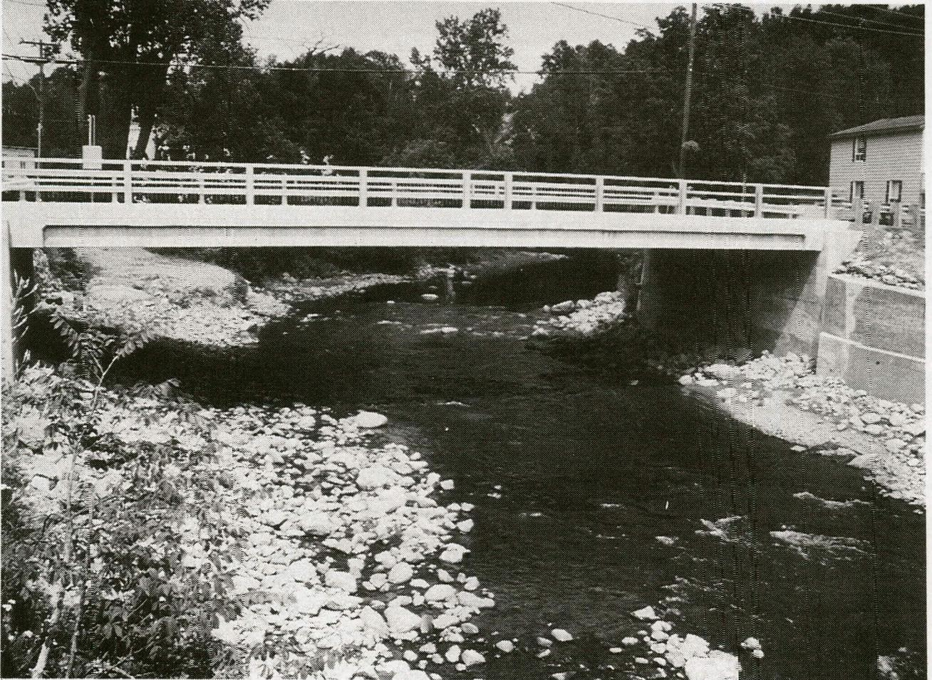
**Le pont de Portneuf en béton à haute performance**
