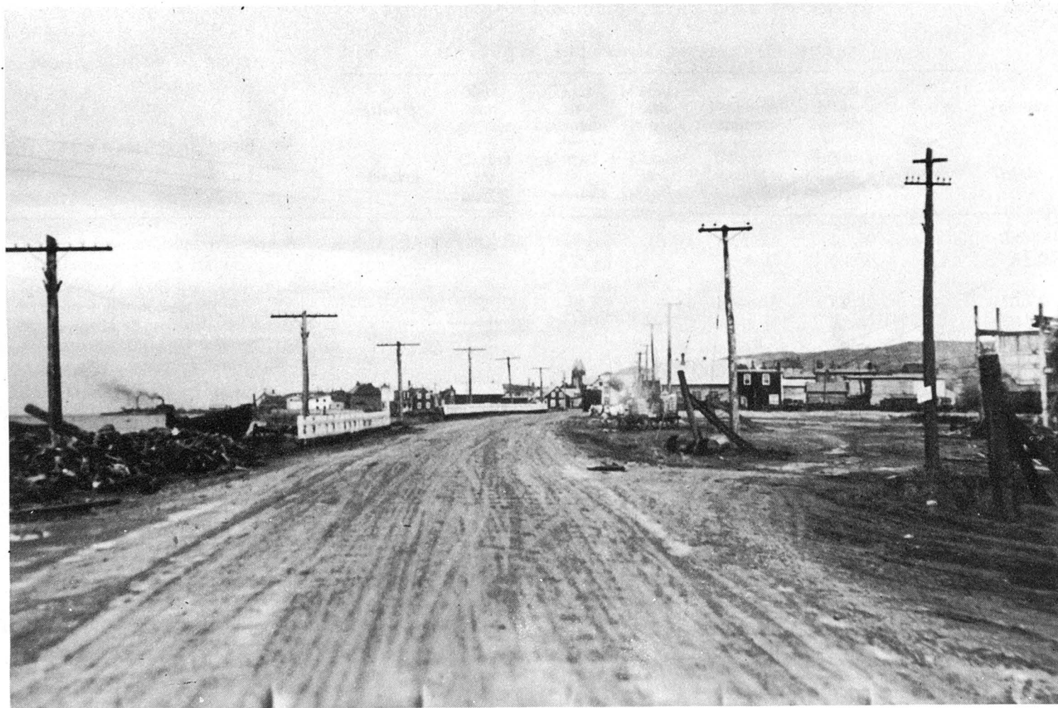
Route No 6. Élargissement de la route à Sainte-Anne-des-Monts.
