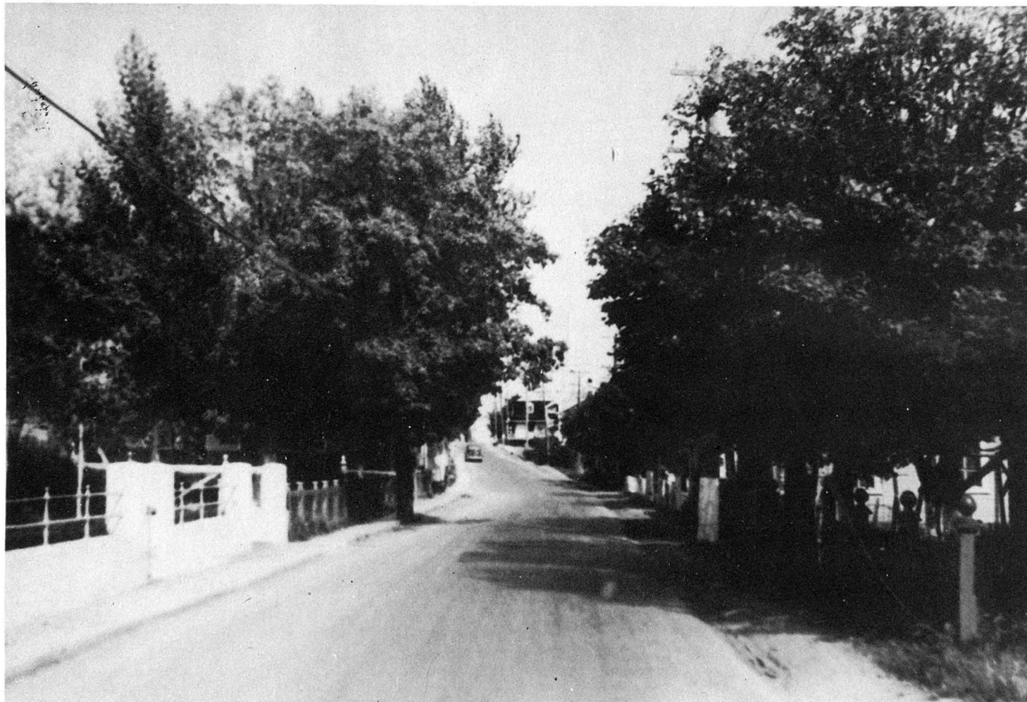
Revêtement d'asphalte construit en 1945, à Loretteville, comté de Québec.
