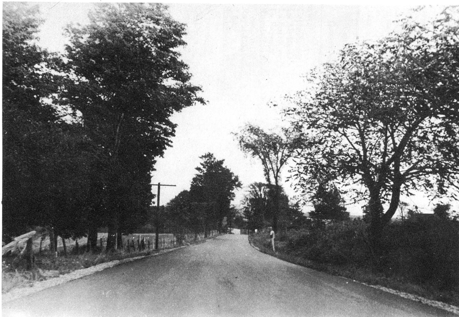
Route No 13, canton Granby. Revêtement d'asphalte posé l'été dernier.
