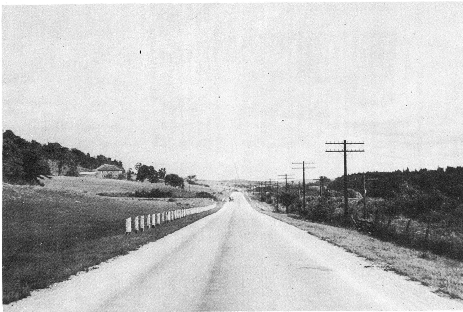
Route No 5. Traitement de surface exécuté l'été dernier, entre Danville et Richmond.
