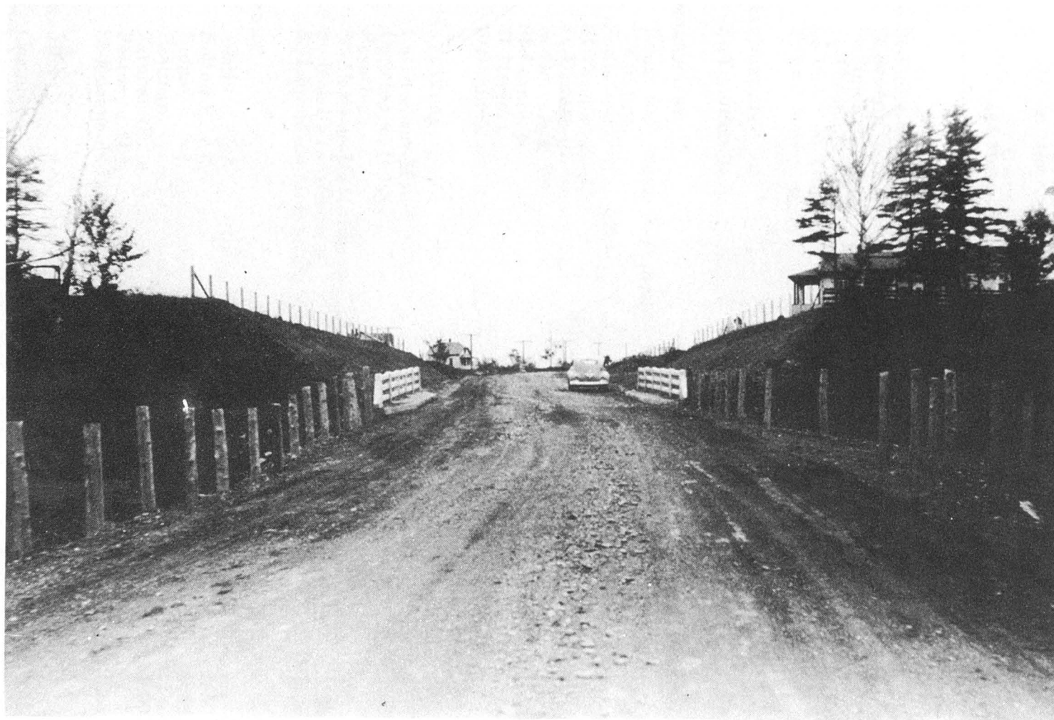
Élargissement et gravelage de la route No 6, à New-Richmond.
