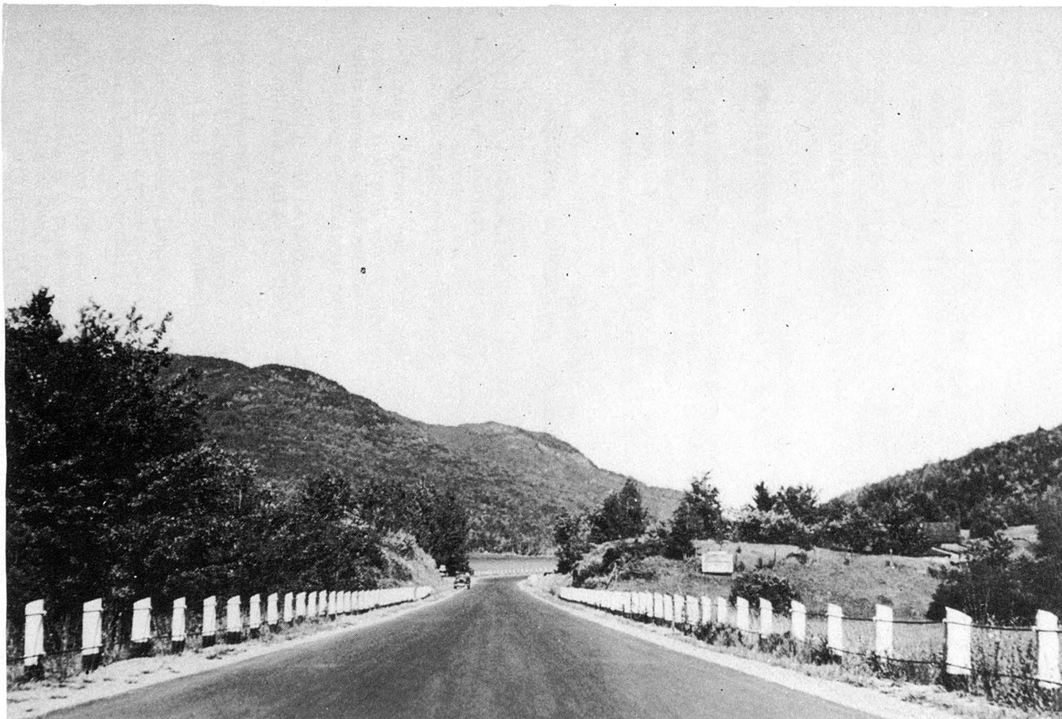
Vue de la route No 1, entre Eastman et Magog. Section asphaltée en 1945.
