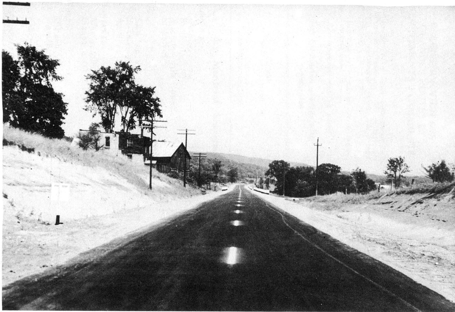
Route No 8, Montebello-Papineauville. Revêtement bitumineux construit en 1945.
