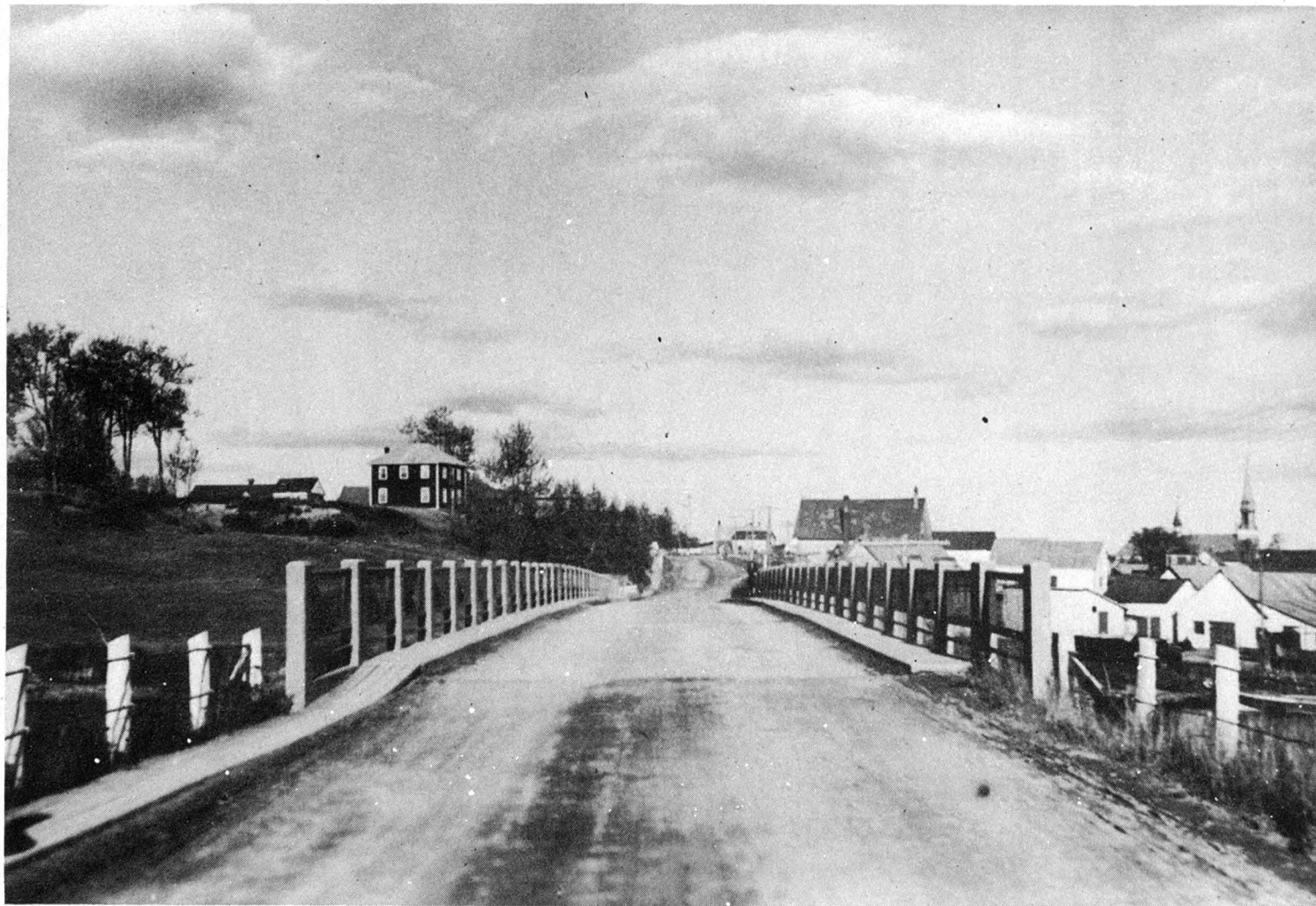
Route No 6. Élargissement de la route à Port-Daniel.
