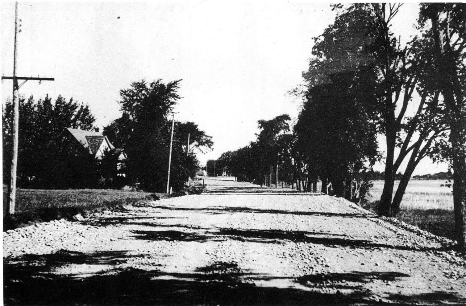
Construction d'une section de la route No 38, à Saint-Vincent-de-Paul.
