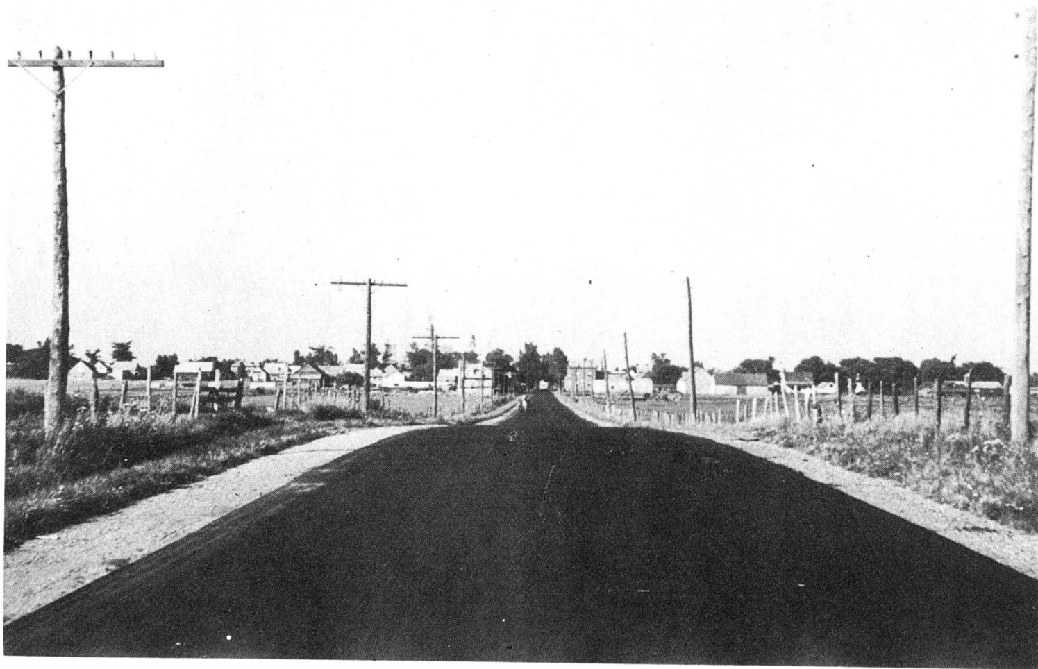
Revêtement d'asphalte construit sur la route No 20, entre Saint-Cyrille et Drummondville.
