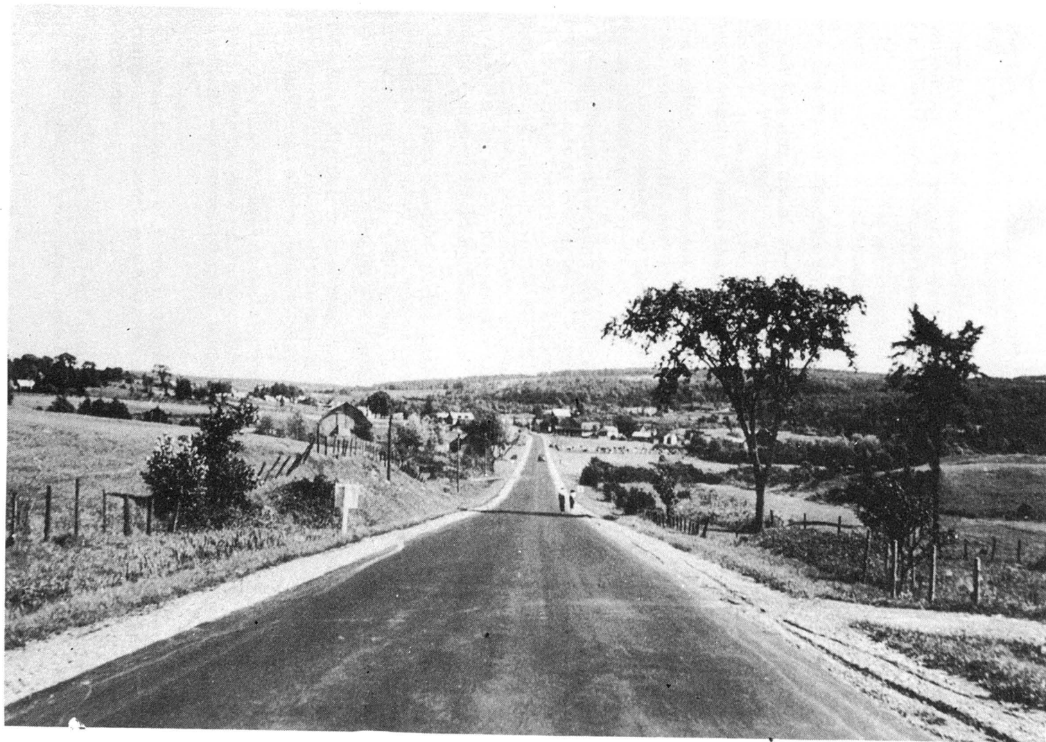
Revêtement en béton bitumineux construit sur la route No 1, entre South Stukely et Eastman.
