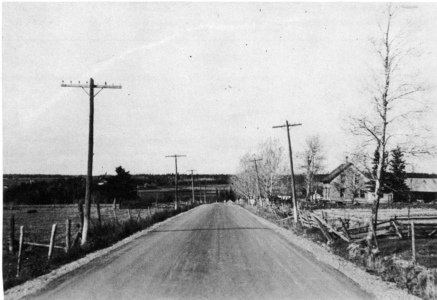
Tapis bitumineux terminé l'été dernier, à Notre-Dame-de-la-Providence, sur la route No 23, dans le comté de Beauce.
