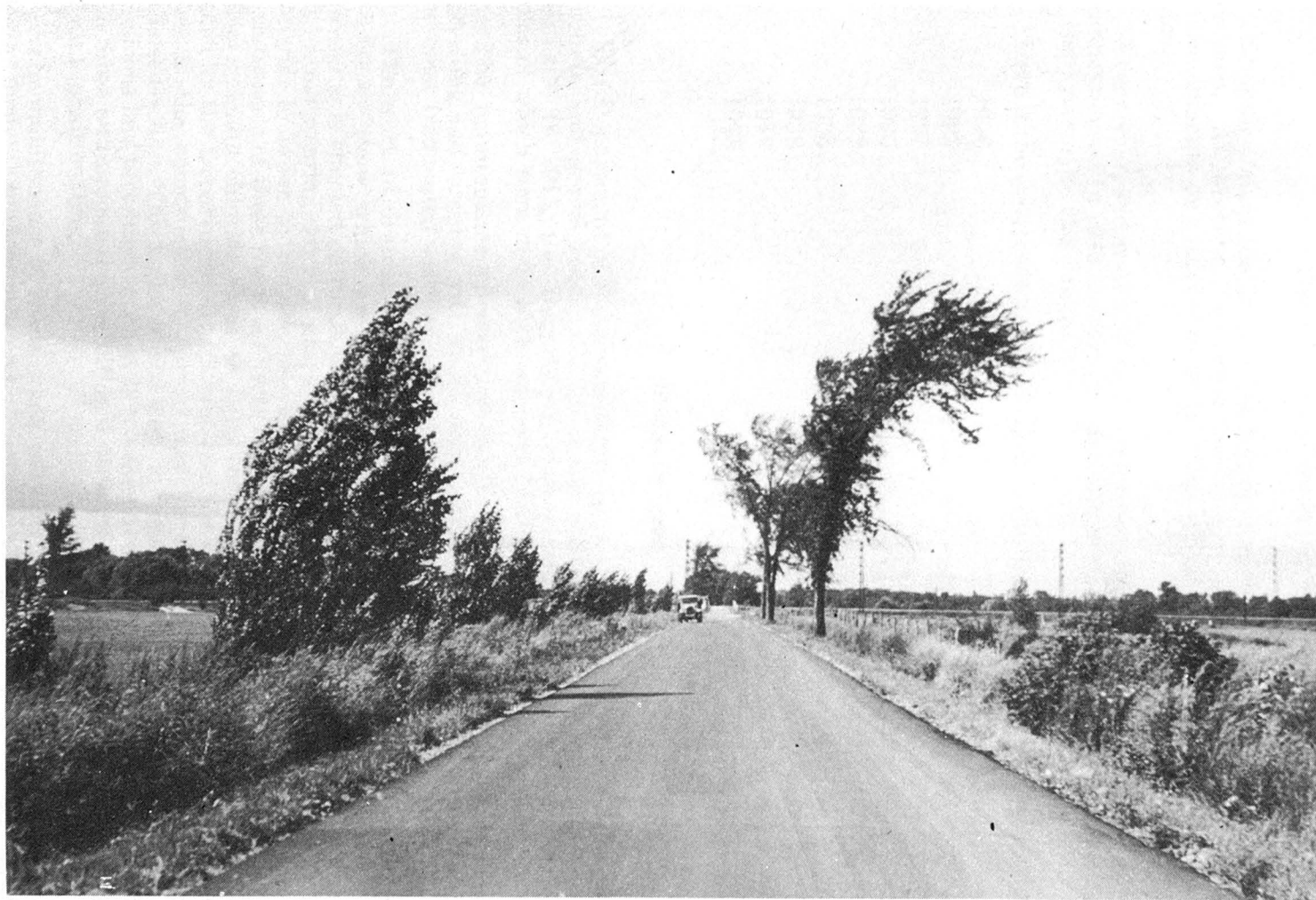
Raccordement des routes 2 et 37, Cinquième Avenue, à Lachine. Revêtement bitumineux construit l'été dernier.
