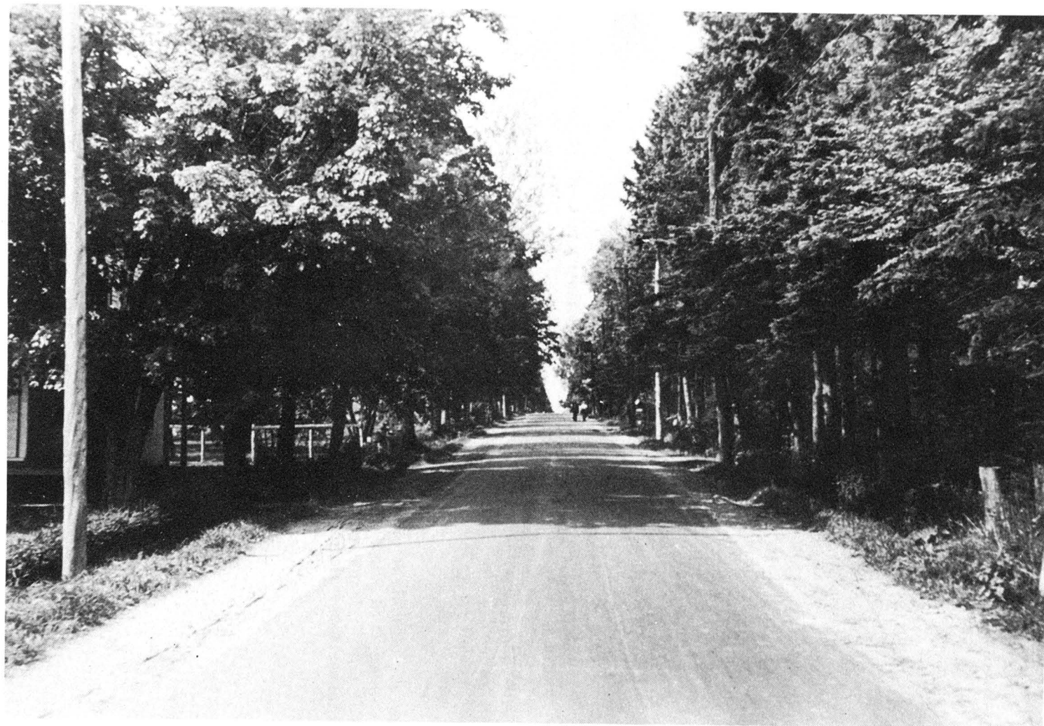
Chemin de Château-d'Eau, comté de Québec. Revêtement en béton bitumineux terminé l'automne dernier.
