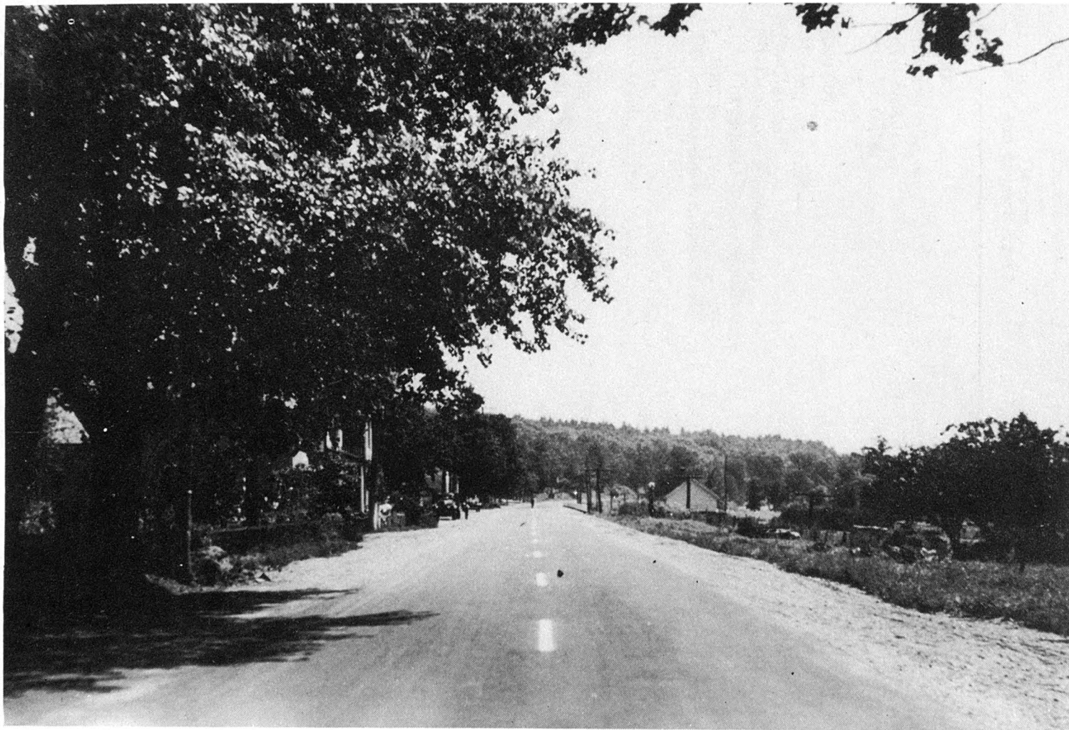
Route No 8. Revêtement en béton bitumineux terminé au mois d'août dernier, entre Pointe-au-Chêne et Montebello.
