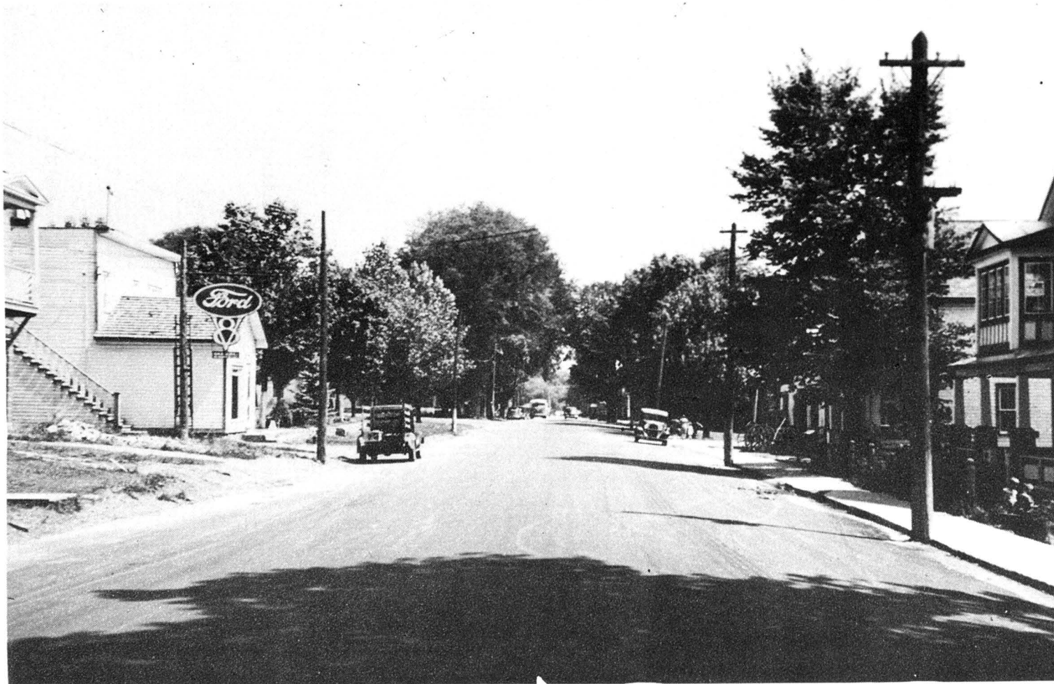
Route No 8, à Papineauville. Ce village a été asphalté l'été dernier.
