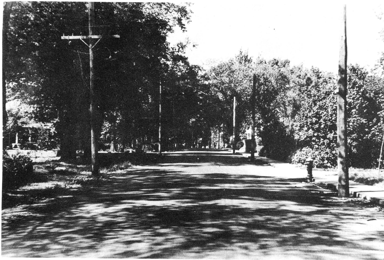
Intersection des routes Nos 21 et 40A, à Iberville. Ce revêtement d'asphalte a été terminé l'été dernier.
