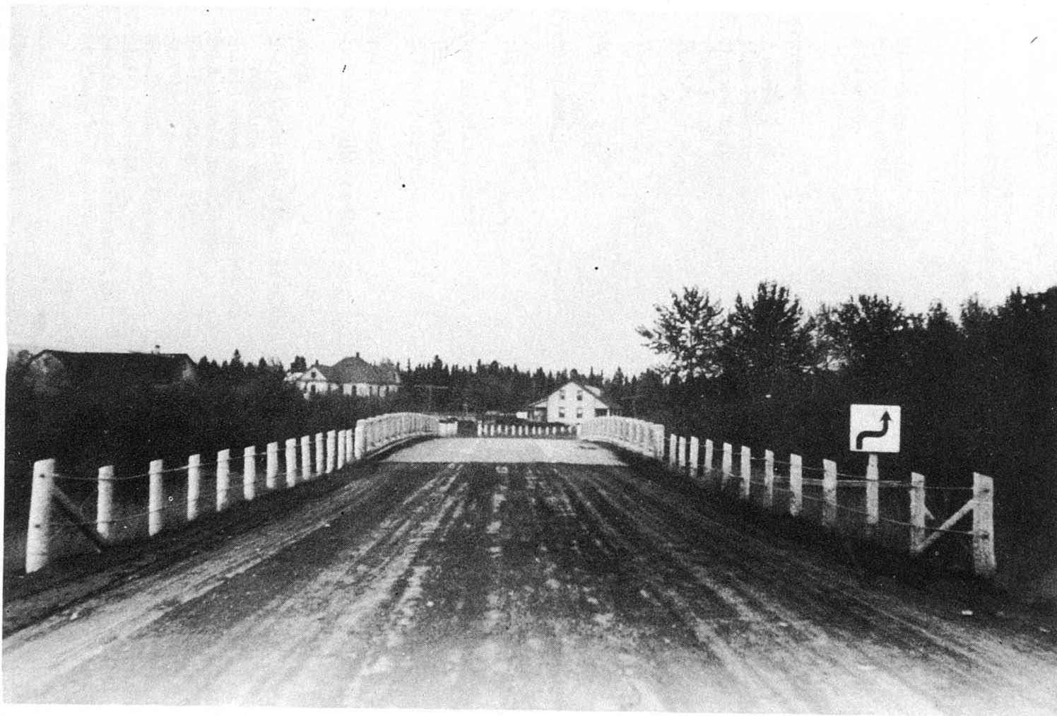
Route No 6. Travaux d'élargissement et de gravelage exécutés en 1945, près du pont Lévesque, à Maria.
