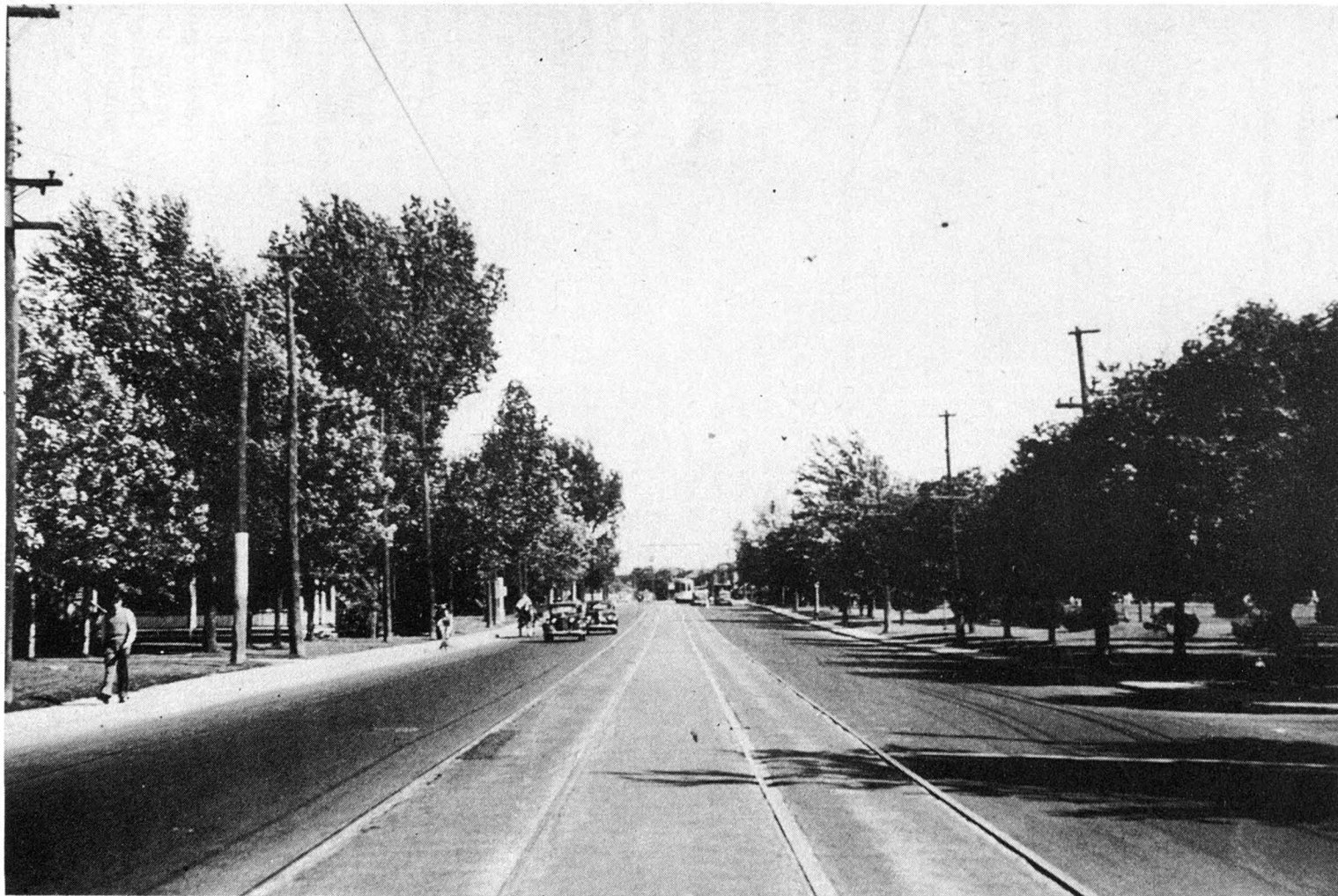
Revêtement en béton bitumineux posé en 1945, sur le boulevard Monkland, à Saint-Laurent.
