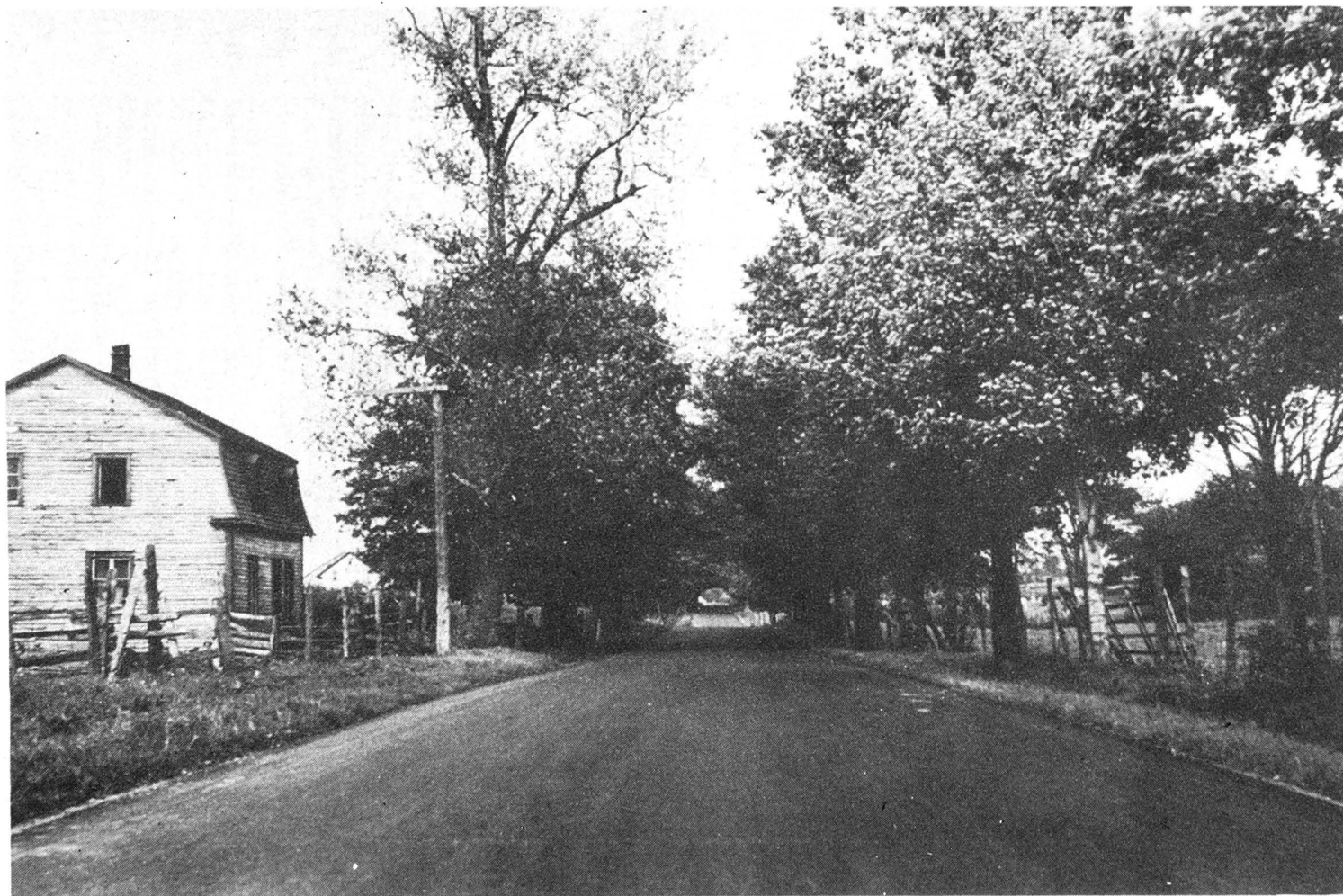
Nouveau revêtement d'asphalte, sur la route No 5, à Lyster.
