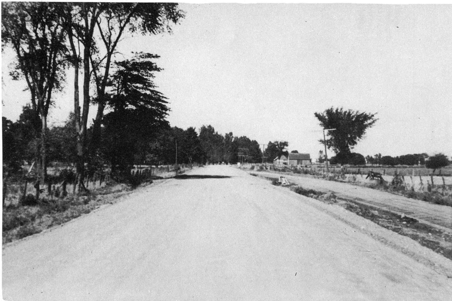
Route No 21, section Iberville-Richelieu. Des travaux d'élargissement et de gravelage ont été exécutés en 1945.
