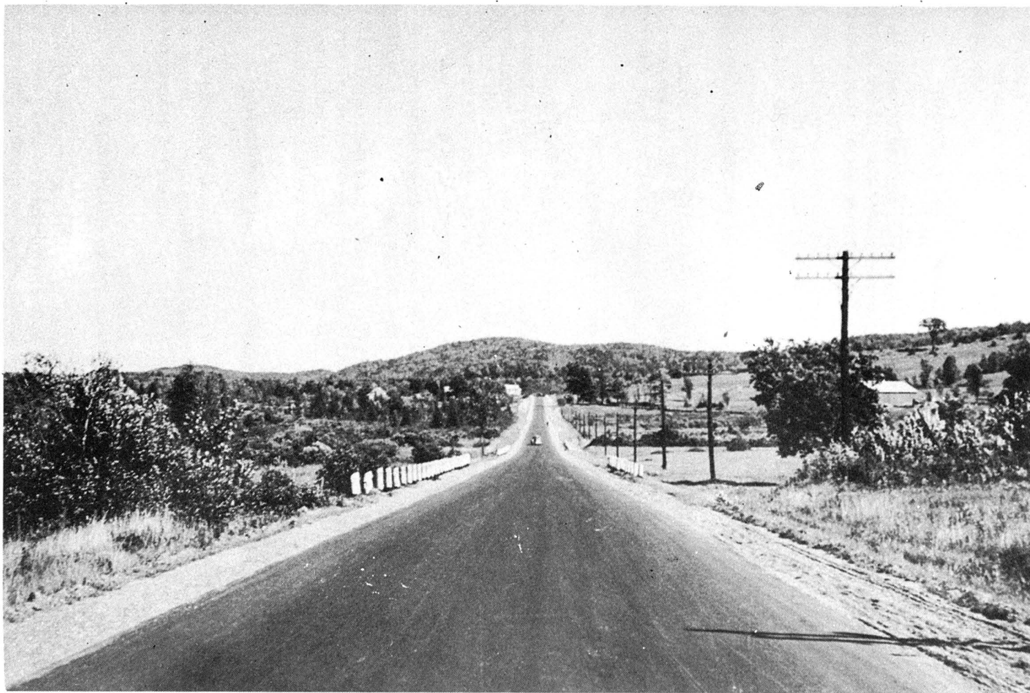
Section de la route No 1, à Saint-Étienne-de-Bolton. Le revêtement en béton bitumineux a été terminé au mois d'août 1945.
