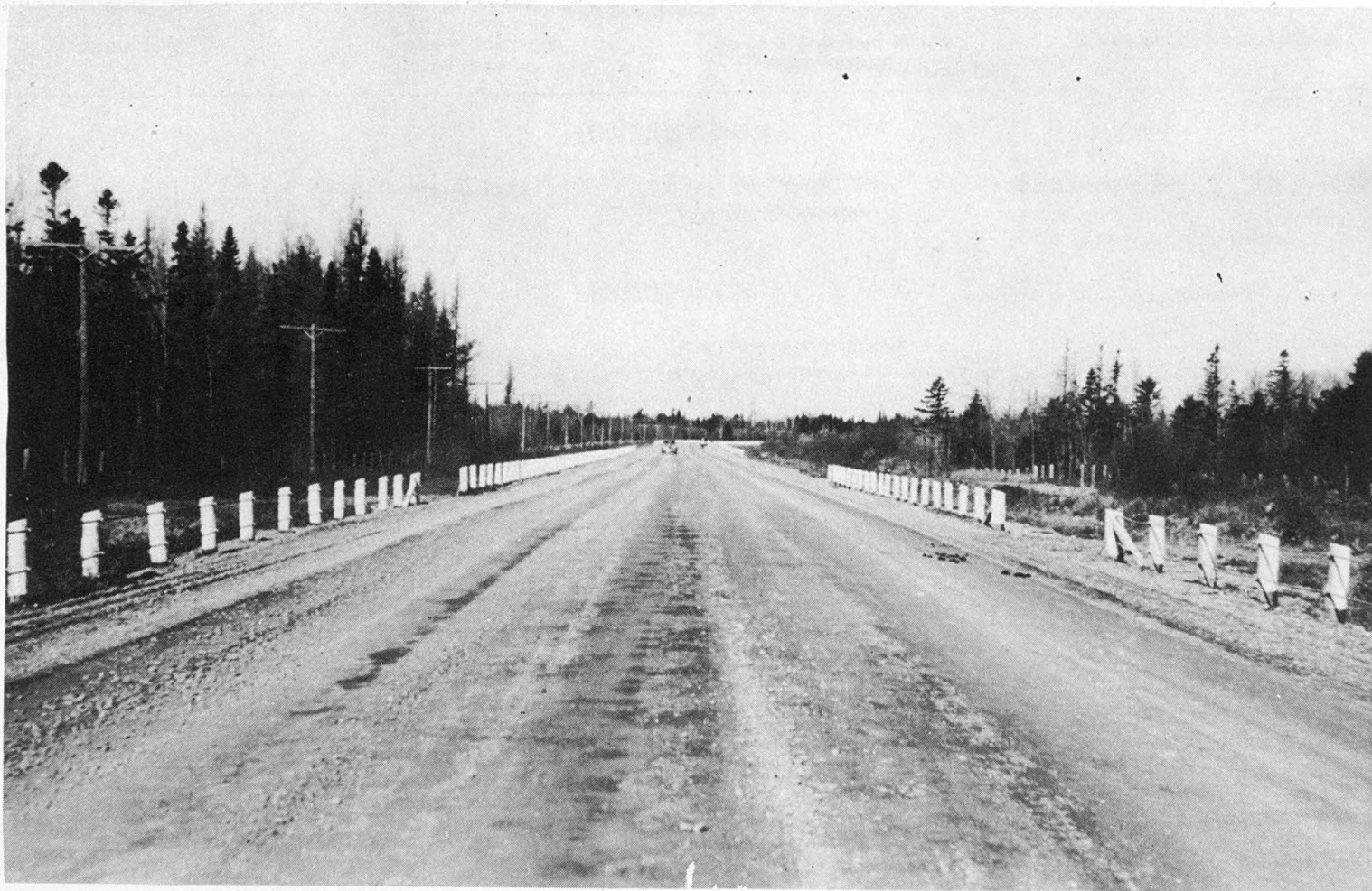
Section de la route No 23, Saint-Henri-Scott. Stabilisation imperméable de base avant le revêtement en béton bitumineux.
