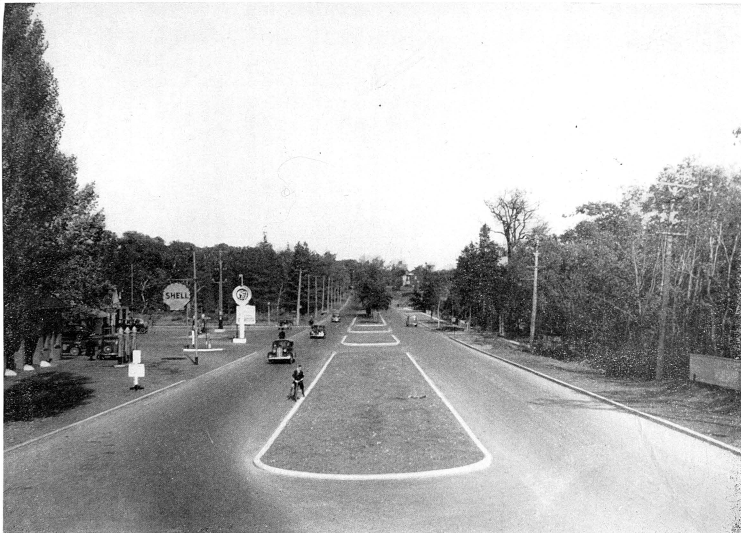
Vue montrant une section de la voie Sir-Wilfrid-Laurier, à Sillery.
