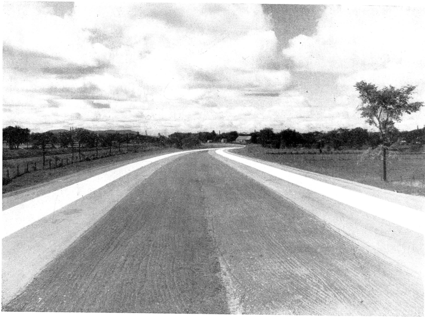
Section de la voie Sir-Wilfrid-Laurier, à Ste-Rosalie, comté de Bagot.
