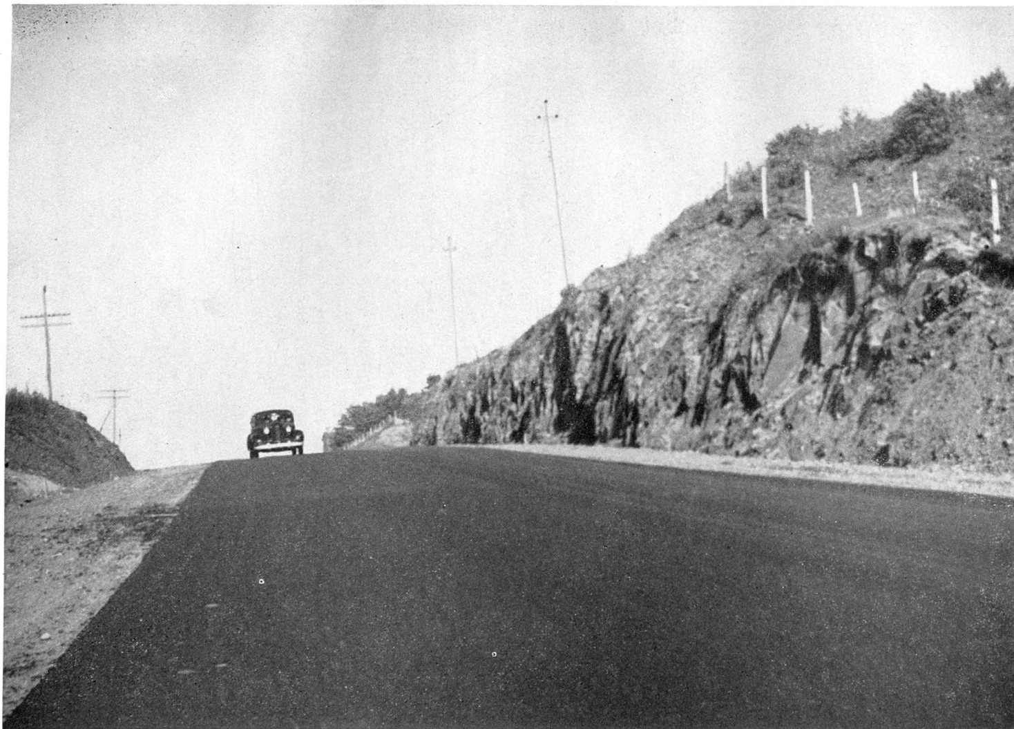
Revêtement en béton bitumineux terminé l'été dernier sur la route No 2, à Lauzon, dans le comté de Lévis.
