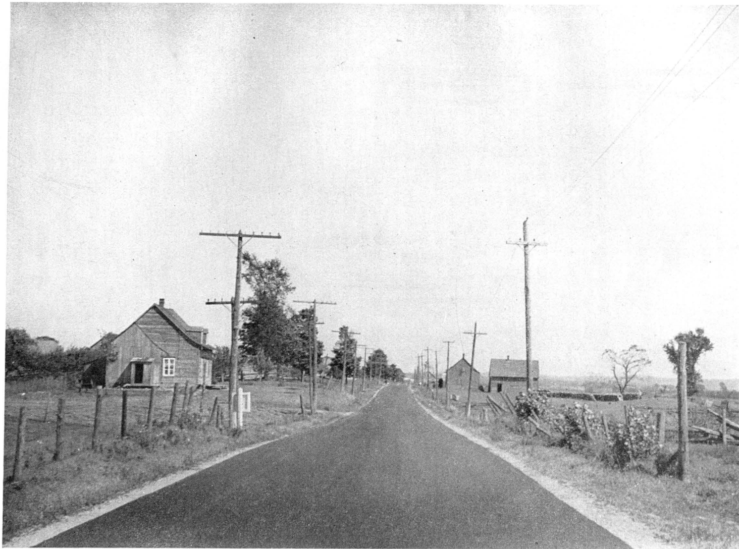
Revêtement en béton bitumineux construit sur la route No 5, entre Plessisville et Princeville.
