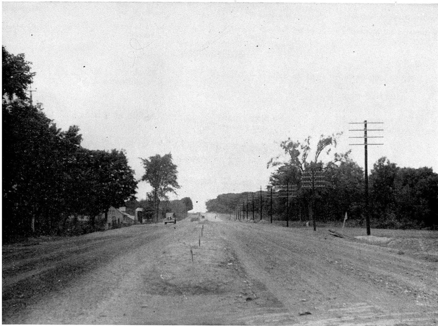
Route No 11. Construction d'une nouvelle section entre Shawbridge et Piedmont.
