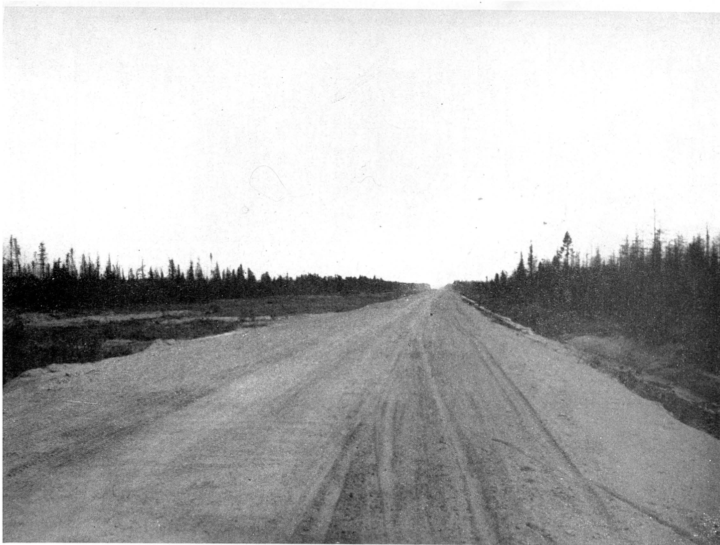
Gravelage d'une section de la voie Sir-Wilfrid-Laurier, à St-Louis-de-Blandford.
