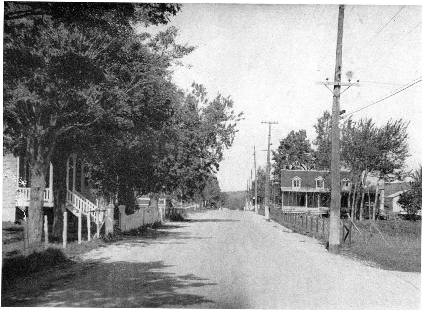
Tapis bitumineux terminé l'été dernier, près du village de Charlesbourg, sur la route No 54A.
