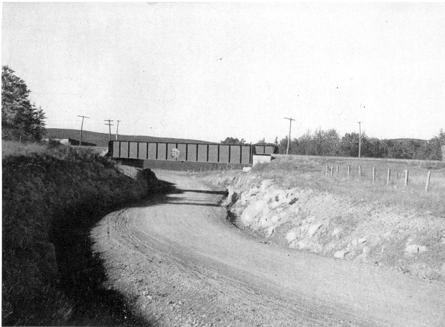
Vue montrant le tunnel construit sous les voies du C.N. à Val-Brillant, sur la route No 6.
