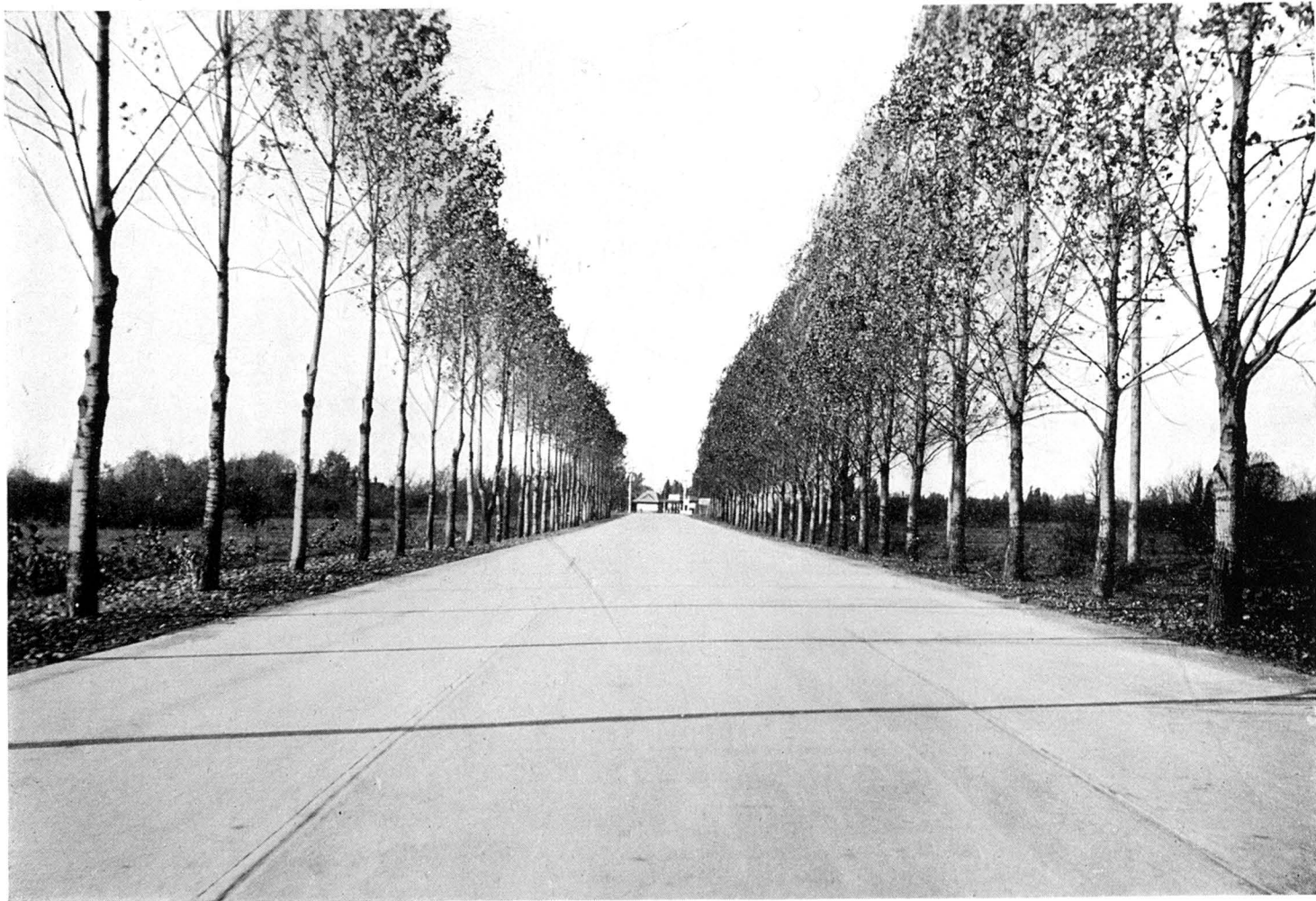
Vue du chemin de raccordement du boulevard Alexandre-Taschereau avec le pont Victoria.
