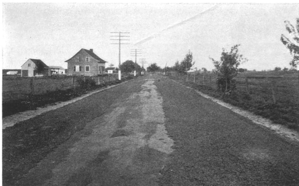
Elargissement du pavage existant préalablement à la pose d'un nouveau pavage
