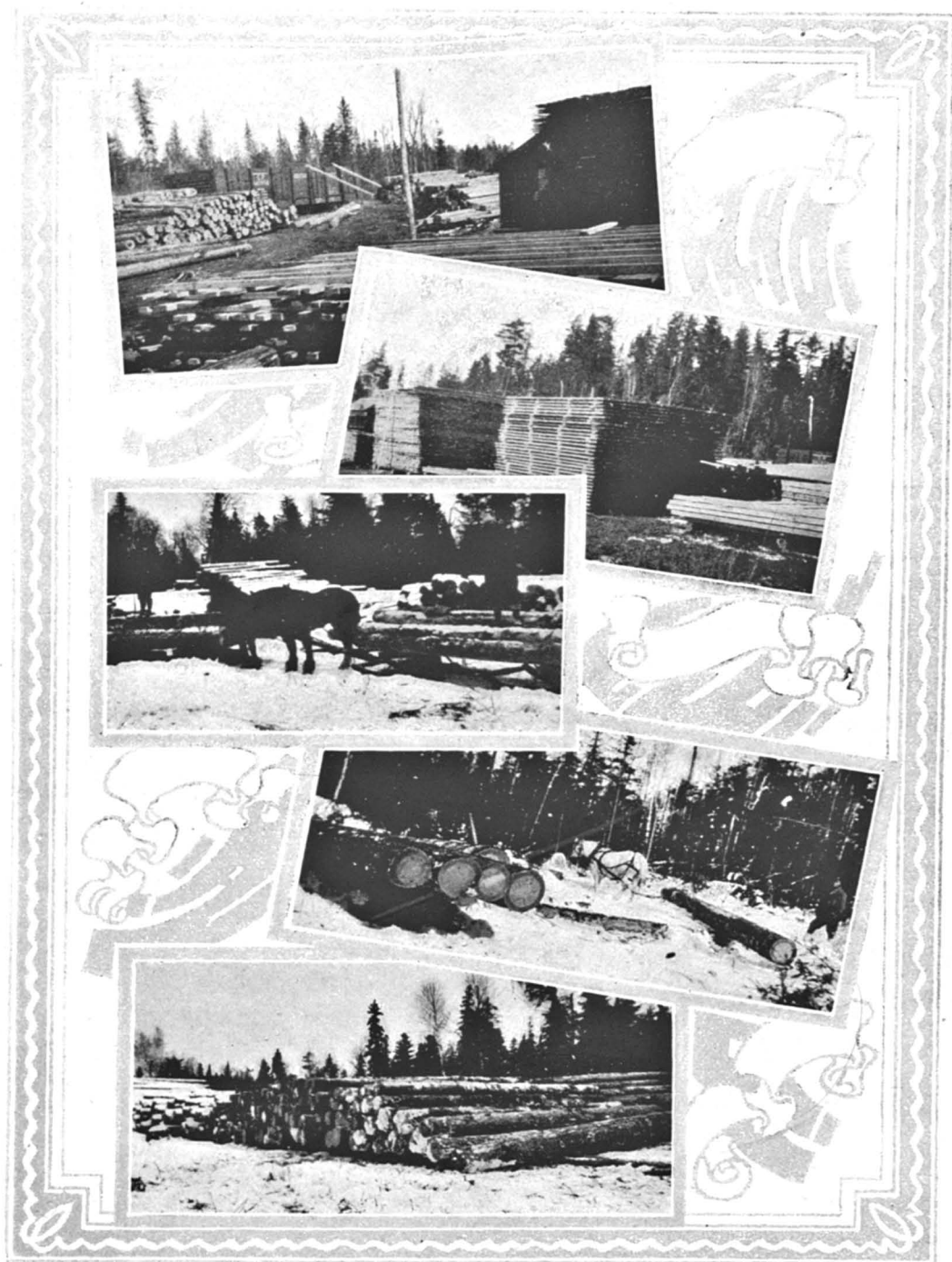
Le département opère à Dozois, comté de Témiscamingue une scierie qui lui fournit le bois pour les ponts, et pour les garde-fous sur la route Macamic-Témiscaming ainsi que pour d'autres routes de la province
