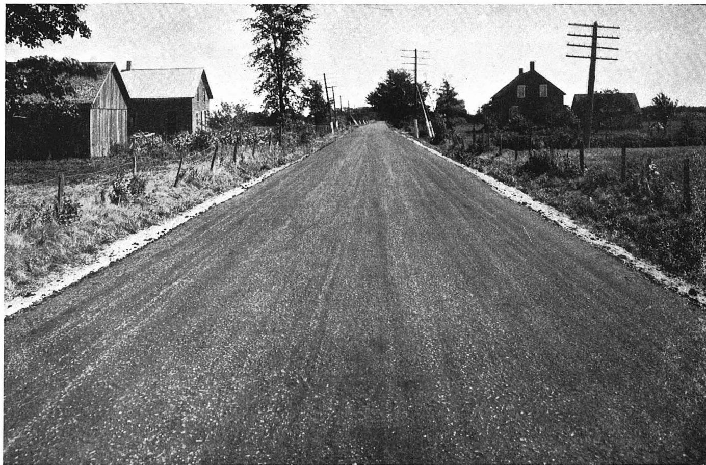
MONTRÉAL-SHERBROOKE—Canton GRANBY Township Revêtement en macurban posé en 1927 Macurban pavement laid in 1927
