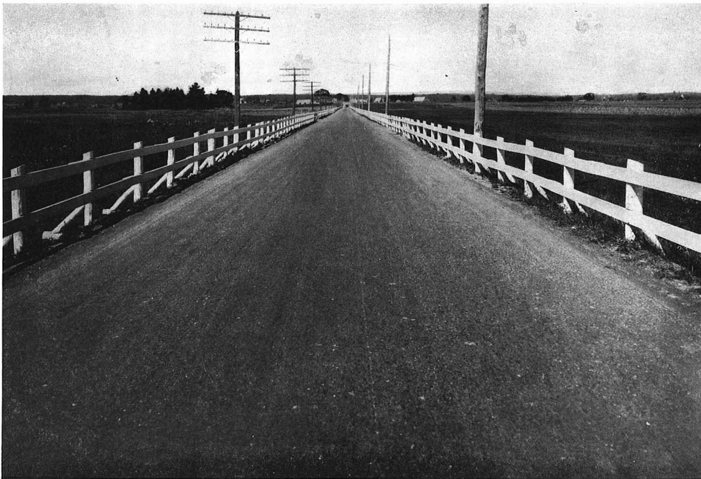
MONTREAL-MONT-LAURIER—St-Jérôme Revêtement en macurban posé en 1927 Macurban pavement laid in 1927
