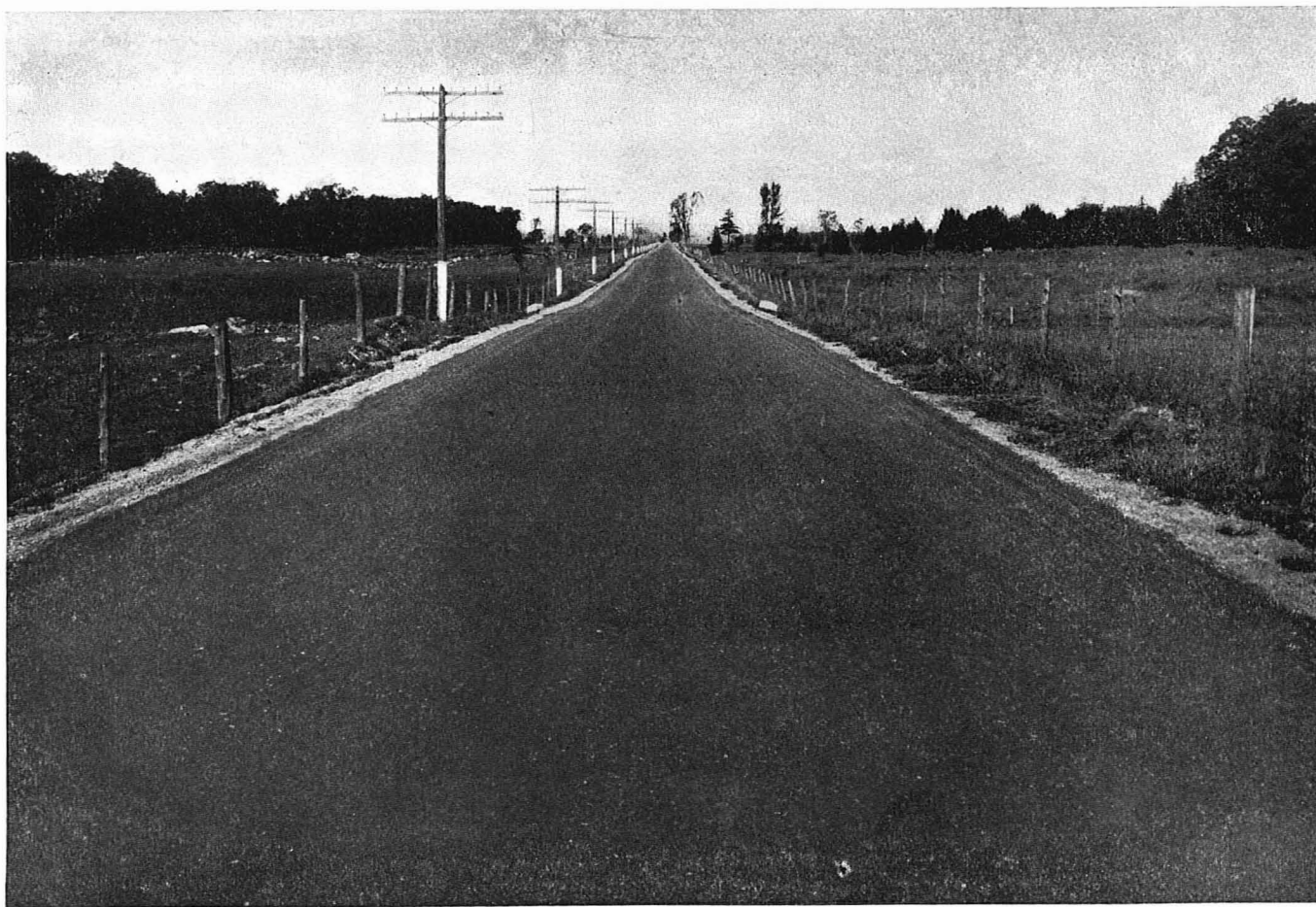
MONTRÉAL-MONT-LAURIER—St-Janvier Revêtement en macurban posé en 1927 Macurban pavement laid in 1927
