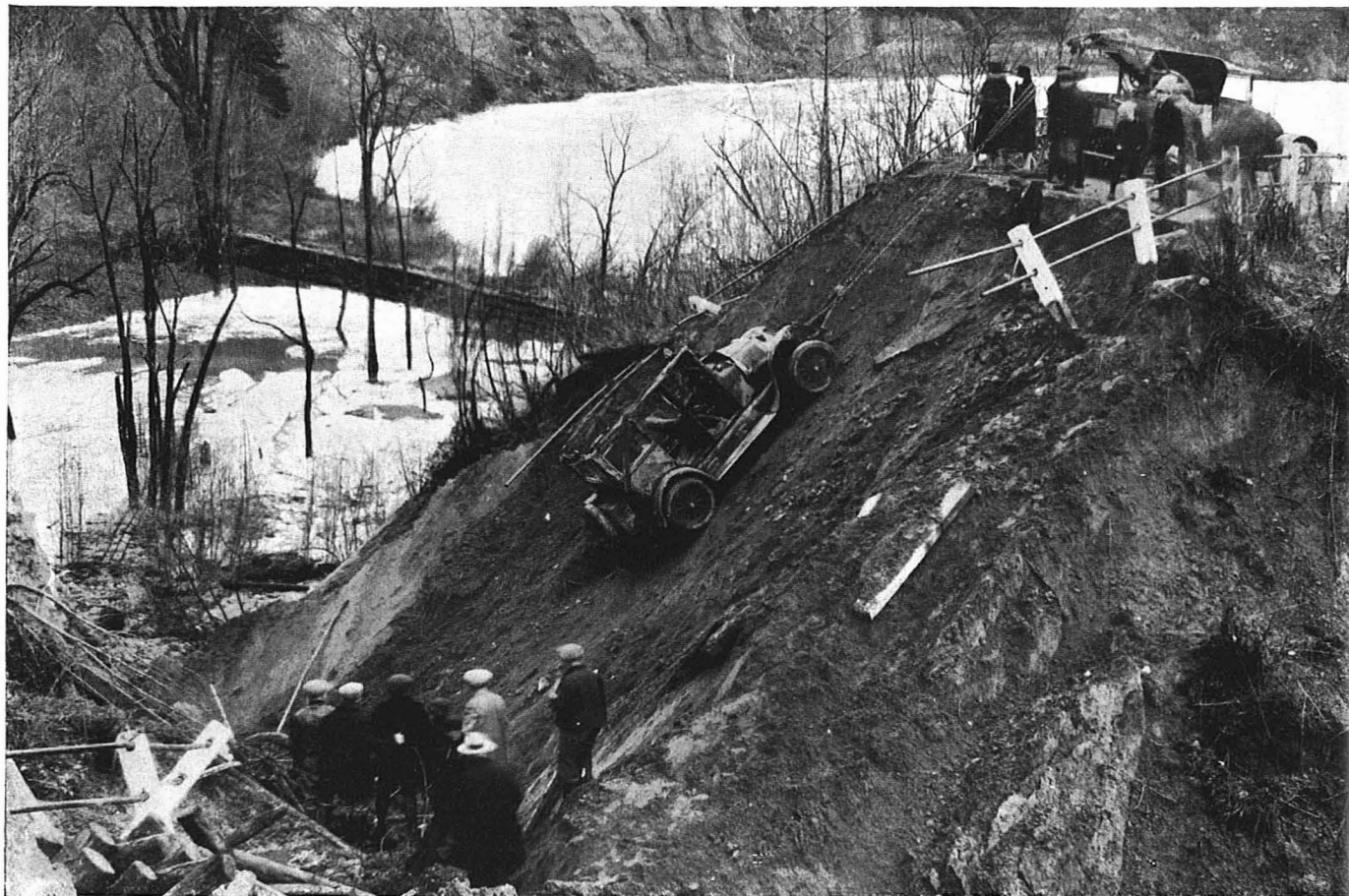
Chemin et remblai emportés par l'eau à Donnacona, sur la route Montréal-Québec, lors des pluies du 15 au 18 novembre.
