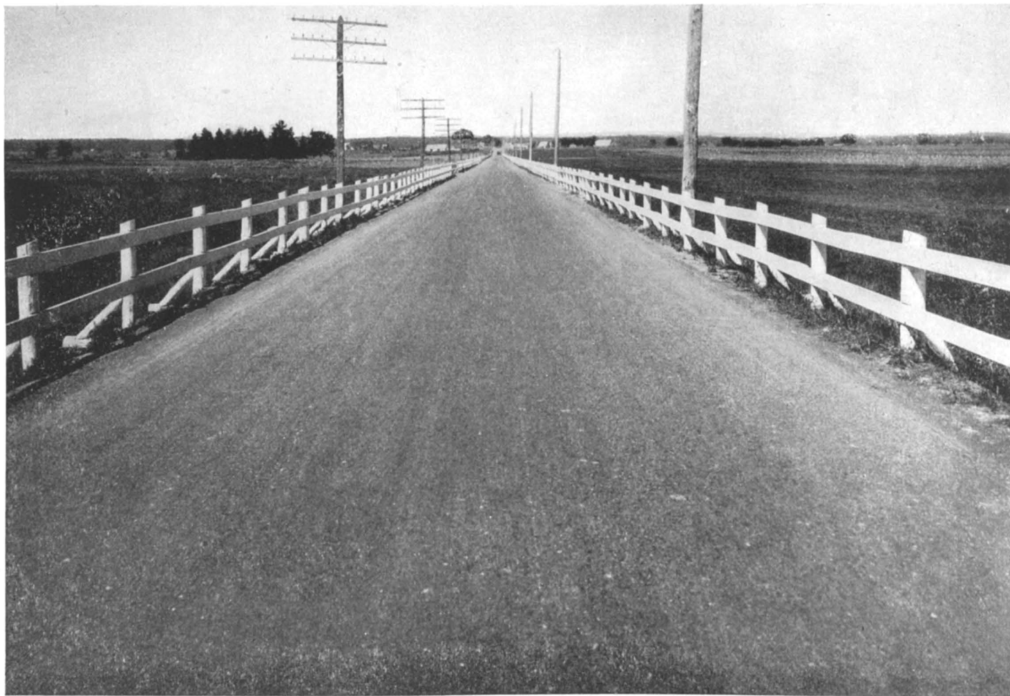
MONTRÉAL-MONT-LAURIER—St-Jérôme Revêtement en macurban posé en 1927 Macurban pavement laid in 1927
