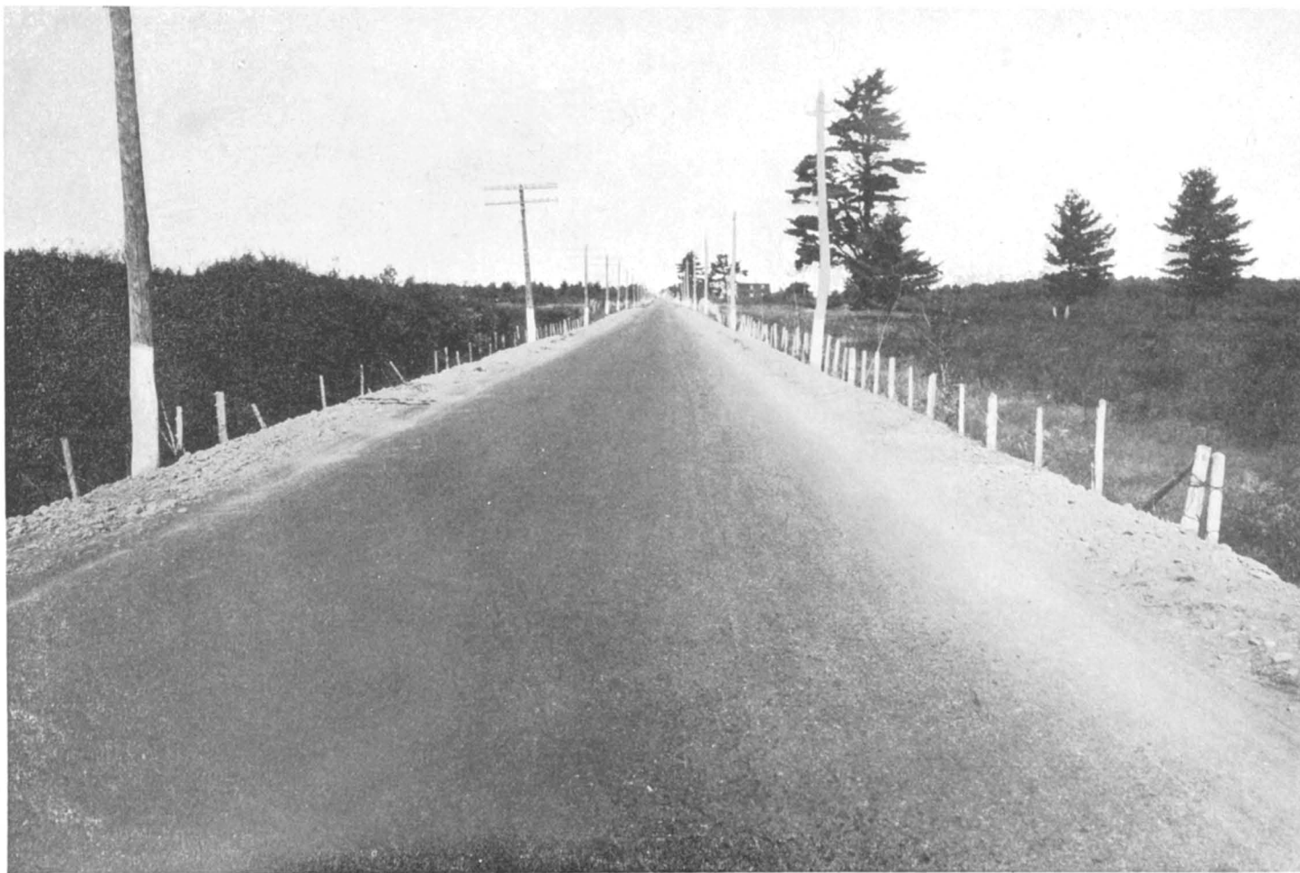
MONTRÉAL-MONT-LAURIER—Ste-Thérèse Revêtement en macurban posé en 1927 Macurban pavement laid in 1927
