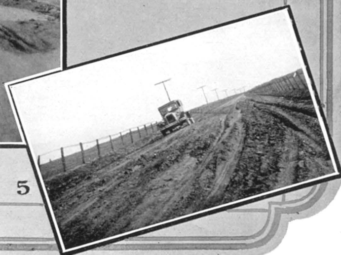
Dégâts causés par le dégel au printemps de 1926; 1-4. Route Montréal-Québec; 5. Route Joliette-St-Jacques, Crabtree Mills.
