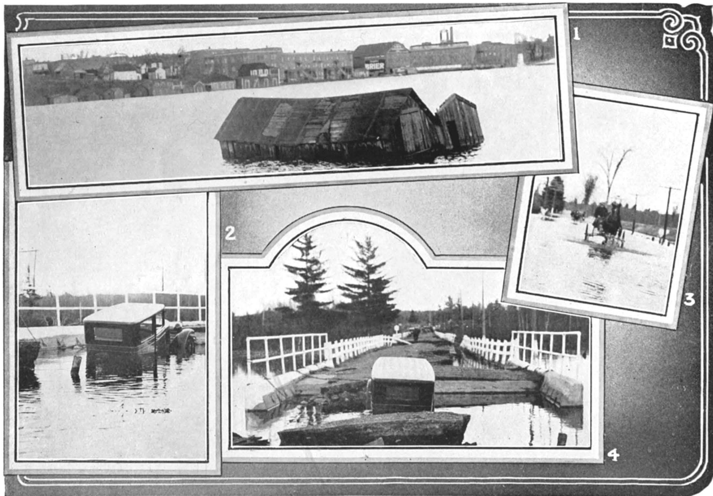
Vues des inondations des 3 et 4 novembre 1927, dans les Cantons de l'Est, durant lesquelles les routes subirent des dommages considérables.
