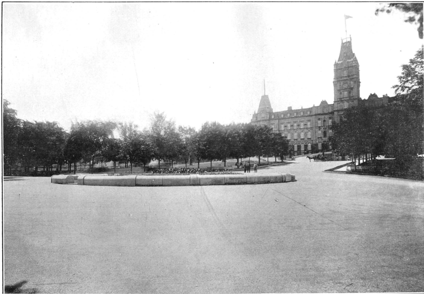
Avenue Dufferin, en face de l'hôtel du Gouvernement, Québec. Pavage en amiésite construit en 1926 sous la direction du ministère de la voirie.
