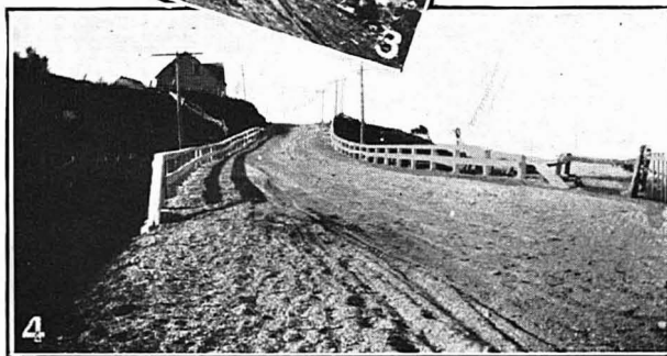
1. Route Lévis-Rimouski. Trois-Pistoles. Côte Tobin en construction; vieille côte à gauche; 2. Même endroit. Viaduc pour donner accès à la nouvelle côte. 3 et 4. Route Rimouski-Ste-Anne-des-Monts; N.-D. de McNider. Côtes des Boules (3) et de l'Eglise (4) améliorées en 1925.
