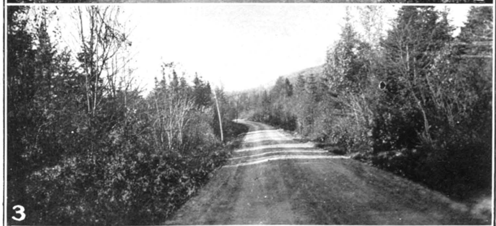
1. Chemin Haut du bord de l'eau, St-Vincent-de-Paul, Laval; 2. Route Lacolle-Knowlton, canton Bedford, Missisquoi; 3. Chemin du lac Beauport, N.-D.-des-Laurentides, Québec.
