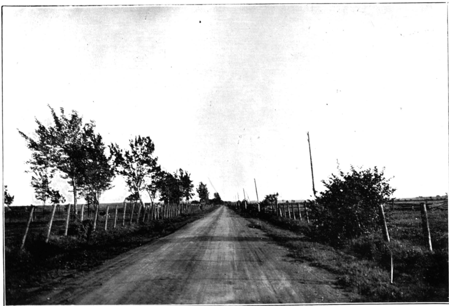
Route IBERVILLE-ST.ALBANS Highway—Pike-River, Missiquoi Macadam huilé entretenu par le département. Oiled macadam maintained by the Department.
