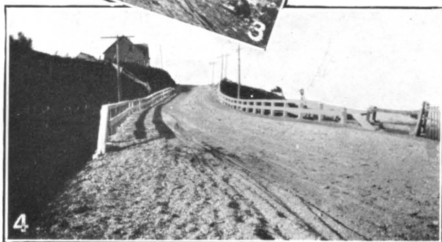
1. Route Lévis-Rimouski, Trois-Pistoles. Côte Tobin en construction; vieille côte à gauche; 2. Même endroit. Viaduc pour donner accès à la nouvelle côte. 3 et 4. Route Rimouski-Ste-Anne-des-Monts; N.-D. de McNider. Côtes des Boules (3) et de l'Eglise (4) améliorées en 1925.
