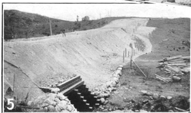
1, 2 et 3. Travaux de protection sur la route Montréal-Québec à St-Sulpice; 4 et 5. Construction d'un pont sur le ruisseau Cauchon, village Mont-Laurier route Montréal-Mont-Laurier.
