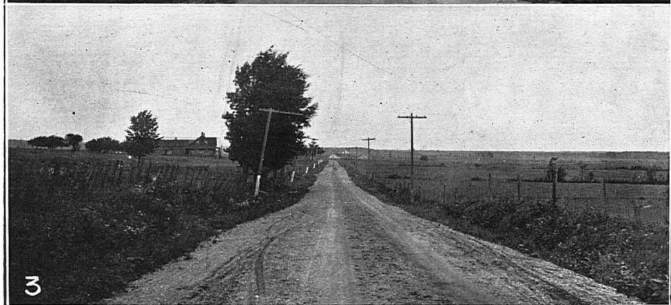
1. St-Louis-de-Terrebonne ; chemin en macadam construit à la sortie du pont David ; 2. Ste-Geneviève-de-Pierrefonds, Jacques-Cartier ; macadam refait en 1924. 3. L'Avenir, Drummond (rte Richmond-Yamaska) ; macadam rechargé de gravier.
