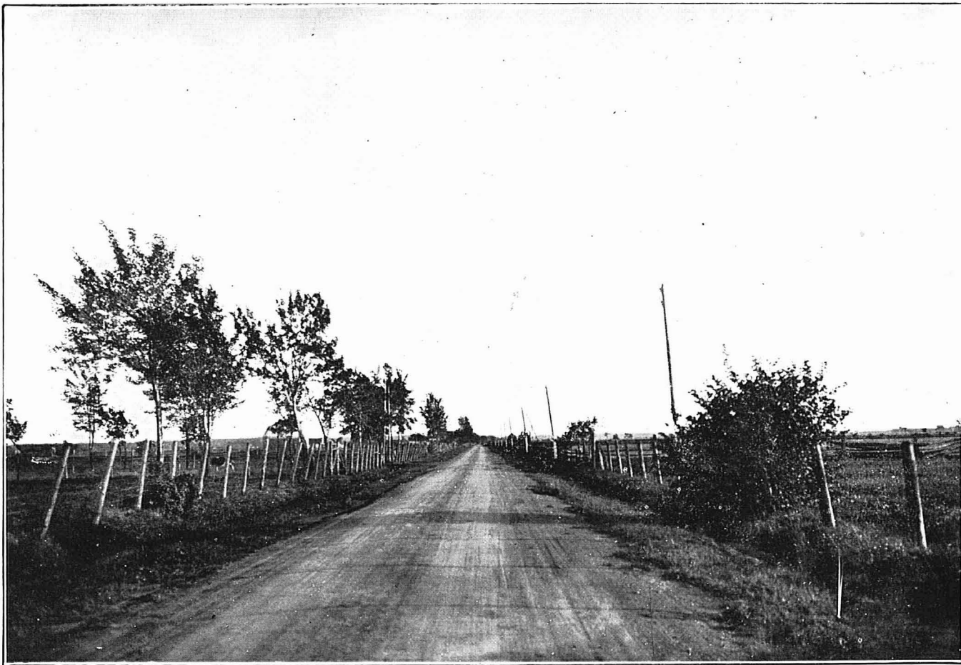
Route IBERVILLE-ST.ALBANS Highway—Pike-River, Missiquoi Macadam huilé entretenu par le département. Oiled macadam maintained by the Department.
