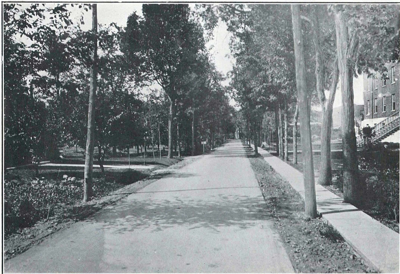
Ville de Marieville, Rouville.—Route Montréal-Sherbrooke.—Rue Poulin.—Béton, 1923.
