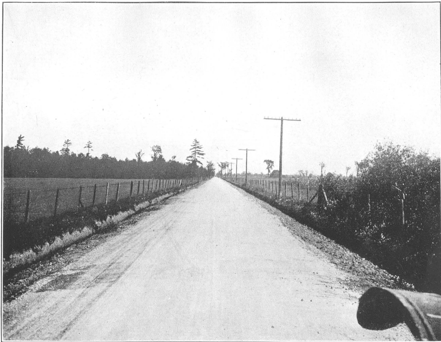
SAINTE-MARTINE, CHATEAUGUAY, (route Caughnawaga-Malone).—Macadam bitumineux, fait en 1921.
