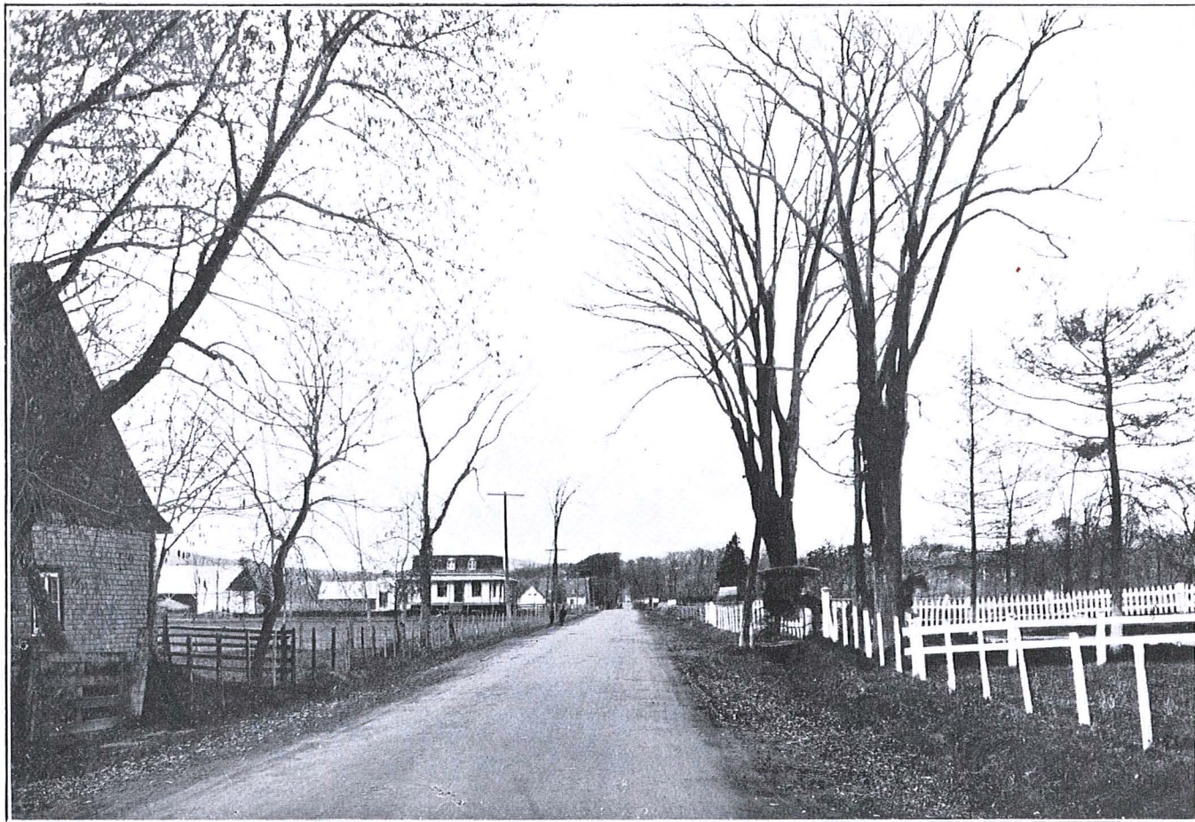
Village de Charlesbourg, Québec.—Chemin du Lac Beauport.—Macadam bitumineux.
