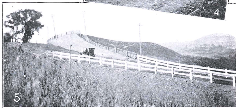
Route Québec-St-Siméon.—Paroisse de la Malbaie.—Côte Gagnon.—1 et 2: Avant les travaux d'abaissement; 3 4 et 5: après les travaux d'abaissement.
