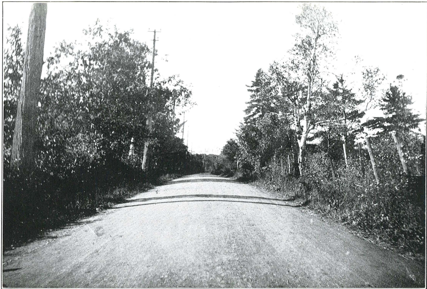
SILLERY, COMTÉ DE QUÉBEC, (Chemin Gomin).—Macadam réparé et traité au goudron froid (1921).
