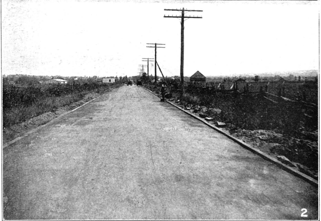
Route Montréal-Québec. Confection du béton asphaltique en 1919, à L'ancienne-Lorette.—1. Usine des entrepreneurs Laganière, Houde & Cie.— 2. Couche de fondation en macadam prête à recevoir le béton asphaltique.
