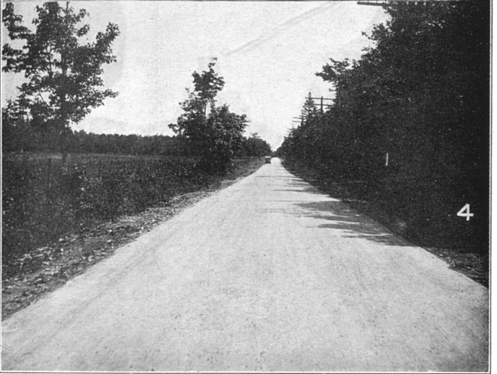
3. Application de la couche de béton asphaltique.—4. Le chemin terminé.
