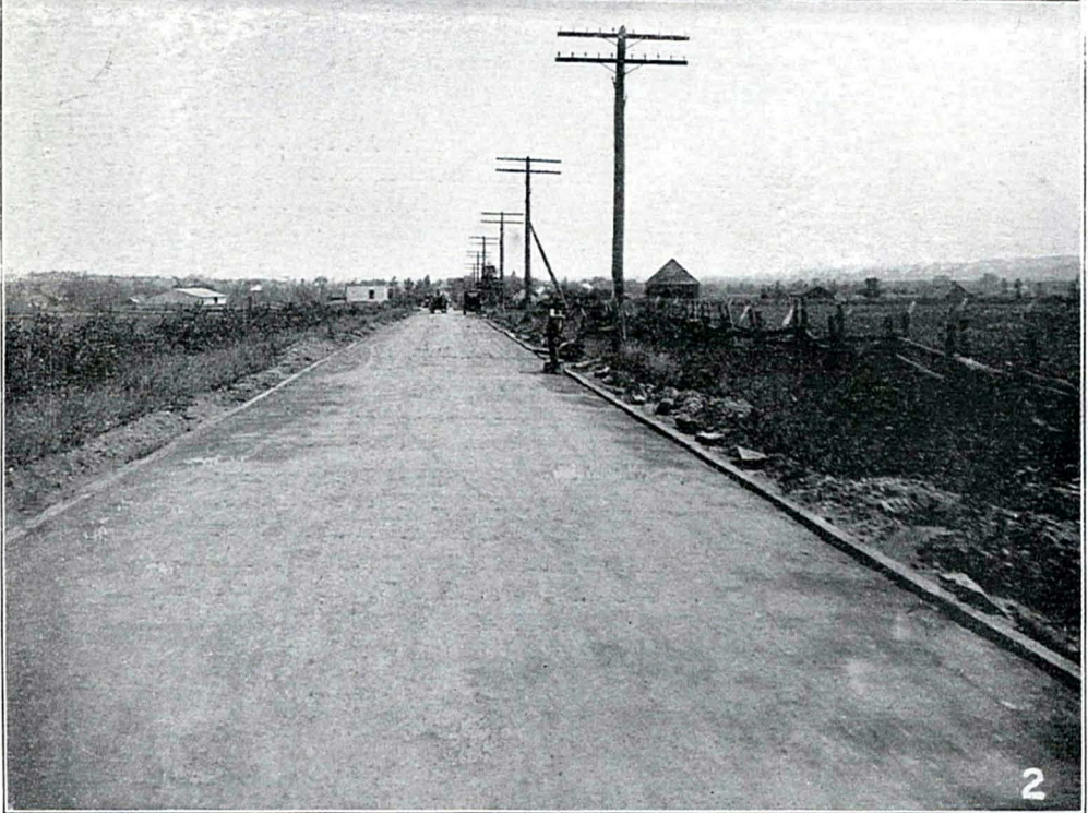
Route Montréal-Québec. Confection du béton asphaltique en 1919, à L'ancienne-Lorette.—1. Usine des entrepreneurs Laganière, Houde & Cie.— 2. Couche de fondation en macadam prête à recevoir le béton asphaltique.
