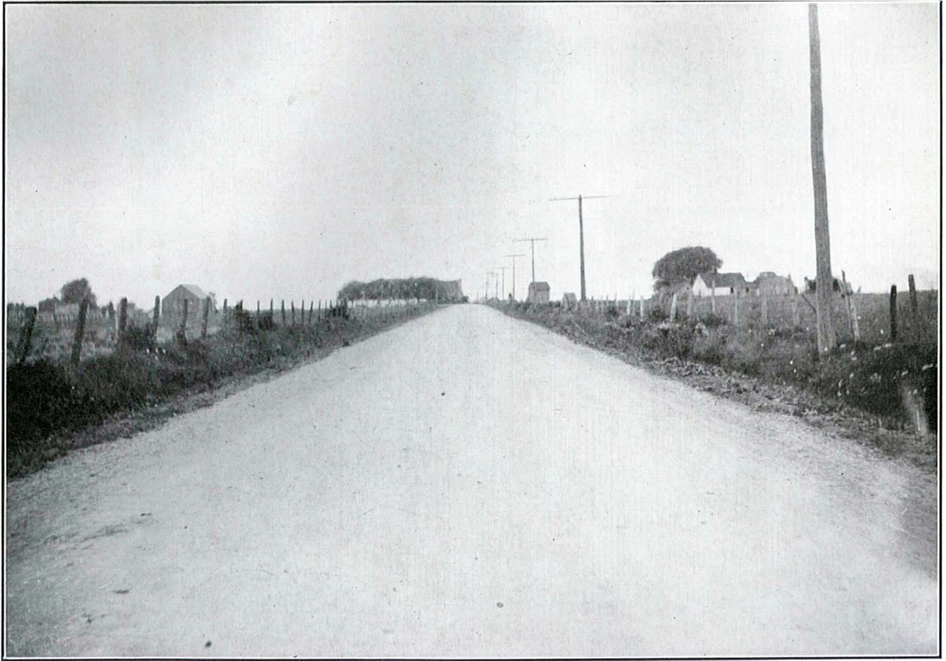
Laprairie, paroisse, chemin Brosseau. Macadam bitumineux (pénétration) fait en 1920.
