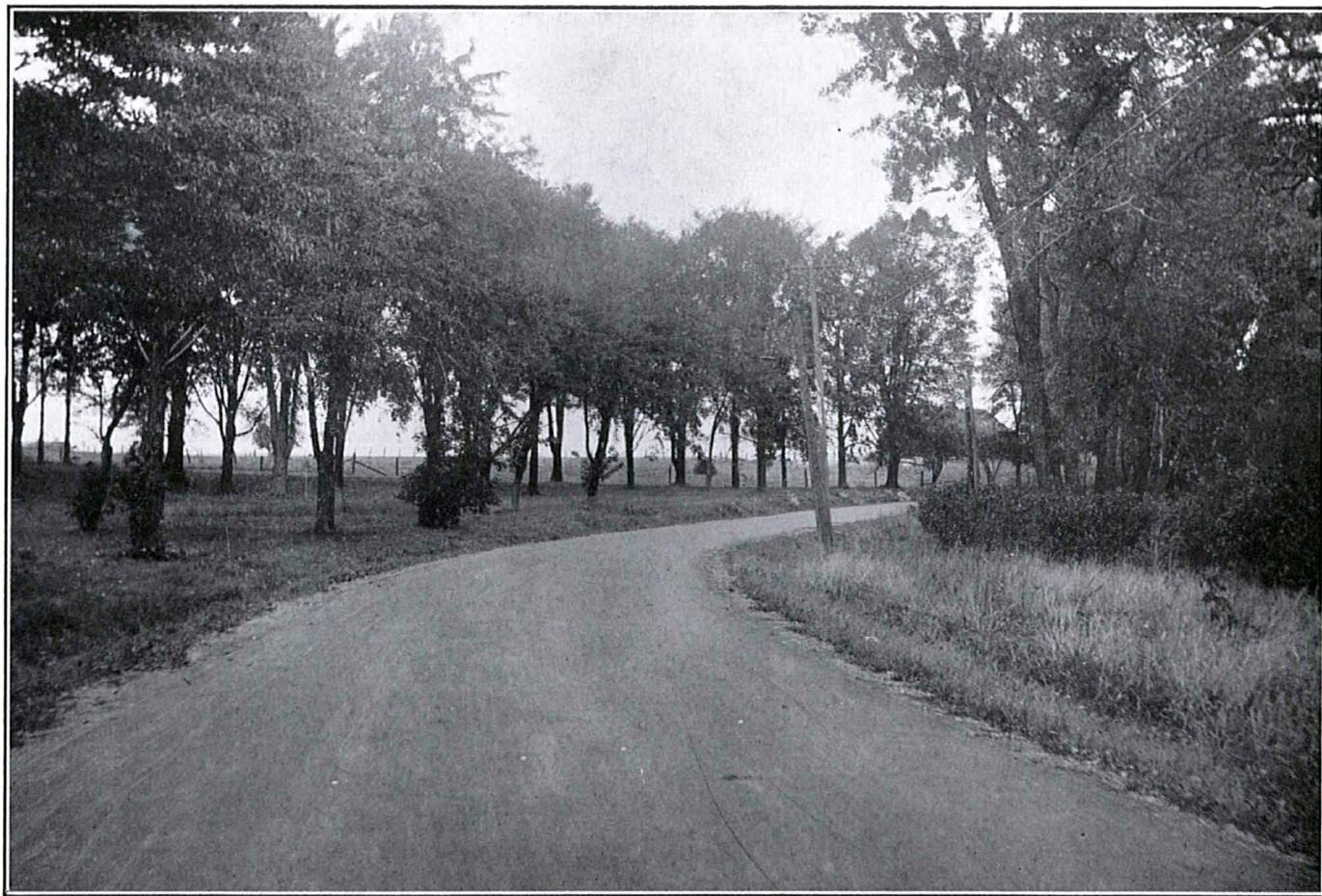
Ville de Baie-d'Urfé, comté de Jacques-Cartier. Macadam bitumineux (pénétration) fait en 1919.
