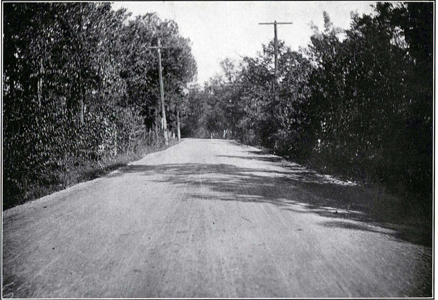
Village de Saraguay, comté de Jacques-Cartier. Macadam bitumineux (pénétration) fait en 1920.
