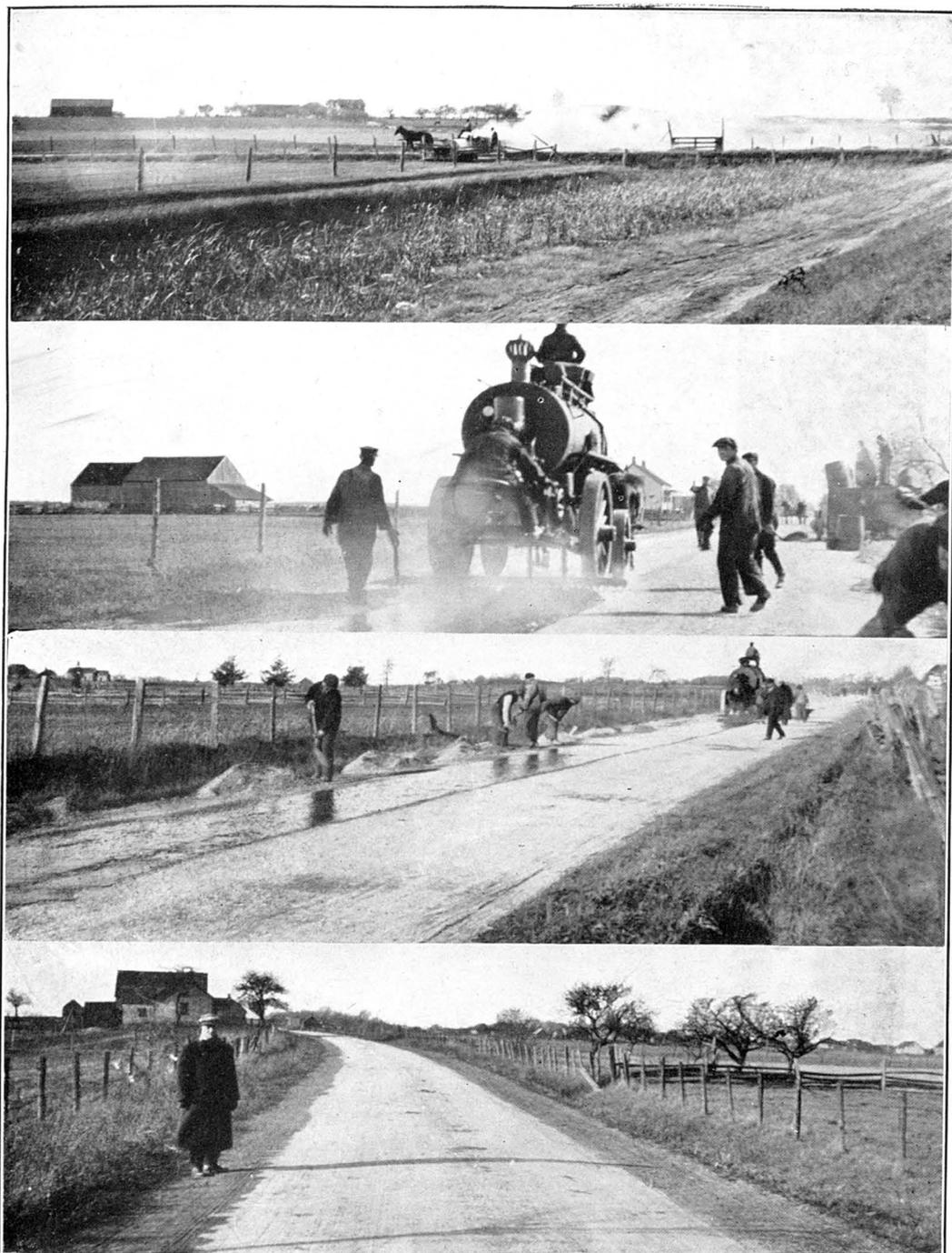
5.—Route Edouard VII.—Paroisse de Napierville (Napierville). Chemin traité au fluxphalte (de haut en bas) (a) Balayage du chemin au moyen de la balayeuse mécanique; (b) application du fluxphalte au moyen du distributeur à pression; (c) pose du gravier sur le fluxphalte; (d) chemin terminé.]
