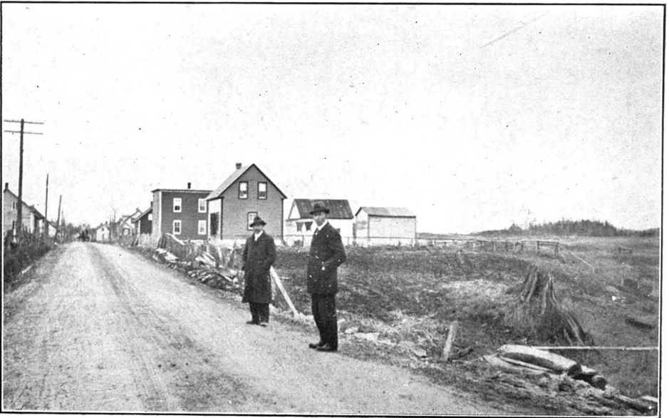
No 32.—Ste-Thècle, village (Champlain). Route de la station après le macadamisage en 1914
