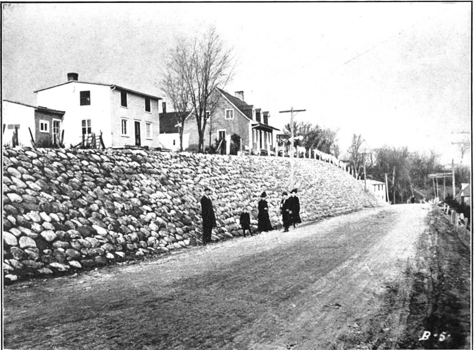
No 21.—Route Montréal-Québec. Même endroit que celui de la photogravure précédente. Vue faisant voir spécialement le mur en pierres sèches qui protège le talus. Travail fait en 1914
