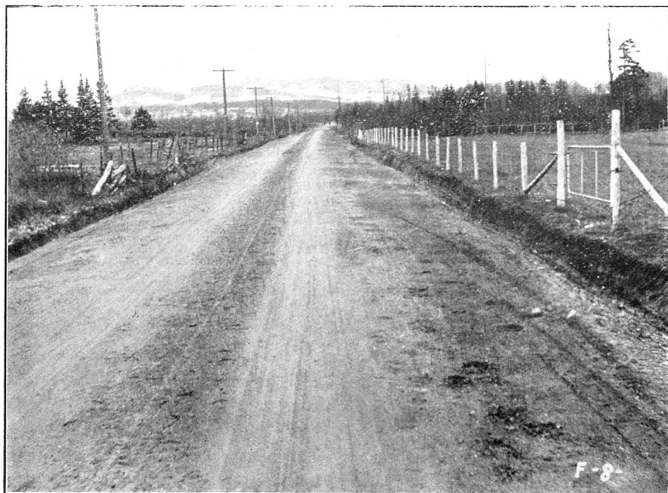
No 33.—Canton de Brome (Brome). “Valley Road” gravelage fait en 1914
