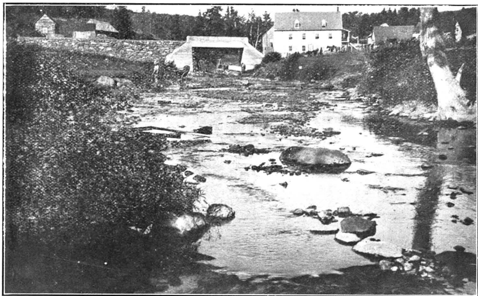
No 17.—Route Lévis-Jackman. Saint-Joseph (Beauce). Redressement de chemin à la rivière Caldwell. Remblai et pont. Premiers travaux (1914)
