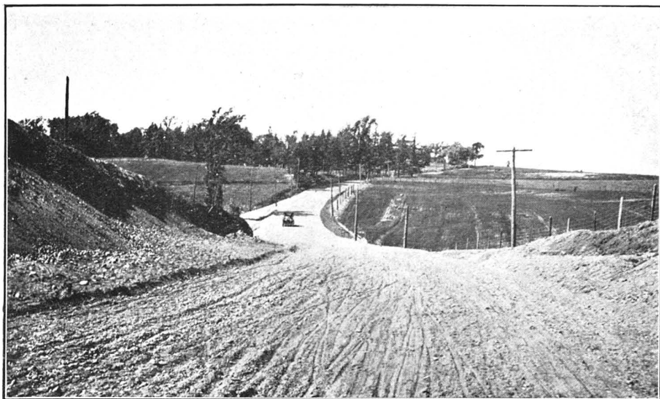
No 12.—Route Lévis-Jackman. Sainte-Marie (Beauce). A gauche on voit le déblai fait pour le banc de gravier. Au fond, le remblai. (1914) Côte Bédard
