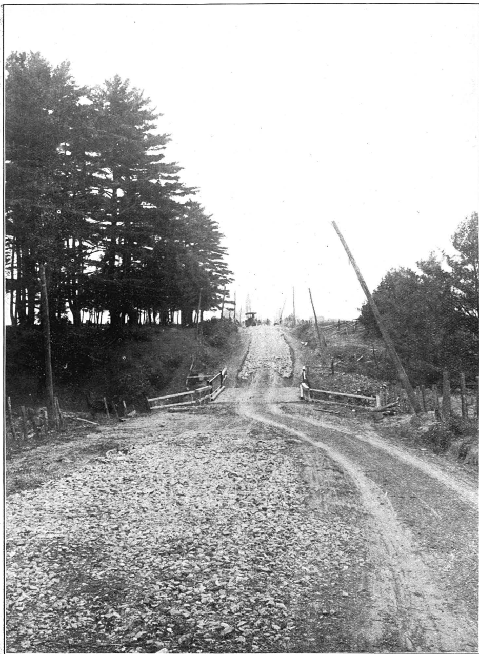
N° 29—La-Baie, comté d'Yamaska. Travaux préliminaires au macadamisage (1913)
