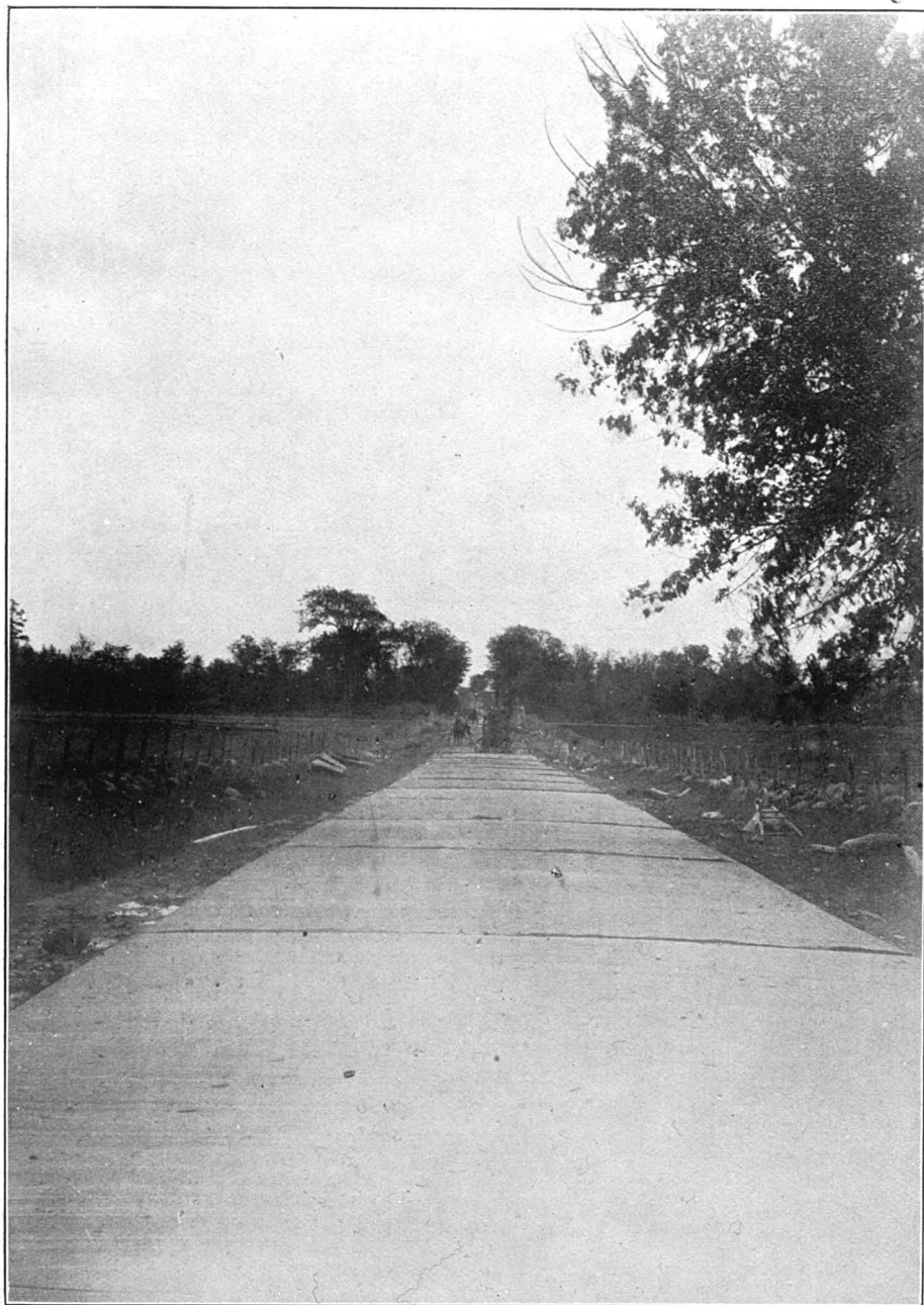
N° 11—Montée de Sainte-Rose, comté de Laval. } Chemin en béton fait en 1913. (La montée de Sainte-Rose aura une longueur totale de 6\frac{1}{2} milles)
