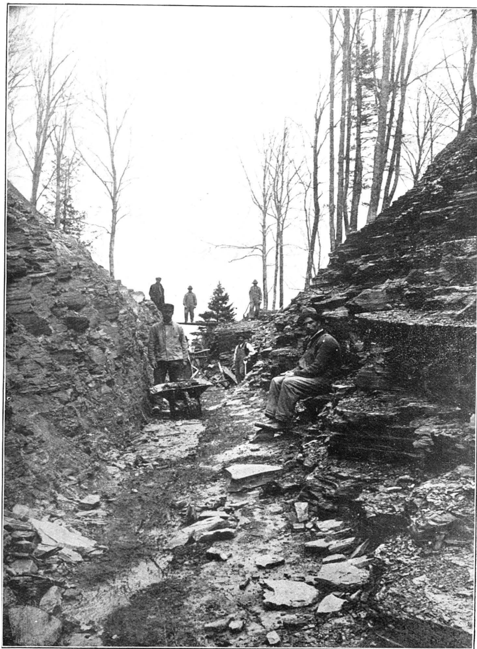
N° 34—Route Montréal-Québec. Tranchées pour redressement du chemin au moulin "Martel", à Saint-Augustin, comté de Portneuf
