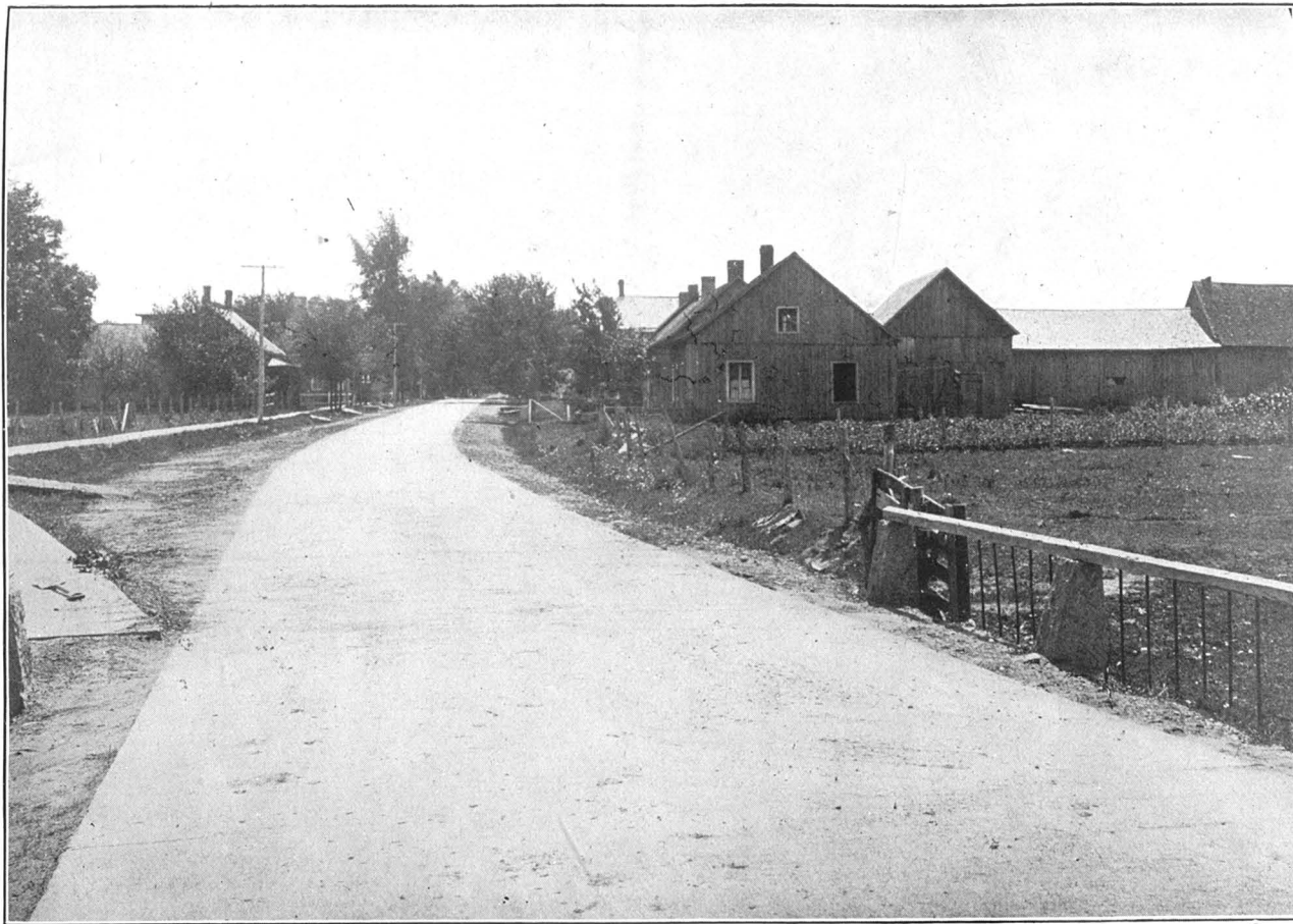
N° 4—Route Edouard VII.—Village de Napierville. Pavage en béton
