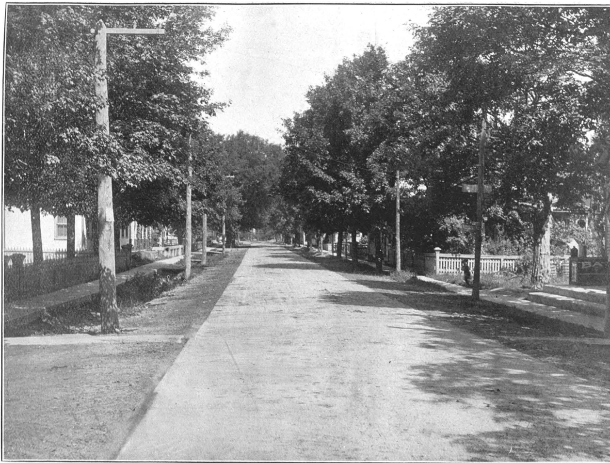
N° 3—Route Edouard VII.—Village de Napierville. Le même chemin après la construction du pavage en béton
