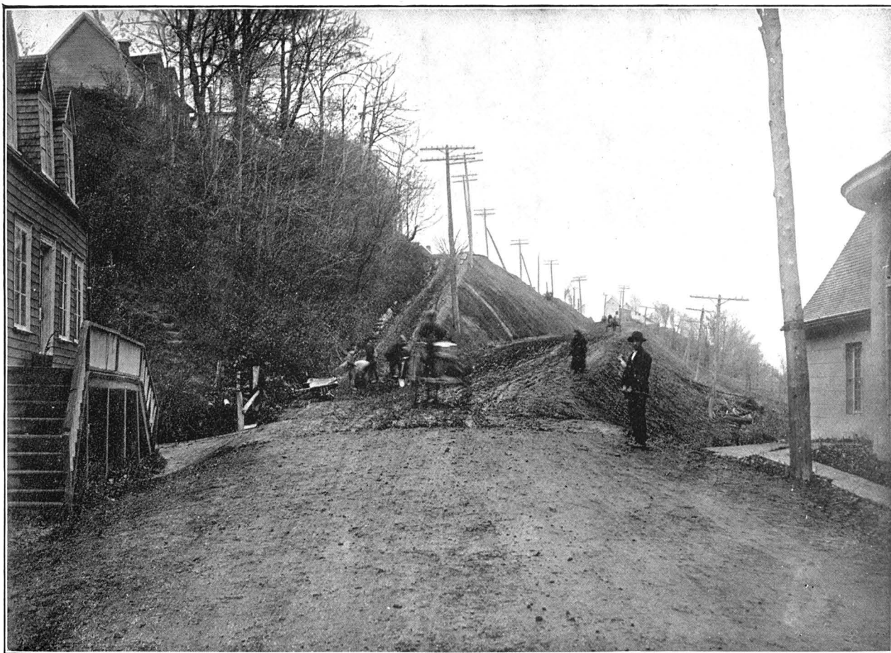
N° 36—Route Montréal-Québec, Les Ecureuils, comté de Portneuf. A gauche, l'ancien chemin; à droite, la coupe où sera construit le nouveau chemin
