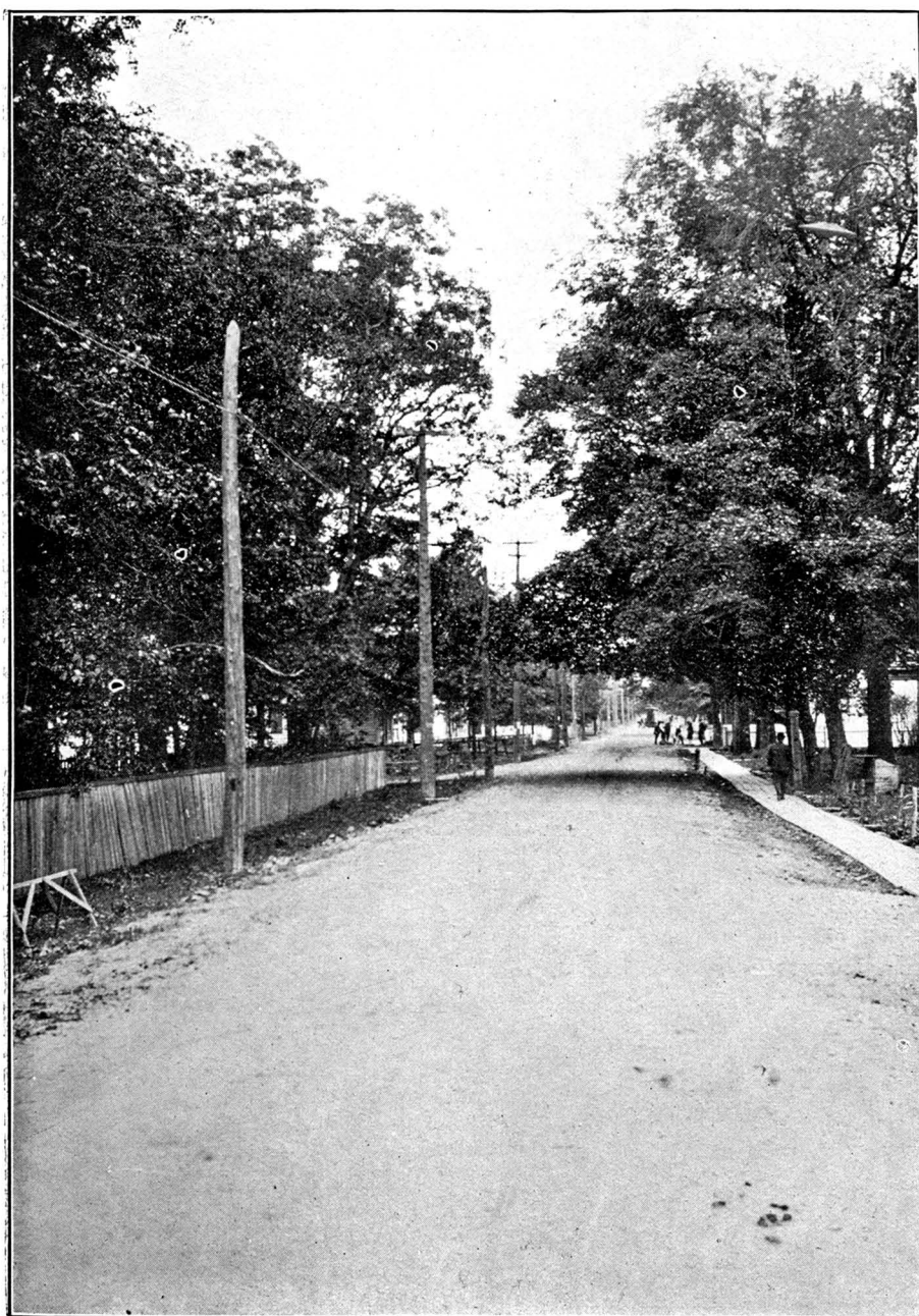
Chambly-Canton.—Rue Burgoyne, macadamisée en 1912.
