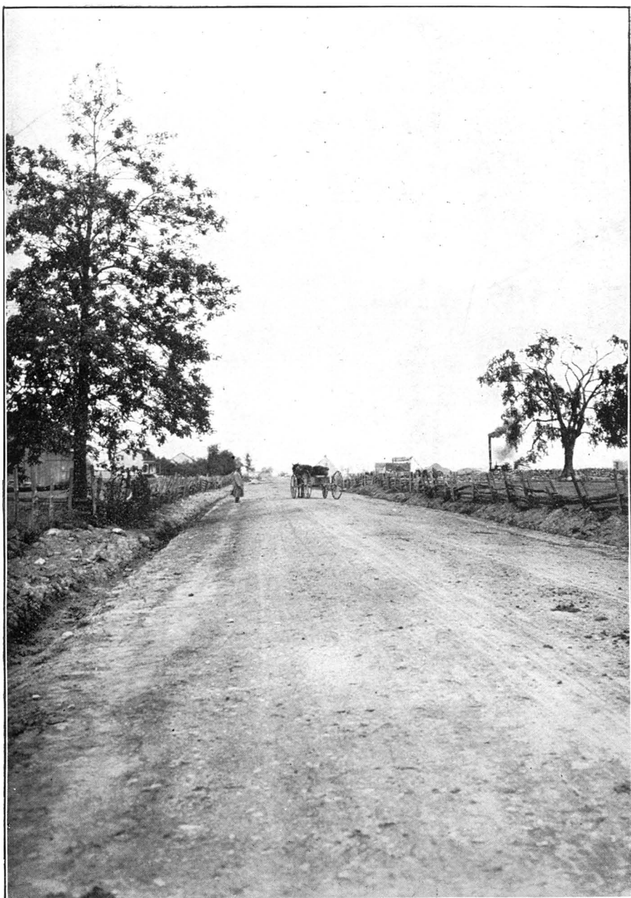
Route Edouard VII.—Après le macadamisage, sur la section No 23, municipalité de St-Jacques.
