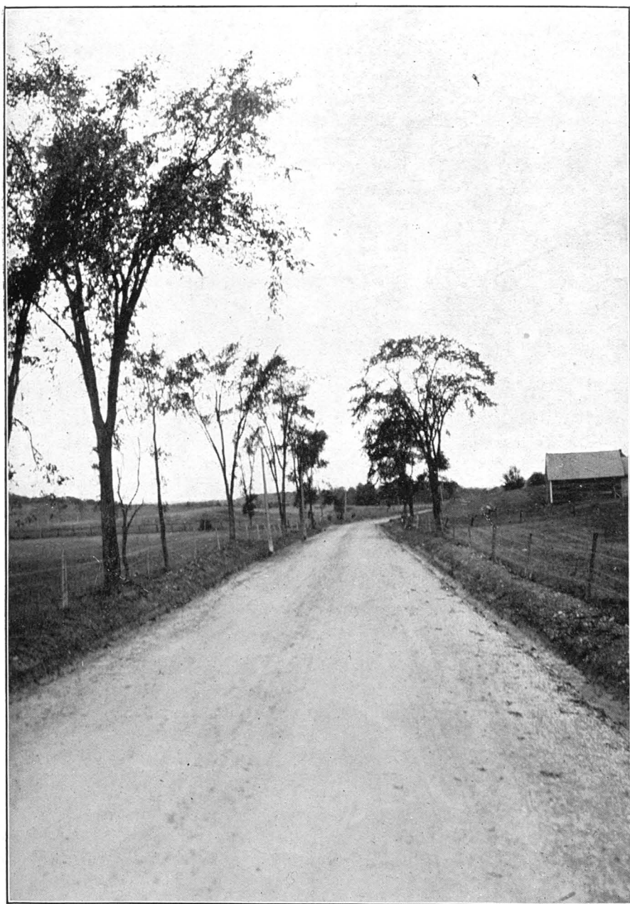
Partie du chemin de Milby, dans le canton Compton, macadamisé en 1912.
