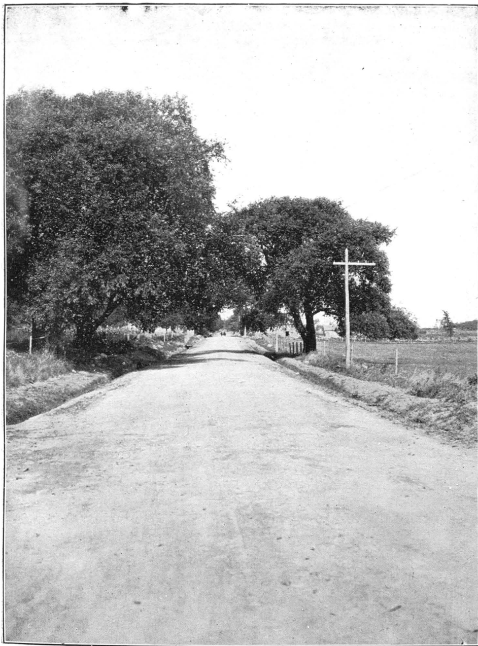
Route Edouard VII.—Macadam sur la section No 1, municipalité de St-Bernard-de-Lacolle, vis-à-vis la propriété de Geo. Cookman.
