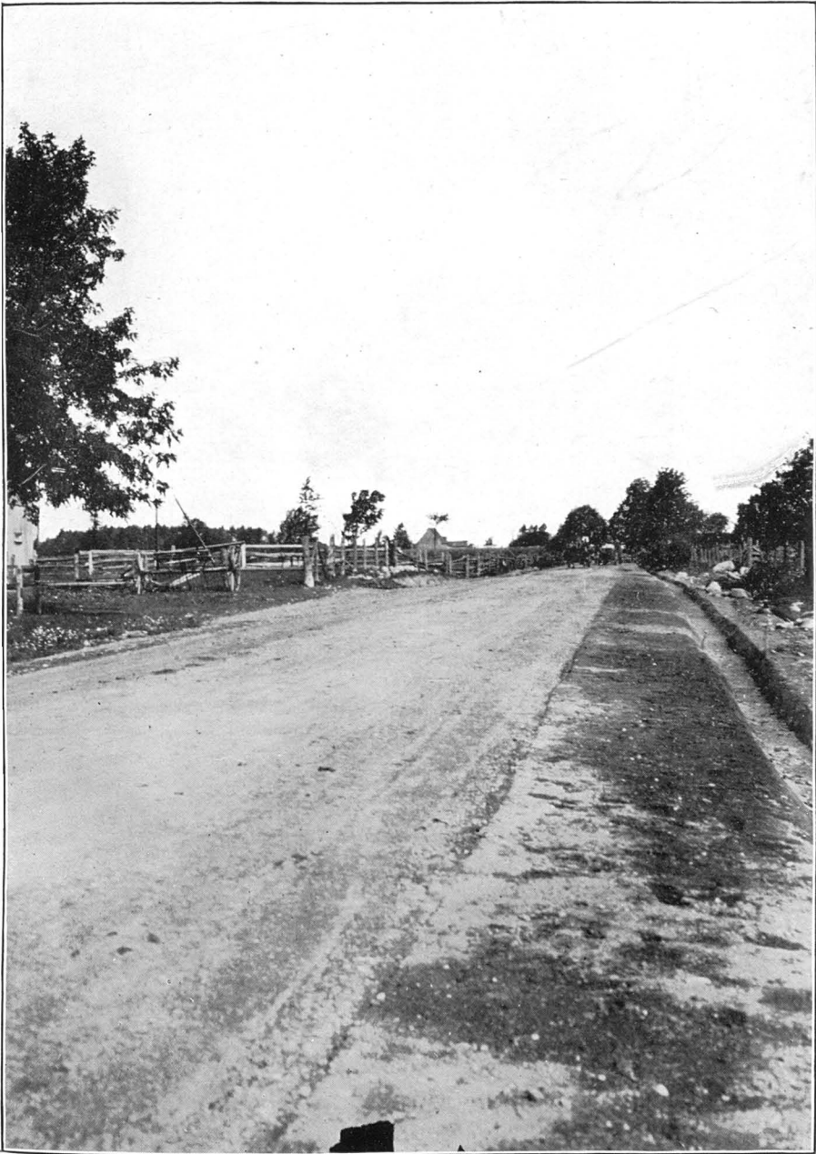
Route Edouard VII.—Macadam sur la section No 9, municipalité de Napierville, vis-à-vis la propriété de David Bélanger.
