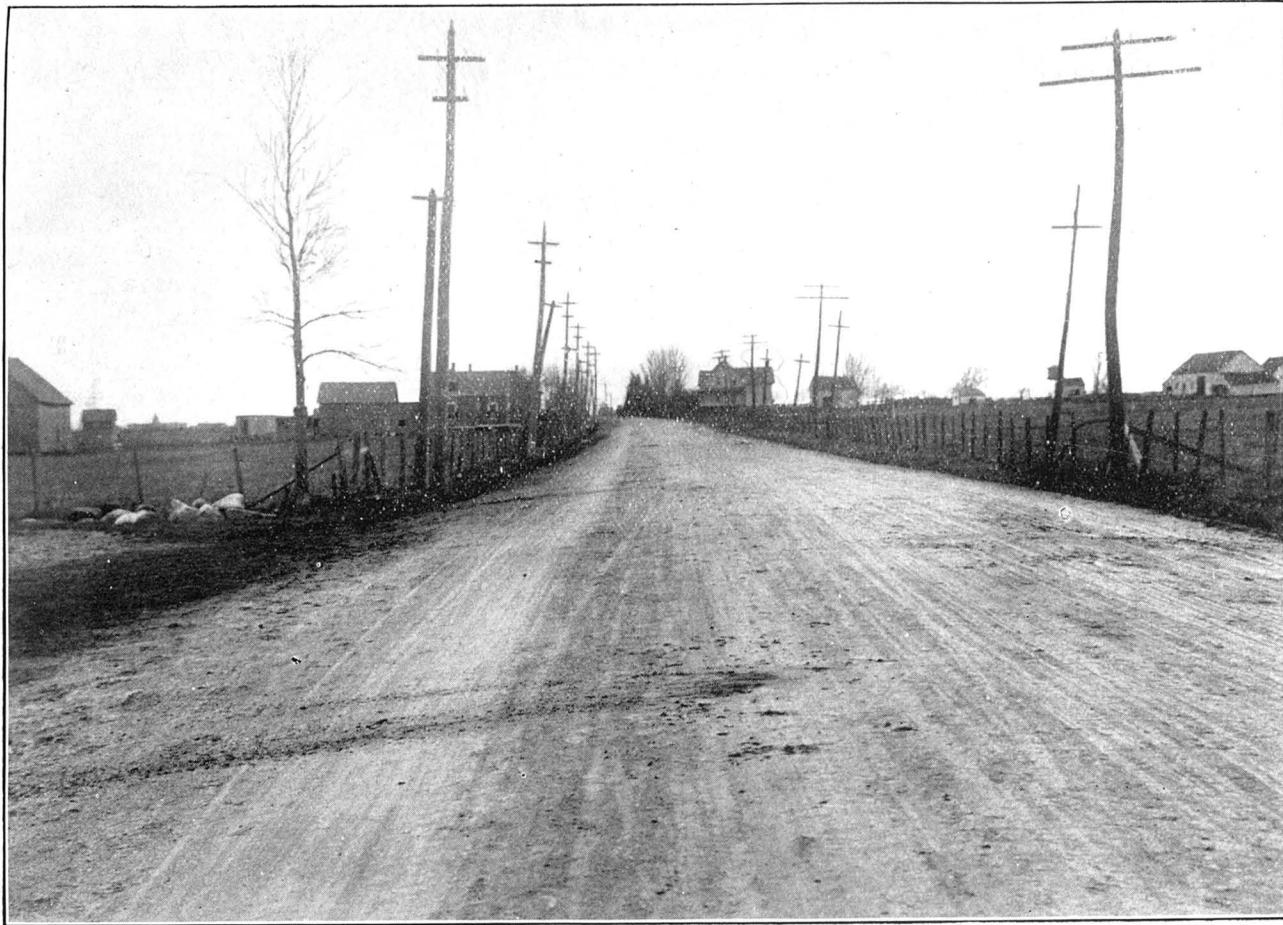
Macadam construit en 1911 sur la route de Victoriaville à Arthabaskaville
