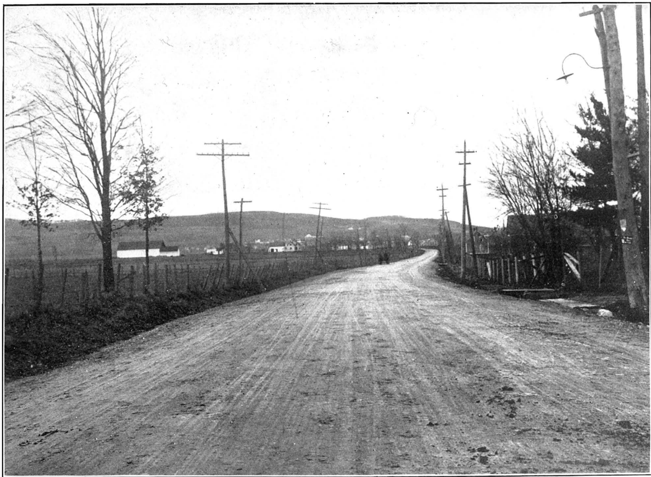
Macadam construit en 1911 sur la route de Victoriaville à Arthabaskaville
