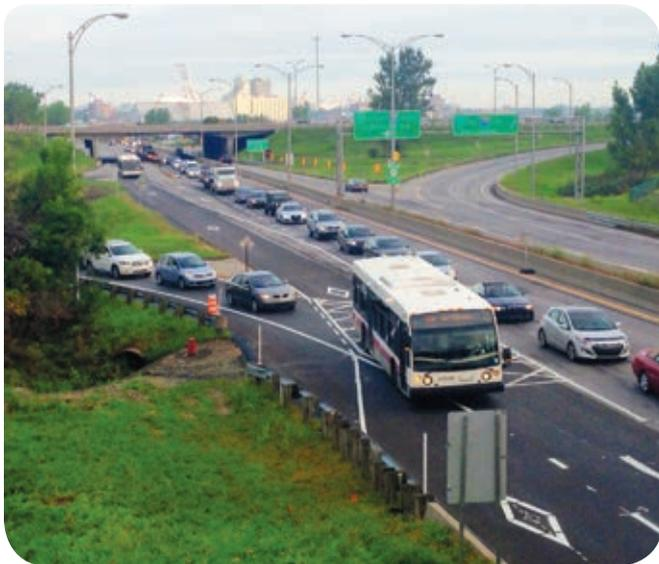
La sortie 82 de l'A-20/R-132 Ouest étant dorénavant exclusivement réservée aux autobus, les automobilistes utilisent uniquement la sortie du parc Marie-Victorin, dont la bretelle a été élargie et allongée afin d'accroître la capacité. Dès la mise en service, cette nouvelle configuration a démontré qu'elle ne provoquait pas de retards supplémentaires pour les automobilistes, confirmant ainsi les modélisations de circulation effectuées lors de la planification du projet.
