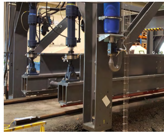
Plateforme SISYPHE utilisée pour le test de la structure ferroviaire du projet REVES
