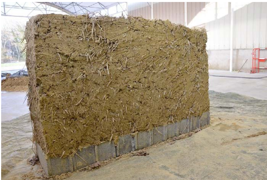
Mur en bauge réalisé à l'aide d'un malaxeur qui réduit la teneur en eau de fabrication et accélère le procédé.
