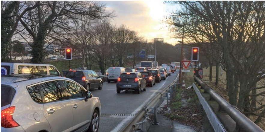
Accès régulé sur l'A86 E (Vélizy) mis en service décembre 2016
