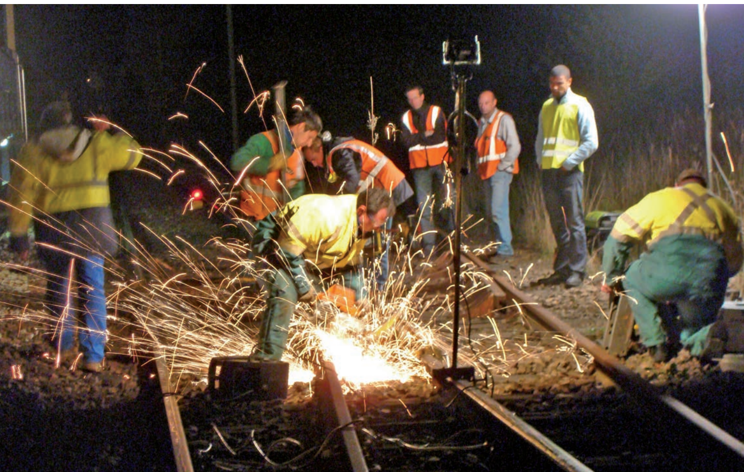
Meulage dans un chantier nocturne de remplacement d'aiguillage
