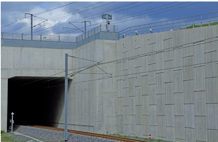
Connexion de l'instrumentation du massif de sol renforcé (procédé Terre Armée) pour observer son comportement en dynamique rapide lors du passage des TGV
