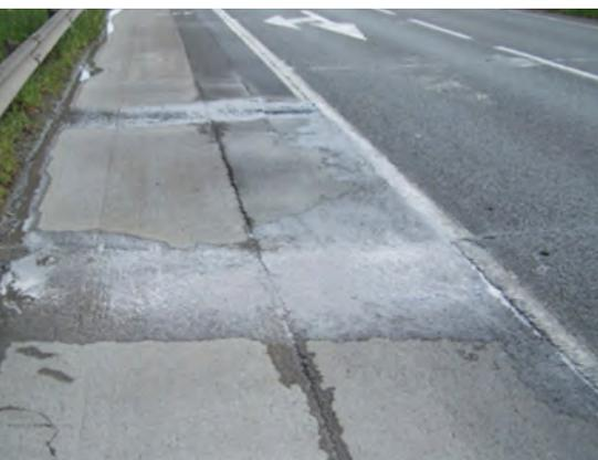
Cette photo prise sur une route du Nord de la France, illustre un problème fréquent de résurgence d'eau à la jonction entre deux structures de perméabilité différentes : l'eau piégée dans les matériaux remonte à la surface sous les contraintes du trafic routier et génère une fatigue anormale de la structure (crédit photo Cerema Nord Picardie)
