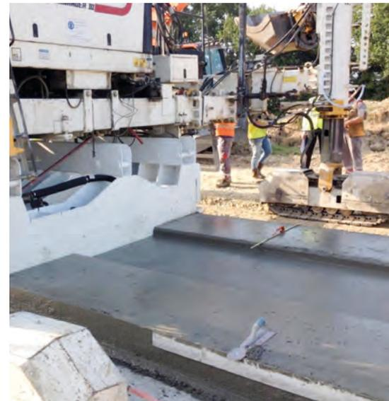
Réalisation du démonstrateur de voie de roulement avec machine à coffrage glissant
