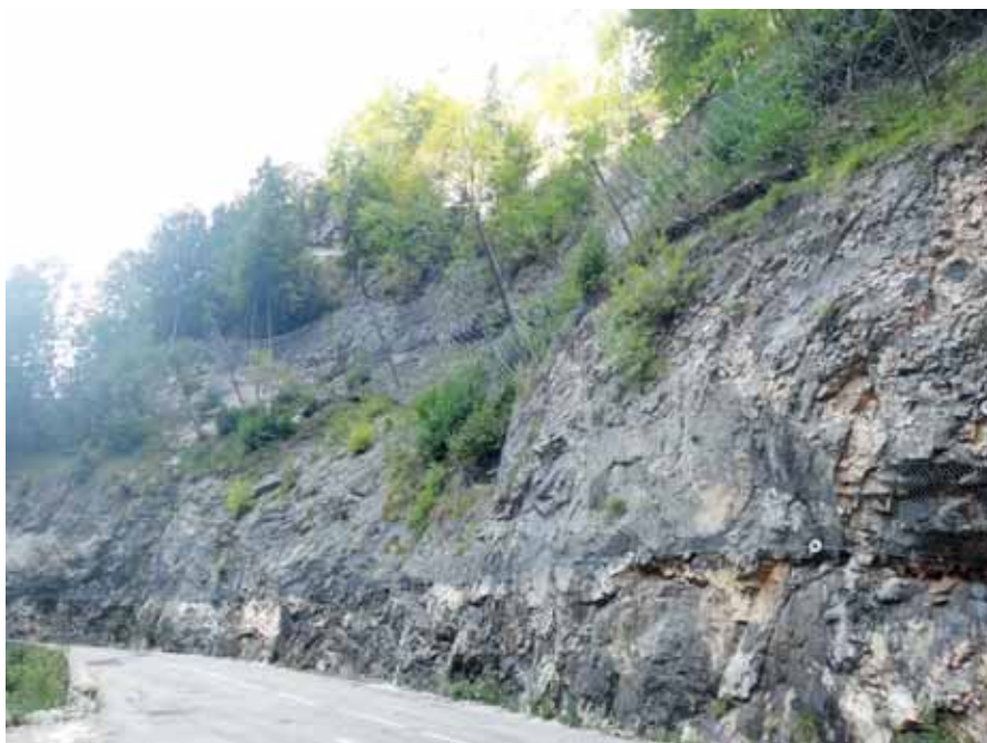
LES FILETS PARE-BLOCS, ÉLÉMENTS DE SÉCURITÉ ROUTIÈRE
