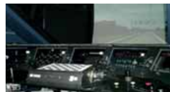
BANC DE CONTRÔLE COMMANDE
