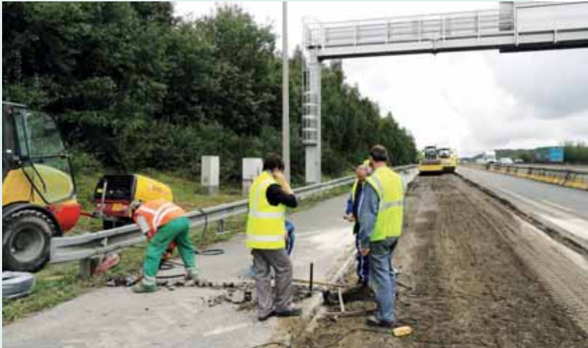
MISE EN PLACE DE CAPTEURS IN SITU
