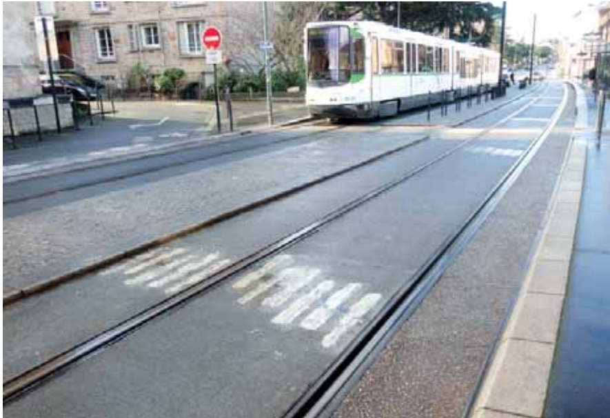
VOIE DE TRAMWAY APRES RÉPARATION DES FISSURES
