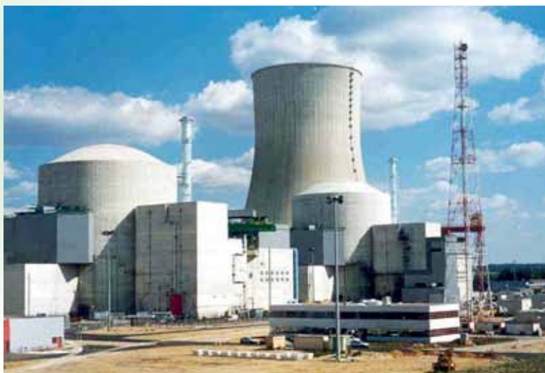
ENCEINTE DE LA CENTRALE DE CIVAUX
