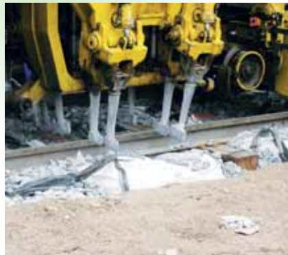
IMPACT DU BOURRAGE SUR LES CARACTÉRISTIQUES GÉOMÉTRIQUES DU BALLAST (IFSTTAR/SNCF)
