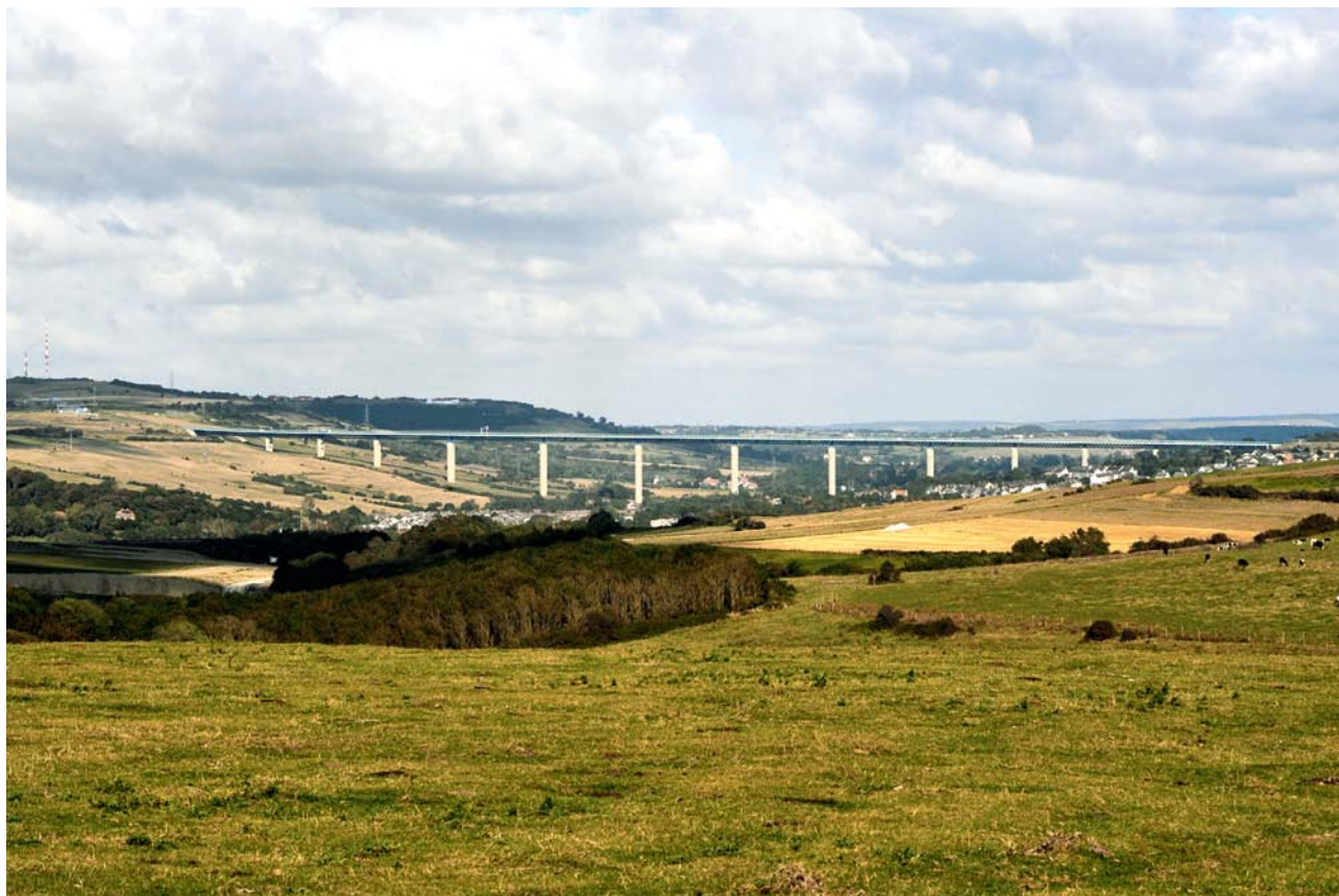
Viaduc d'Echinghen dans le Pas de Calais
