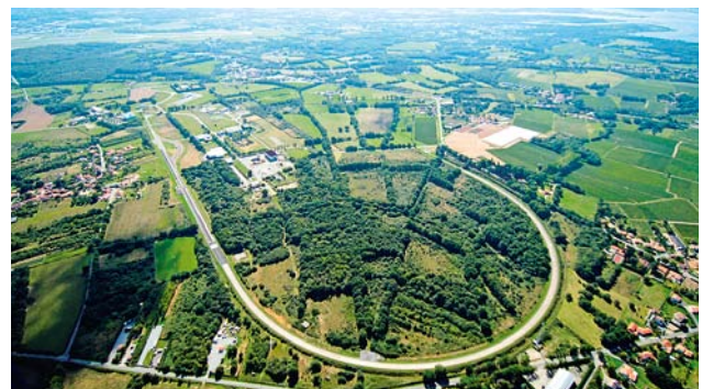
Vue aérienne du site de Nantes, dont la piste d'essai qui ceinture le centre
