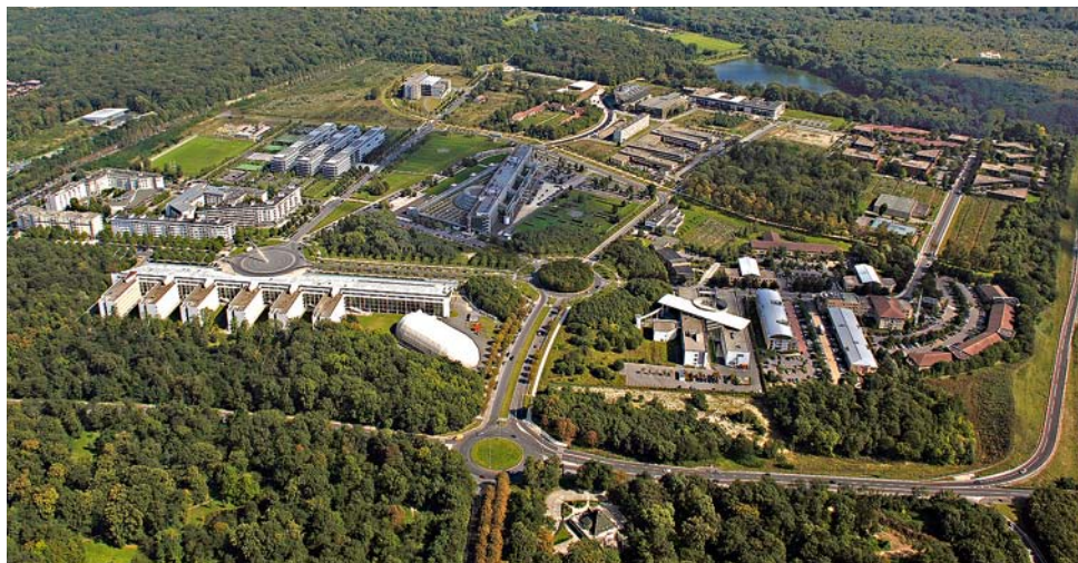
Vue aérienne de la cité Descartes à Marne-la-Vallée
