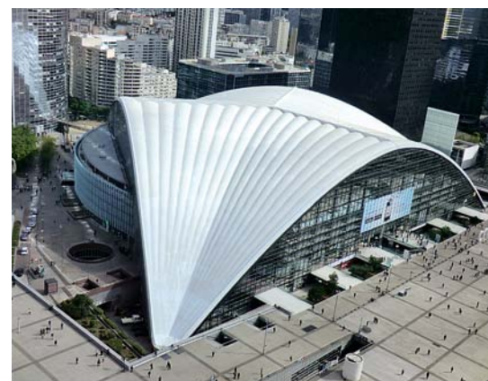
Le Cnit, monument historique, connaît des mouvements en sous-sol
