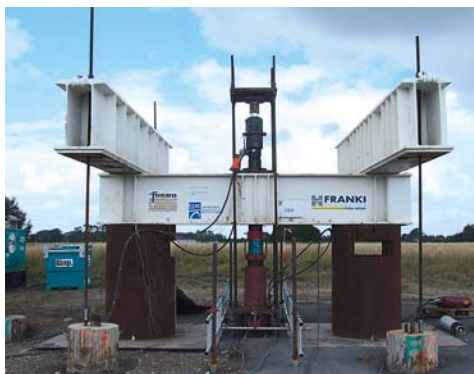
Chantier expérimental pour le calcul des fondations profondes
