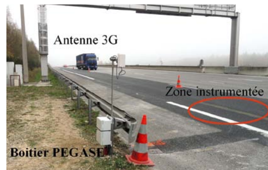
Section instrumentée sur l'autoroute A10
