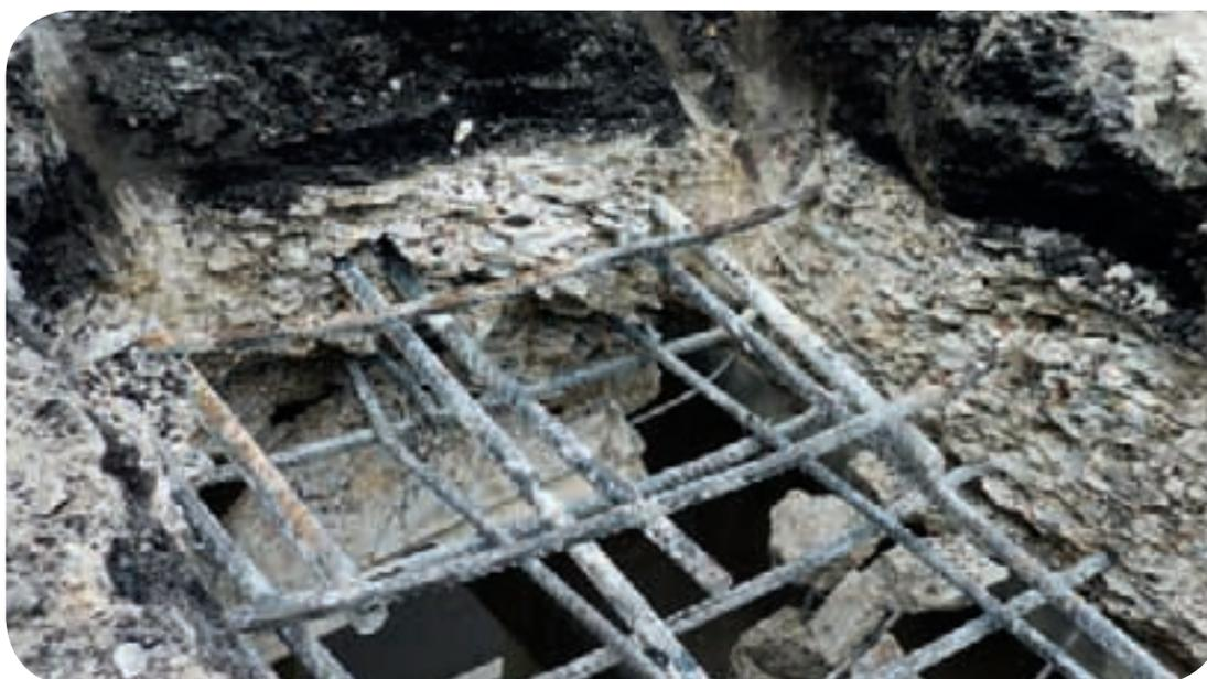
» Dégradation du béton par feuilletage.
