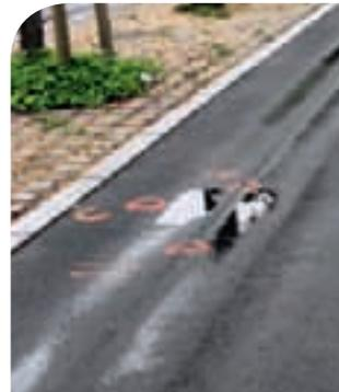
» Orniérage d'une voie de Busway, au niveau d'une zone d'arrêt du Busway.
