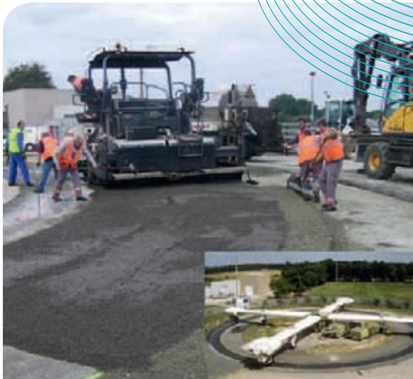
» Construction des structures RECYROUTE sur le Manège de fatigue de l'Ifsttar.
