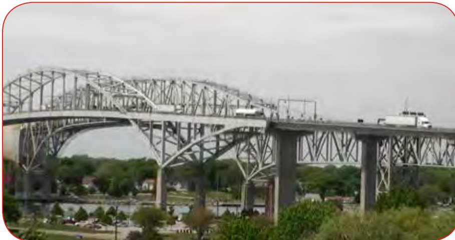
Prise de vue à partir de Point Edward, des deux arches du pont Blue Water
