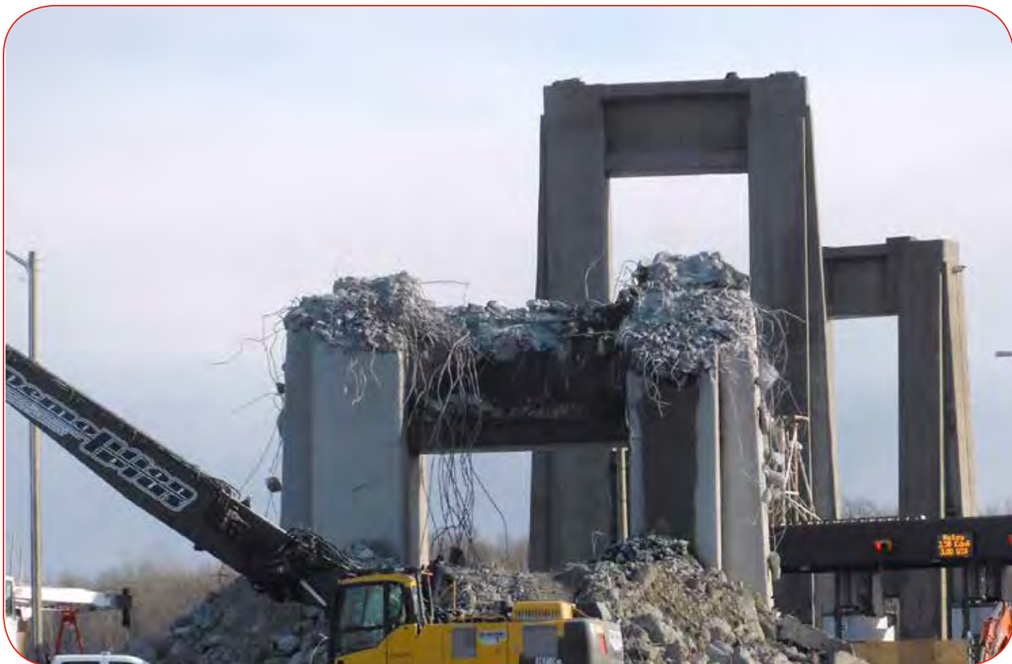
La collecte des péages se poursuit simultanément avec la dernière phase de la démolition du pont du chenal nord au pont international de la voie maritime à Cornwall
