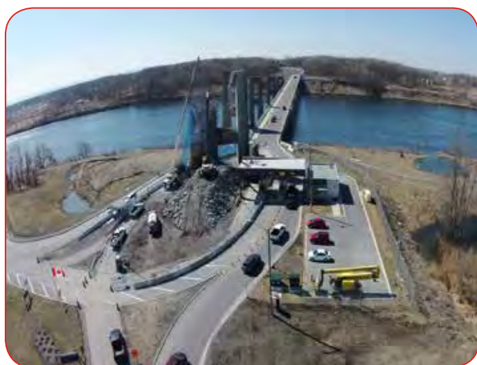
Vue aérienne de l'esplanade des péages au pont du chenal nord
