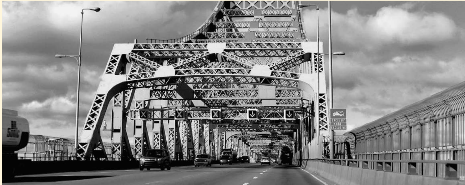
Vue de la travée à cinq voies du pont Jacques-Cartier avec le trottoir à droite et la piste cyclable au fond à gauche, en direction de Montréal.
