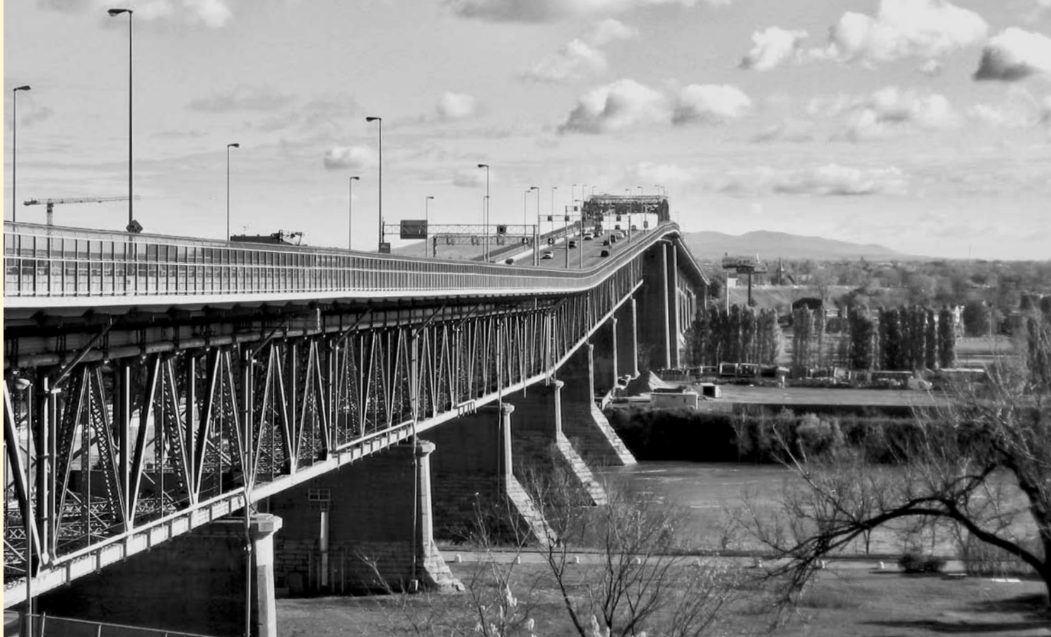
La construction de la Voie maritime du Saint-Laurent dans les années 50 a forcé la surélévation d'une partie du pont Jacques-Cartier pour accommoder le passage des grands bateaux pour le commerce.
