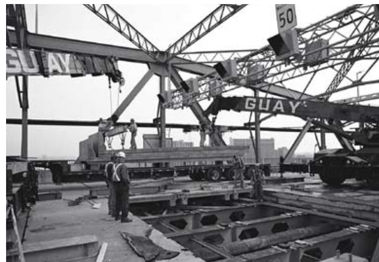
↑ Travaux de remplacement du tablier du pont Jacques-Cartier en 2001-2002 qui serviront de modèle pour le projet de réfection du pont Honoré-Mercier.
