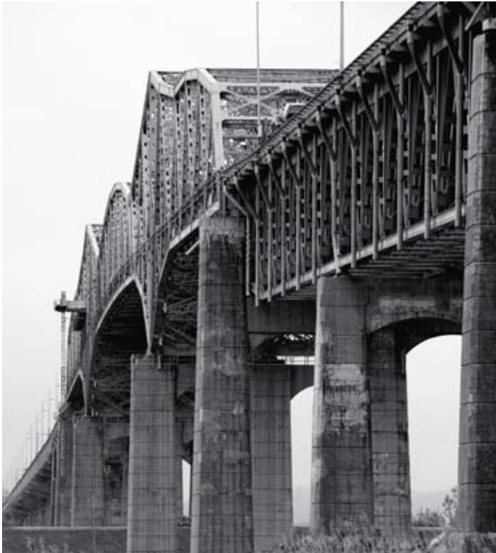
↑ Superstructure du pont Champlain vue de la Rive-Sud
