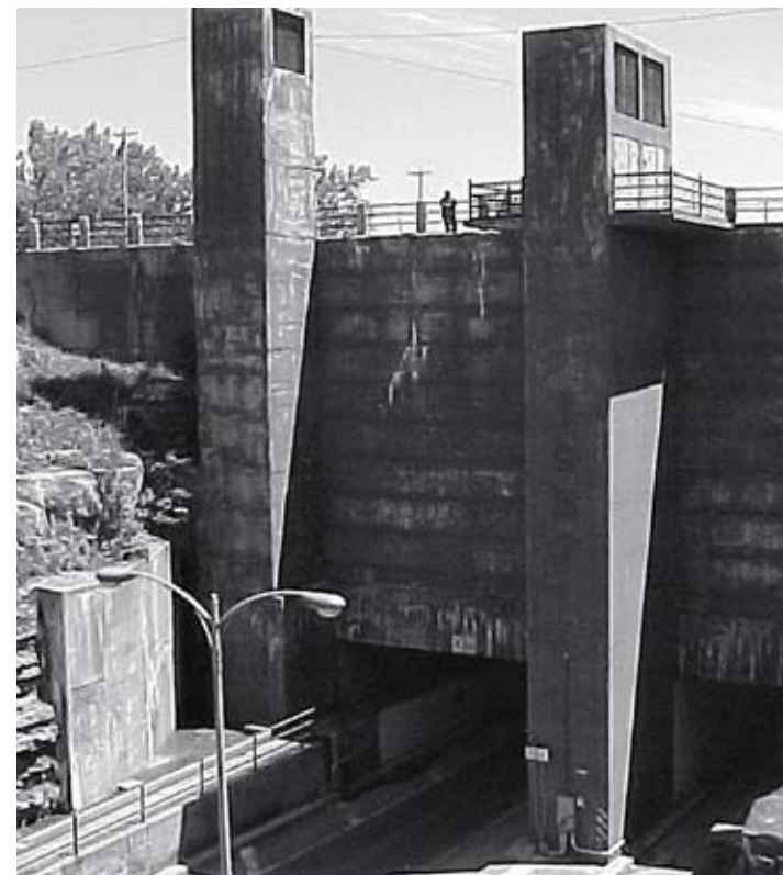
↑ Tunnel de Melocheville
