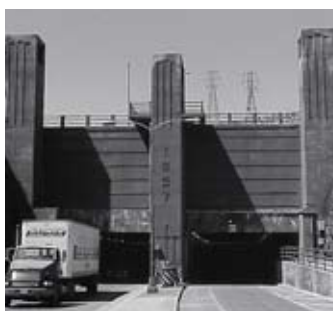
↑ Le tunnel de Melocheville
