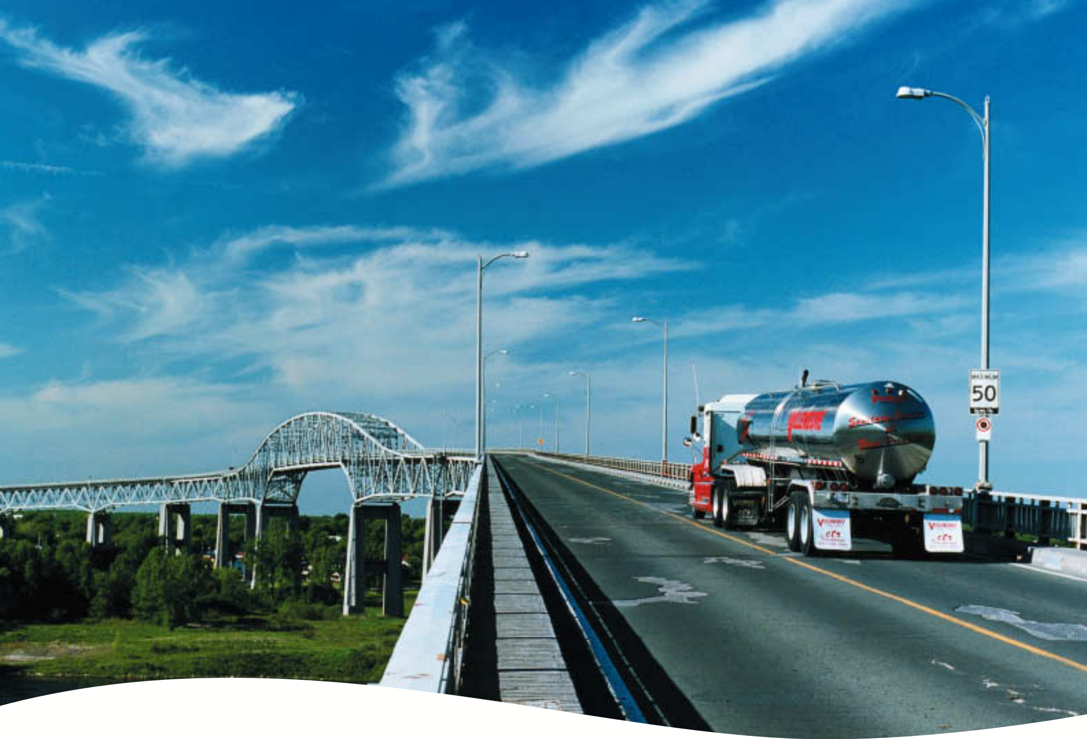
| PONT INTERNATIONAL DE LA VOIE MARITIME
