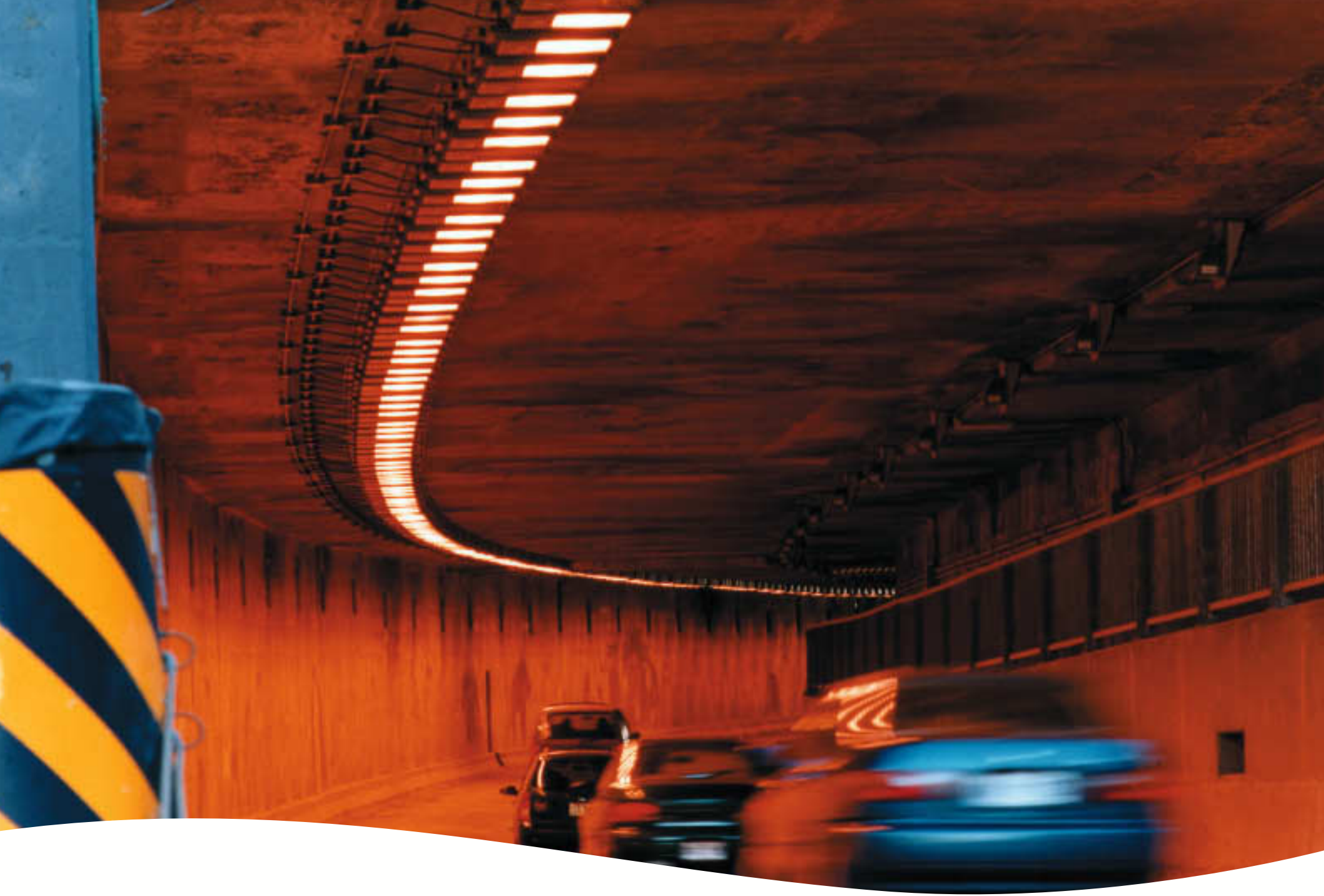
| TUNNEL DE MELOCHEVILLE
