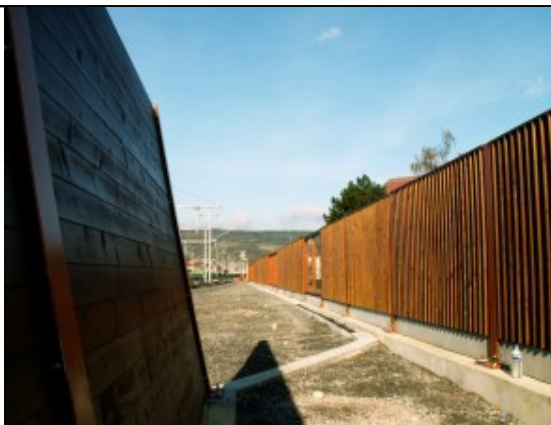
Pagny sur Moselle – Bois absorbant sur voie SNCF
