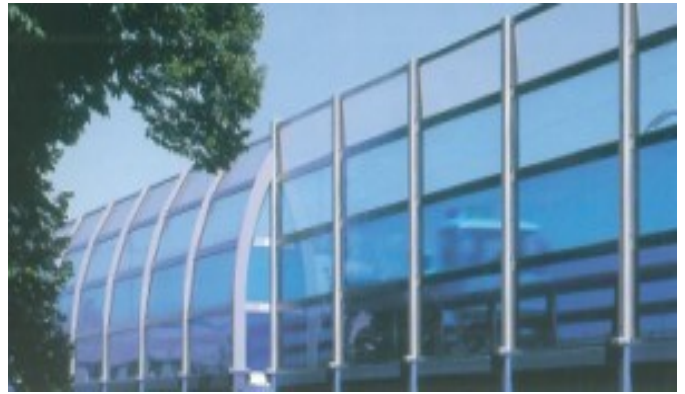
Plexiglas Soundstop GS différents tons de bleu Autoroute N 1, Morges ouest (Suisse)
