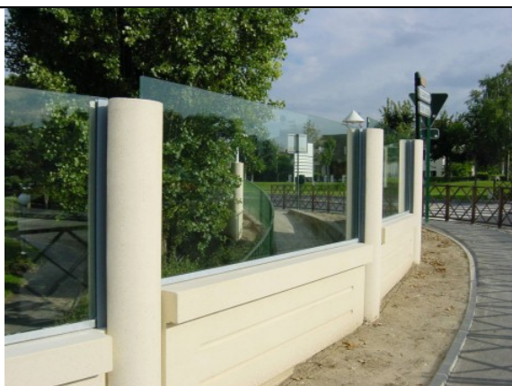
Taverny- transparent dans cadre béton
