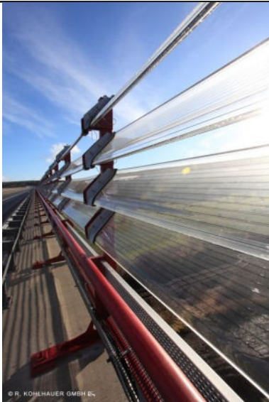
A71, Reichenbachtalbrücke-Ilmenau , lamelle CC
