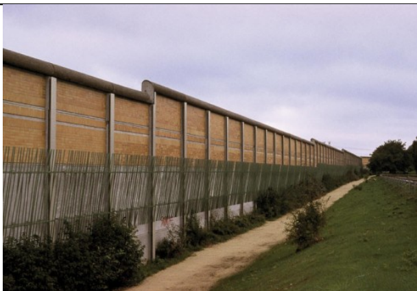
Lognes – Béton bois, habillage brique, et grille anti-vandalisme
