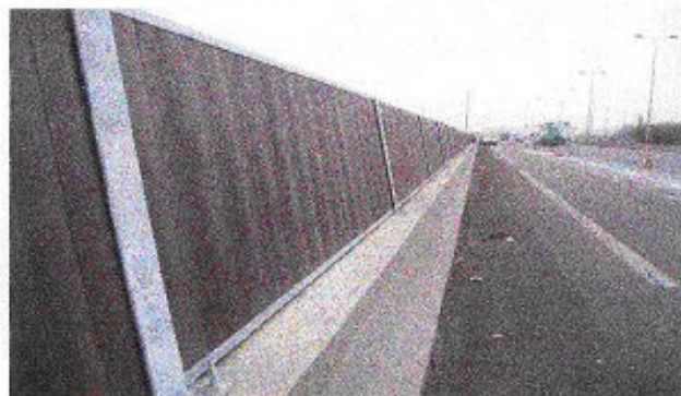
Ecran en plastique recyclé REFLECHISSANT
