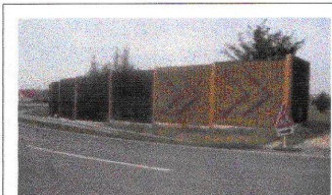
Ecran en plastique recyclé ABSORBANT
