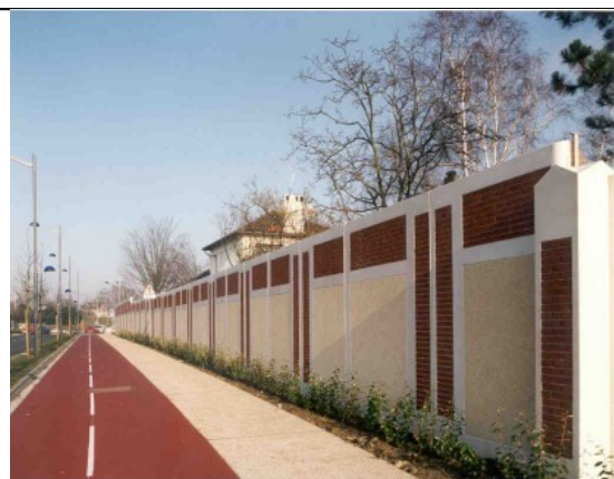
Saint Gratien – Ecran béton avec brique et gravillon lavé
