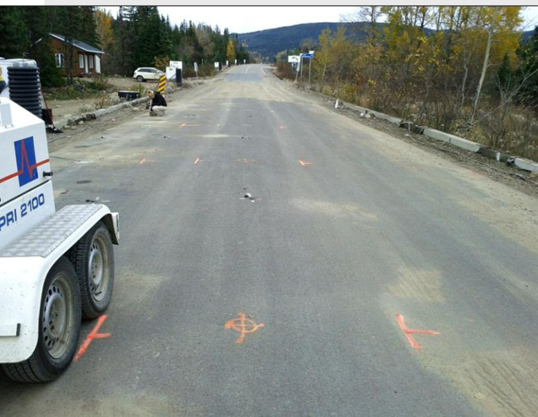
Photo 3) Maillage des mesures de récupération mécanique au FWD
