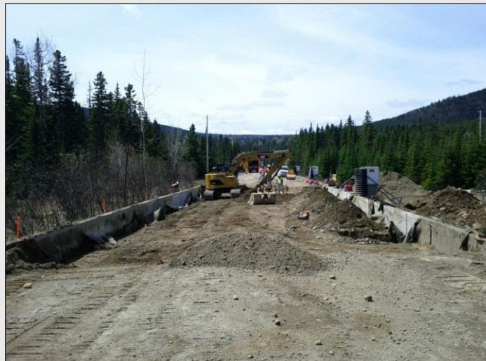
Photo 2) Vue globale de la fosse expérimentale (excavée jusqu'à l'infra)
