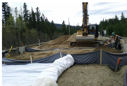
Installation de la nappe drainante placée dans 3 des 5 sections
