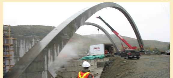
Pont d'étagement en arc (arcs en béton armé) intégré au projet de la route 175 dans Stoneham et Tewkesbury
