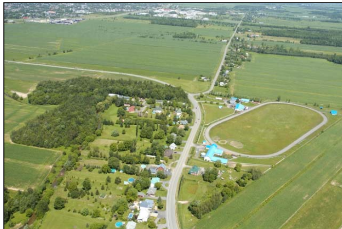
Vue aérienne du segment 1, dans le secteur du chemin de la Grande-Ligne, à Saint-Jean-sur-Richelieu, où passera l'autoroute 35.
