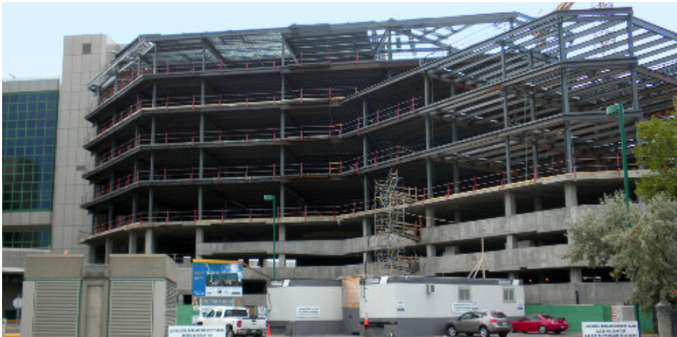
Le chantier de construction en date du 2 septembre 2010.
