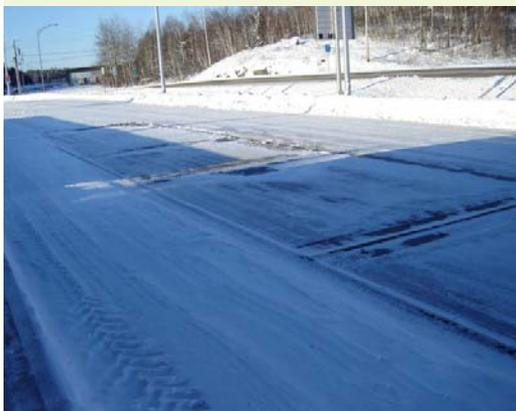
Chaque poste de contrôle routier est muni d'un plateau de pesée pour les véhicules lourds.
